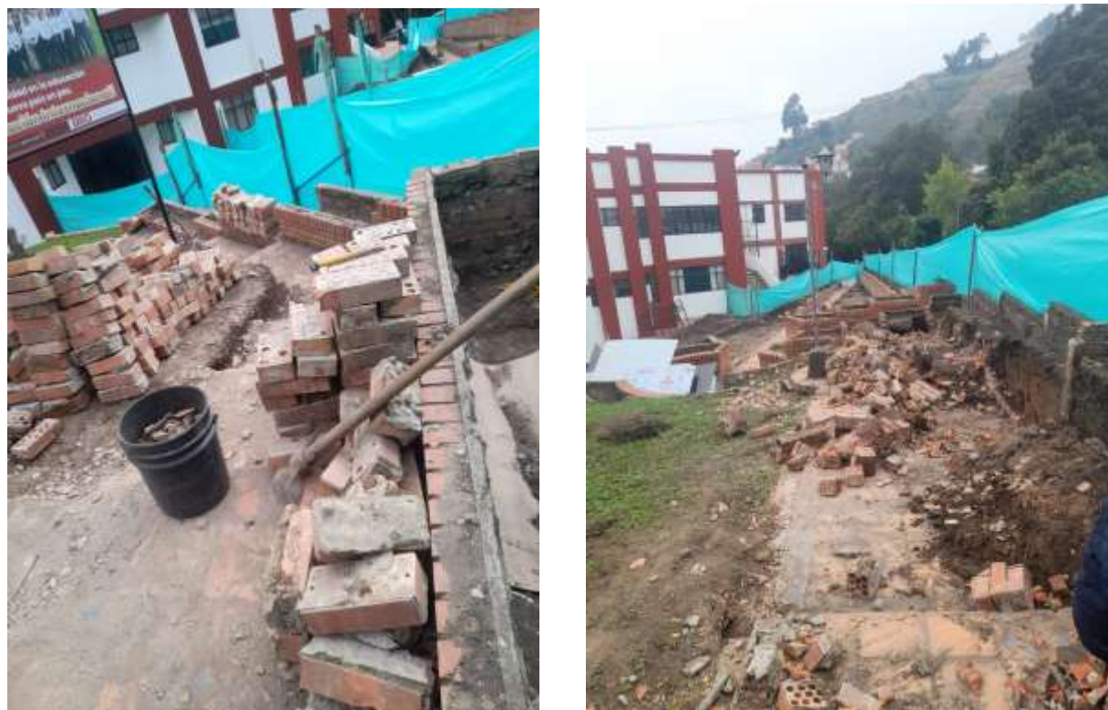
Ilustración 10 Demolición manual de jardineras en ladrillo
