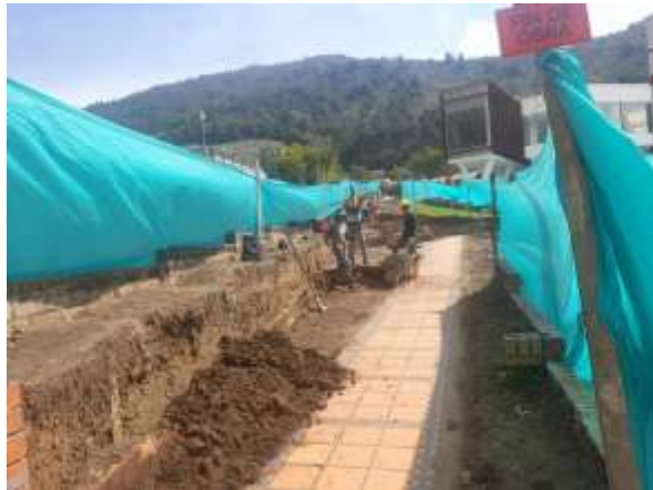
Ilustración 11 Demolición manual de jardineras en ladrillo
