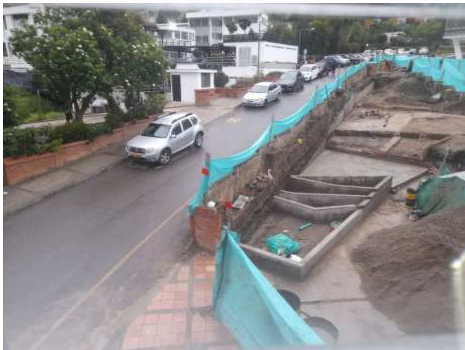
Ilustración 12 Estructura en concreto
