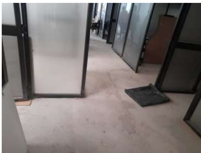
Ilustración 30 Retiro del piso laminado
