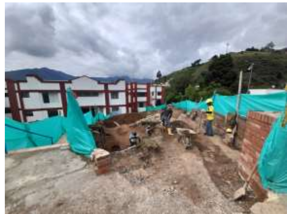
Ilustración 11 Demolición manual de jardineras en ladrillo
