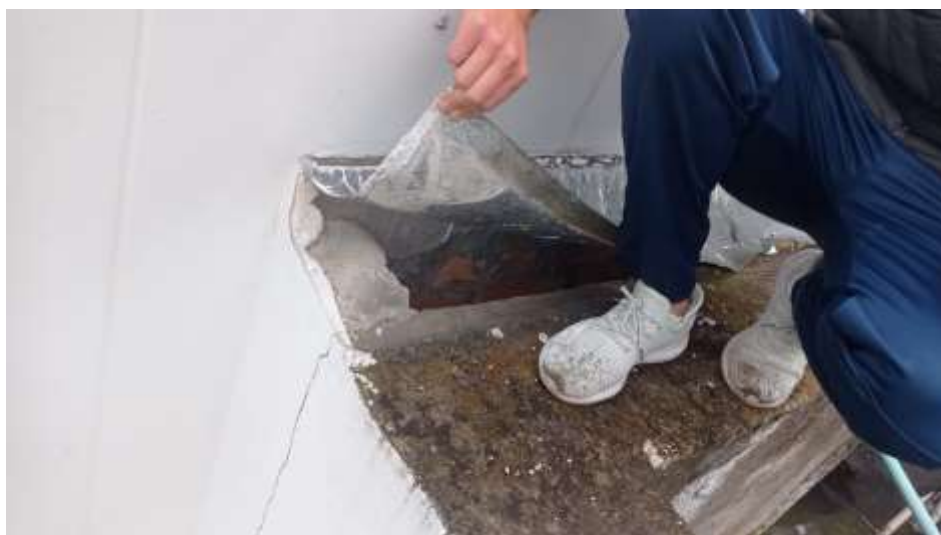
Ilustración 25 Manto Asfáltico
