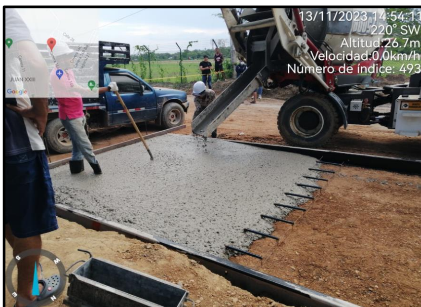
Ilustración 59. Aplicación del concreto.
