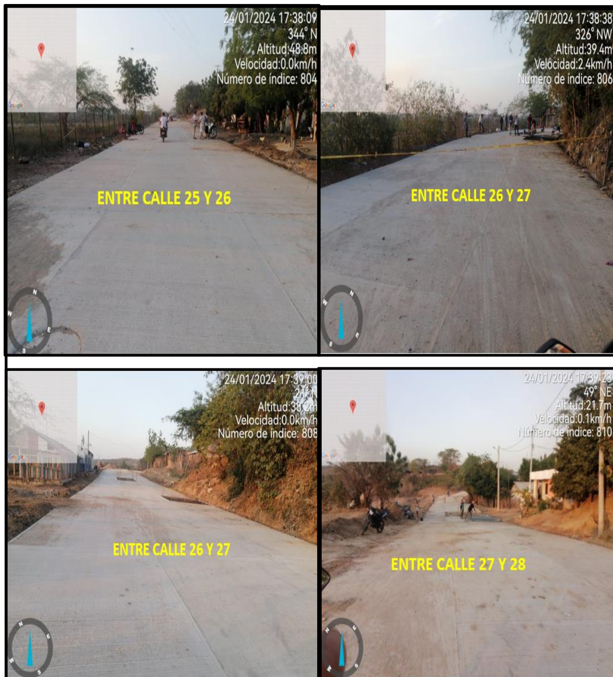
Ilustración 41. Tramo ejecutado hasta la culminación de las prácticas.
