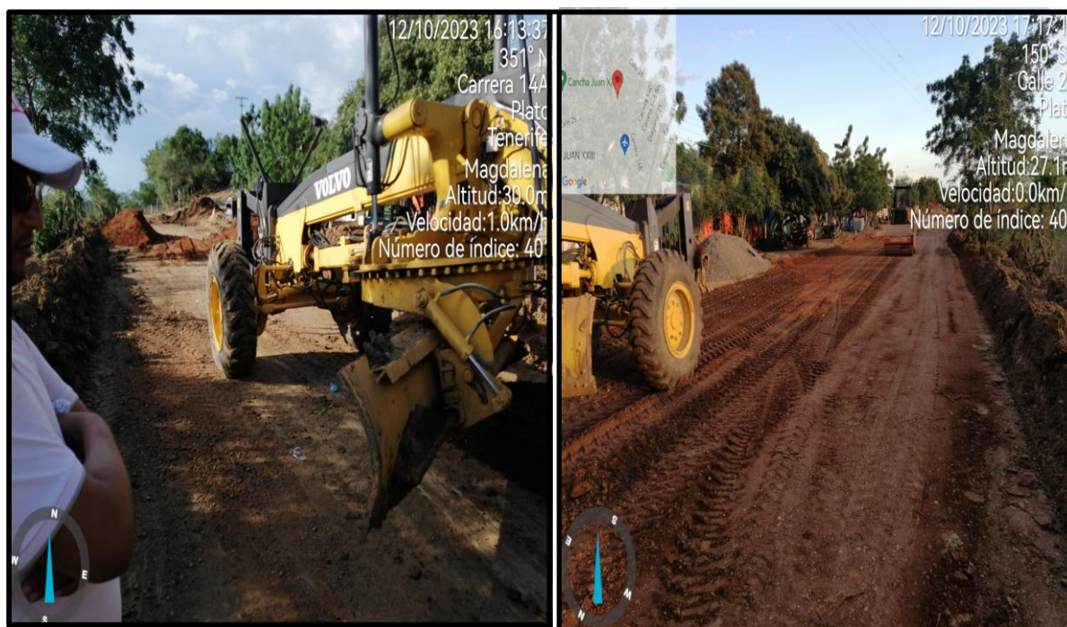
Ilustración 18. Suministro de material subbase granular tipo c (afirmado), extendido y compactación.
