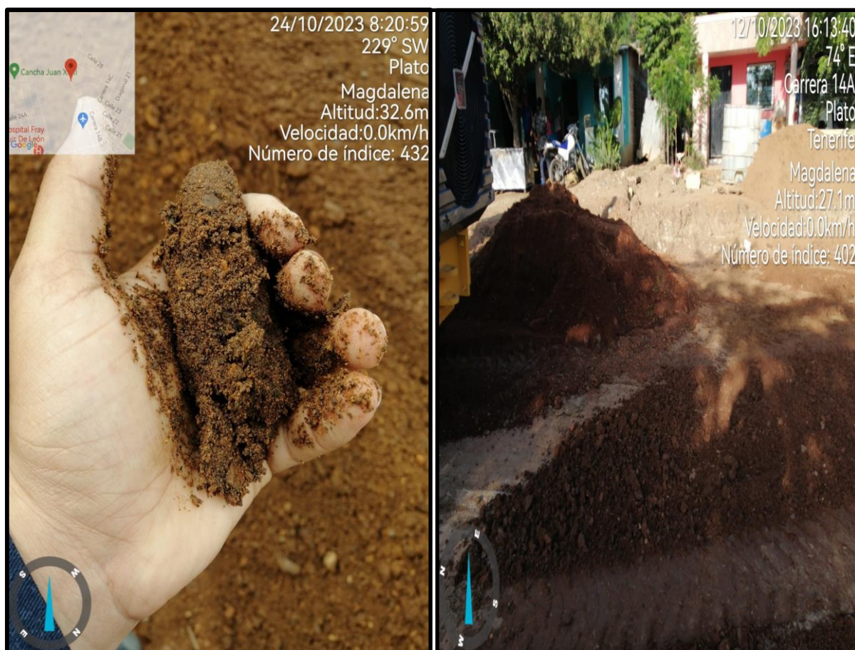
Ilustración 19. verificación de que el material granular contara con las propiedades requeridas.
