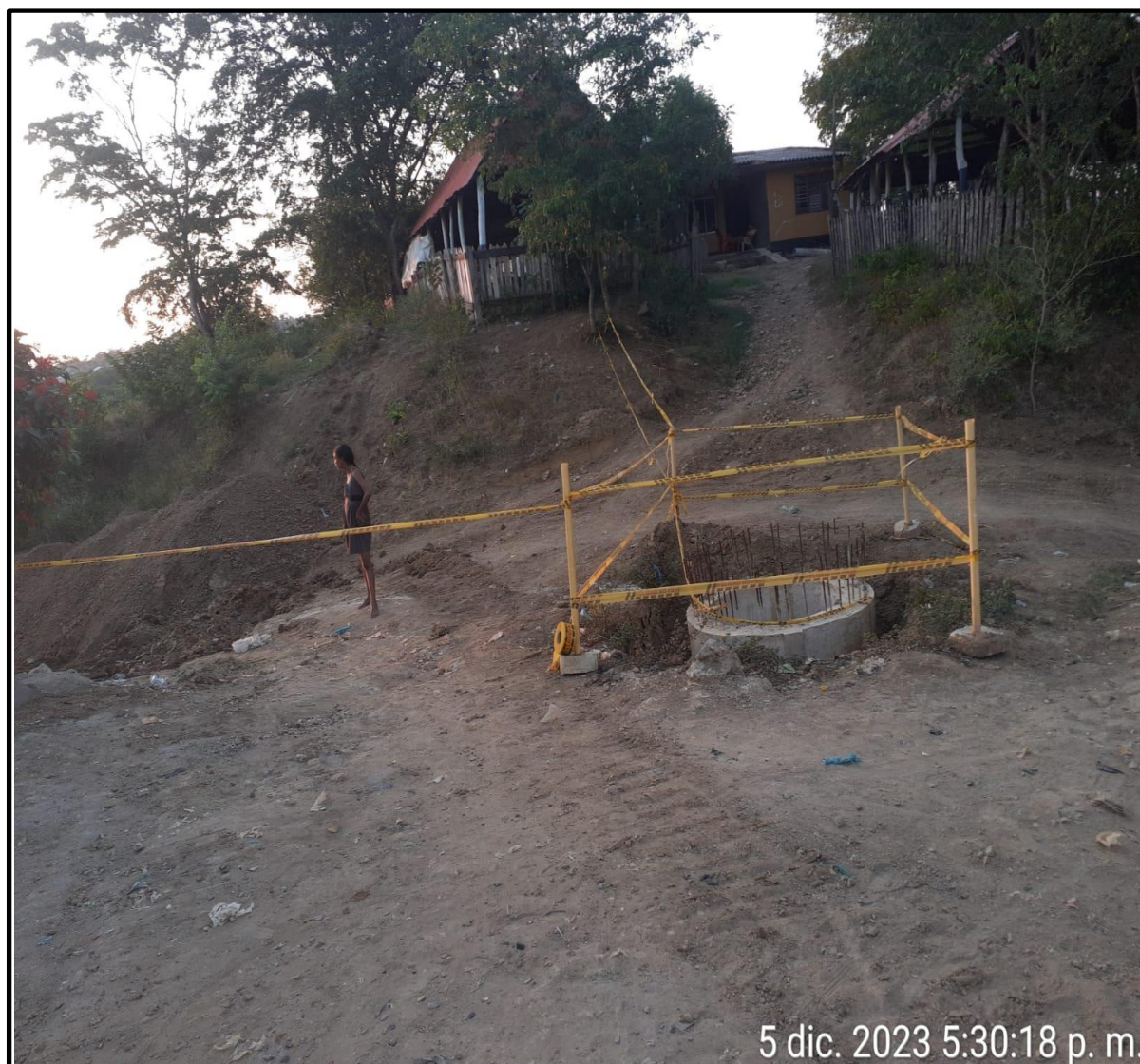
Ilustración 10. Cerramiento y señalización de obra.
