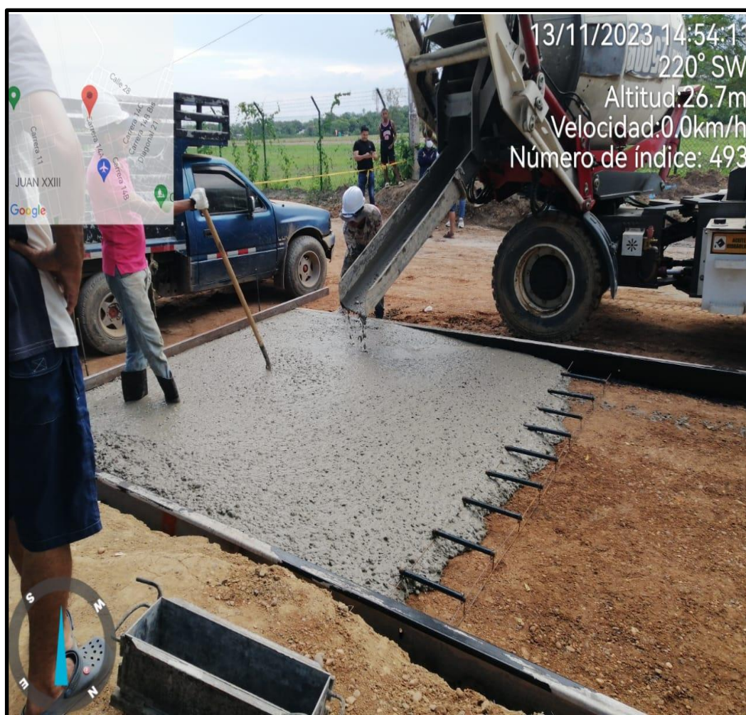
Ilustración 29. Colocación del concreto.
