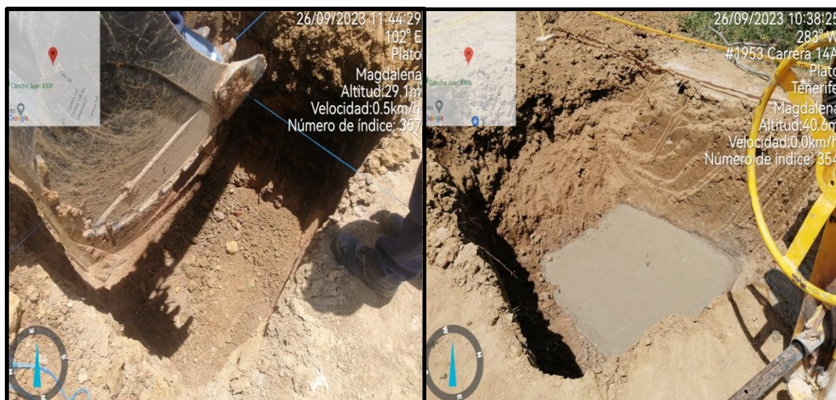
Ilustración 25. Excavación y fundida de solado para manjol
