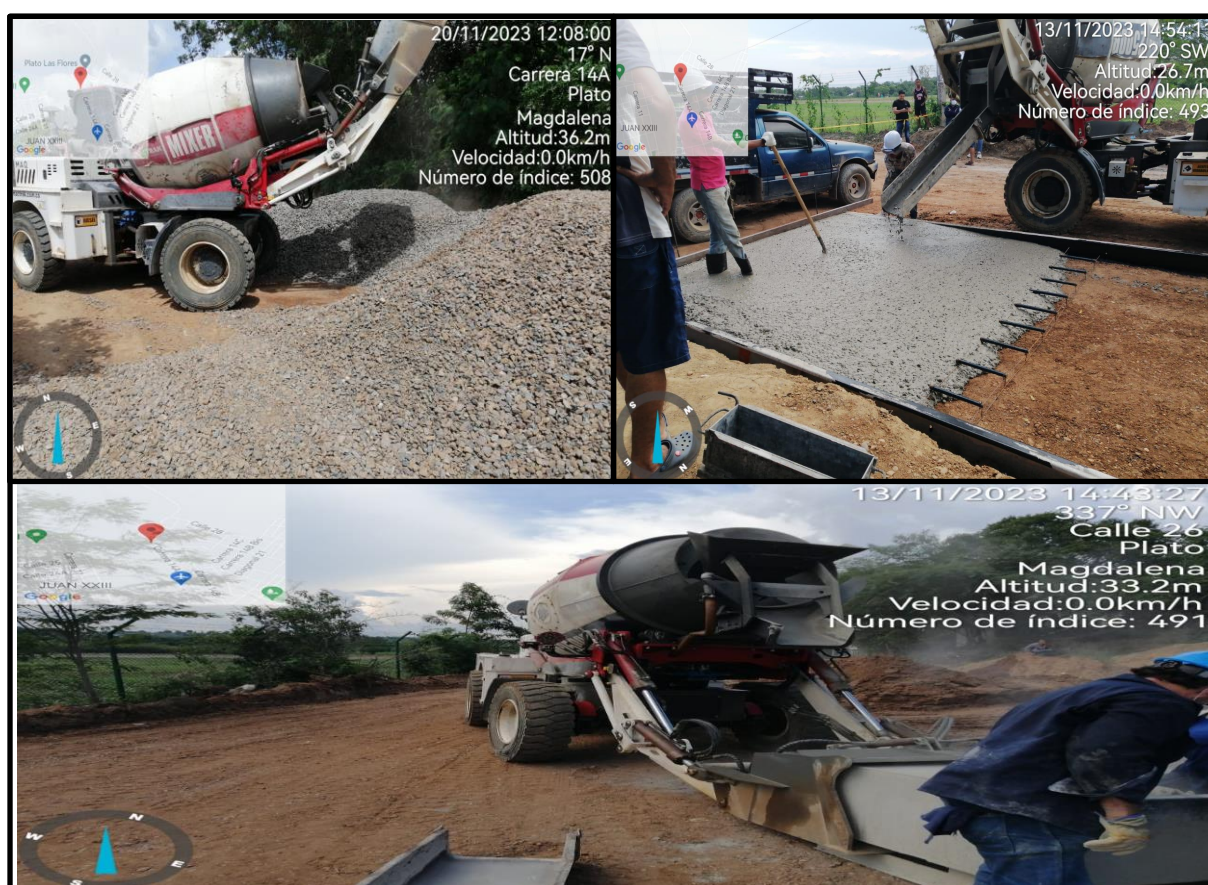
Ilustración 28. Proceso de fundida del concreto con la concreteira carmix,
