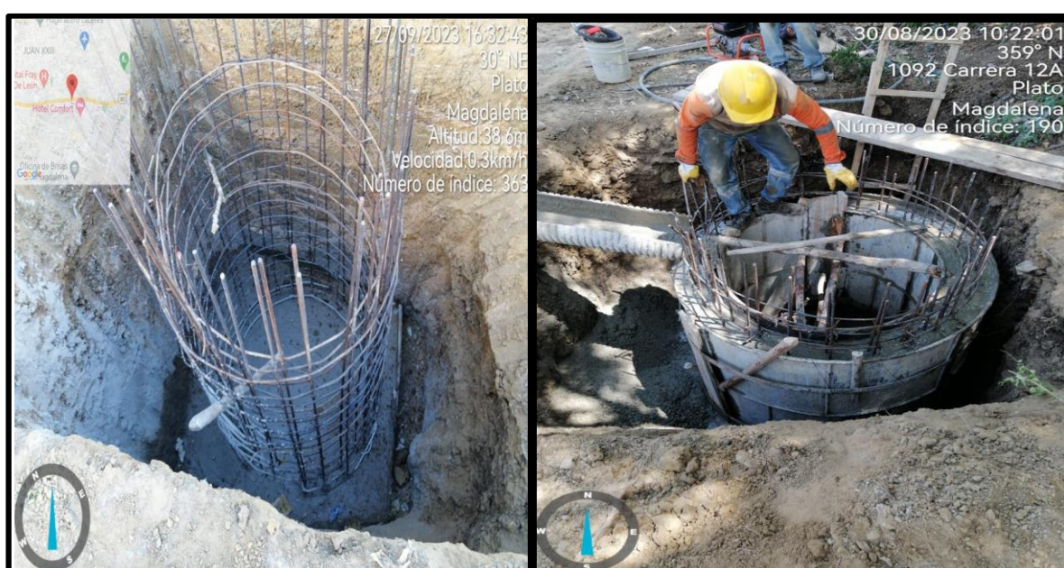
Ilustración 24. Construcción de manjoles.
