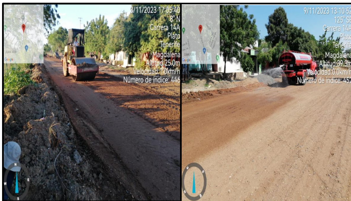
Ilustración 45. Vibrocompactador y carrotanque.
