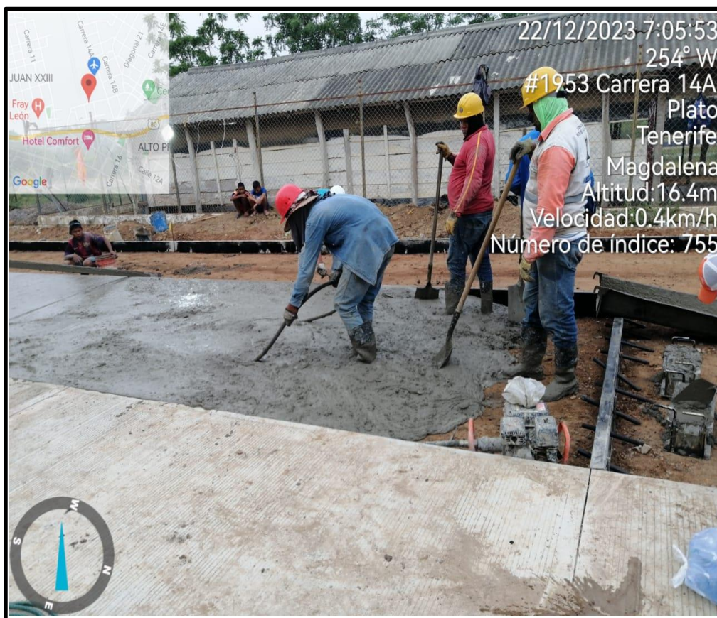
Ilustración 60. Realización del adecuado vibrado del concreto.
