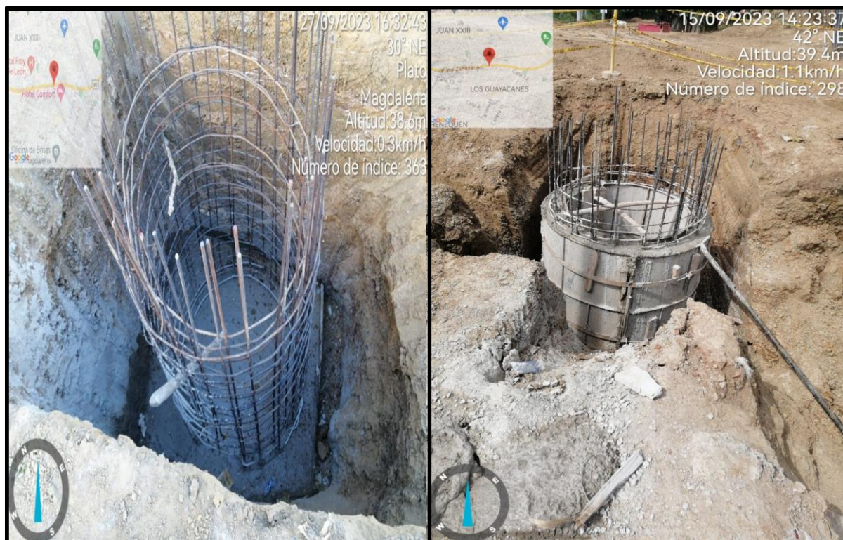
Ilustración 26. Fundida de base y Fundida de anillos de formaleta para pozos de inspección.
