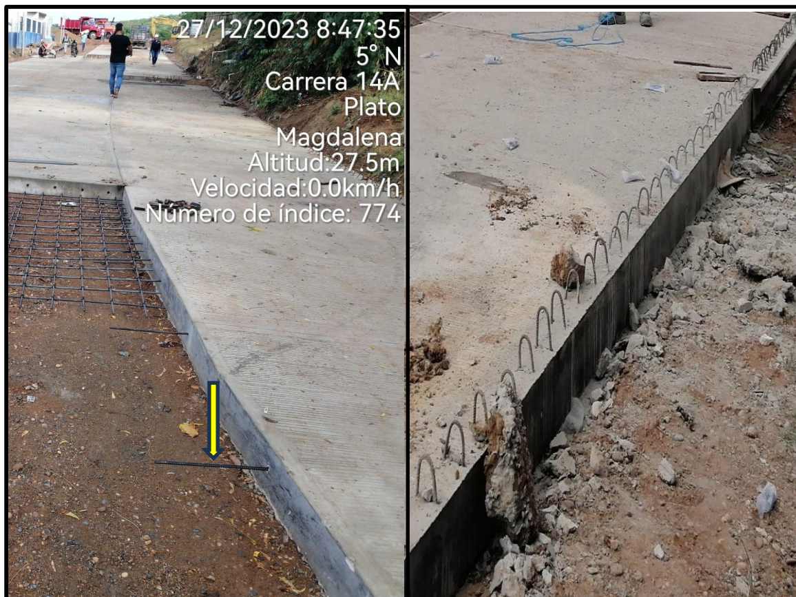
Ilustración 39. Acero de refuerzo transversal y bordillos.
