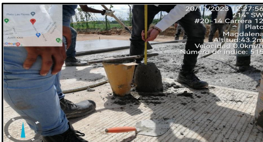
Ilustración 48. Medición del asentamiento.
