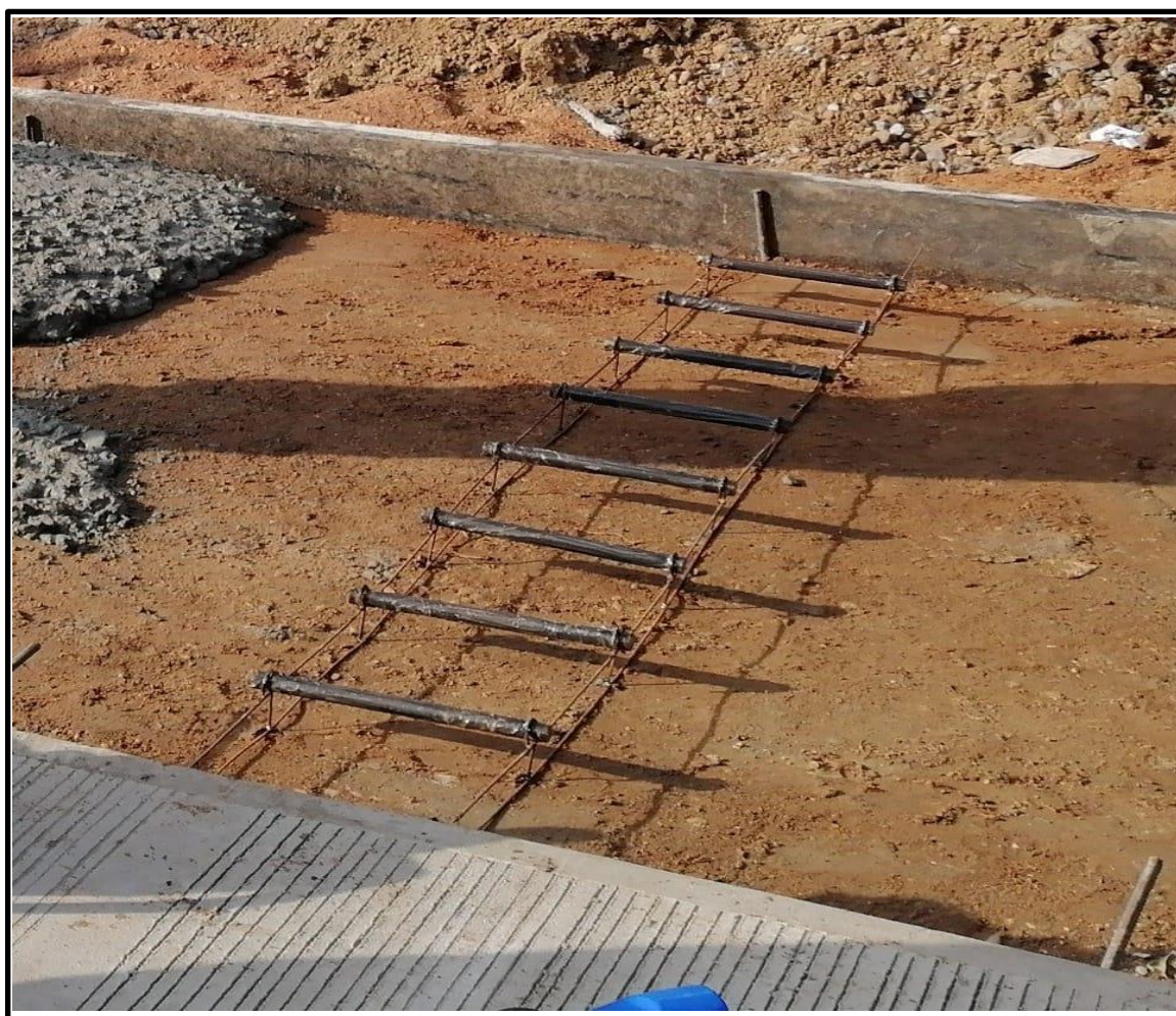
Ilustración 37. Dovelas y canastillas.
