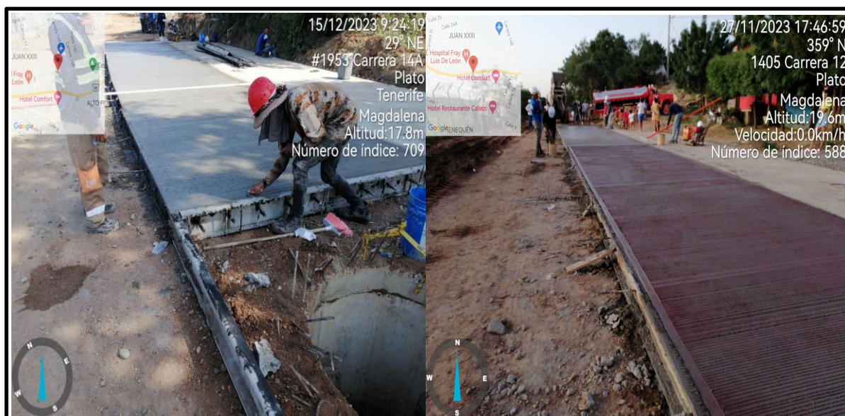
Ilustración 35. Aplicación del orillador y aplicado del anti-sol al concreto.
