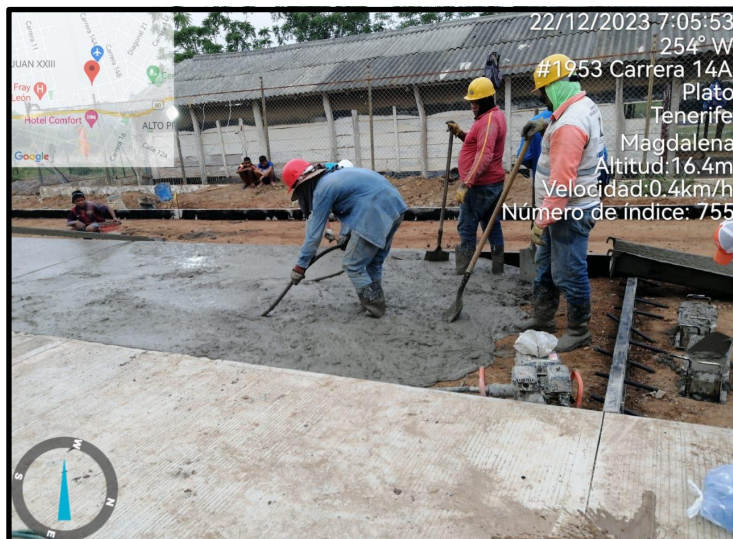
Ilustración 30. Vibrado del concreto.
