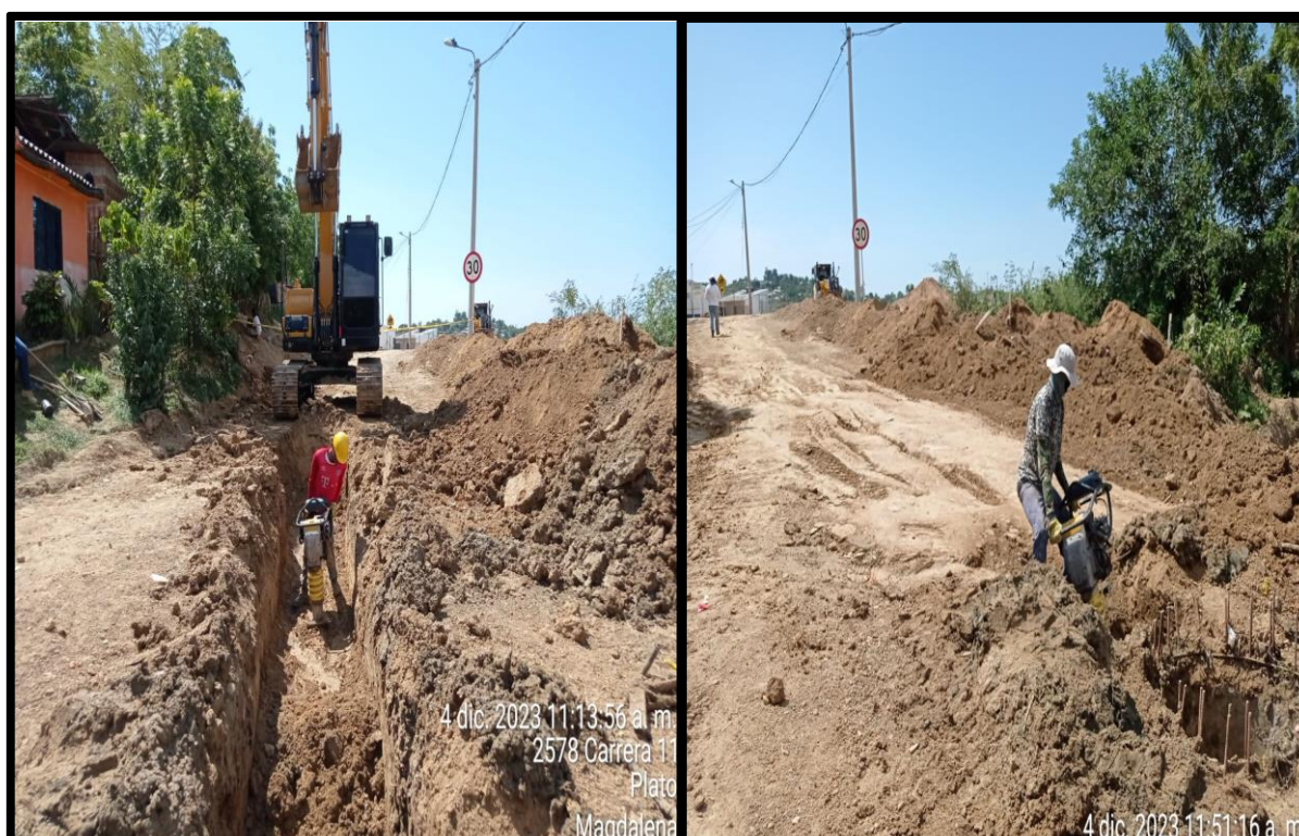
Ilustración 17. Relleno con material de la subrasante.
