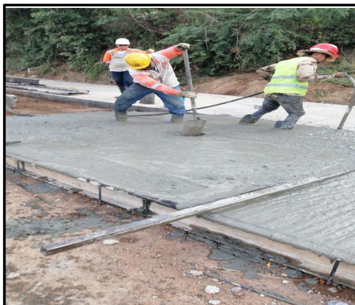
Ilustración 31. Extendido en el concreto.
