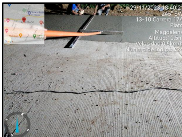
Ilustración 34. Aplicación del cepillo texturizador al concreto.
