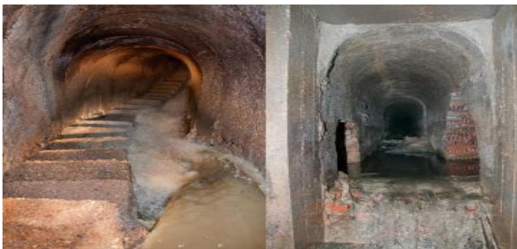
Figura 6. Imágenes del interior del alcantarillado
