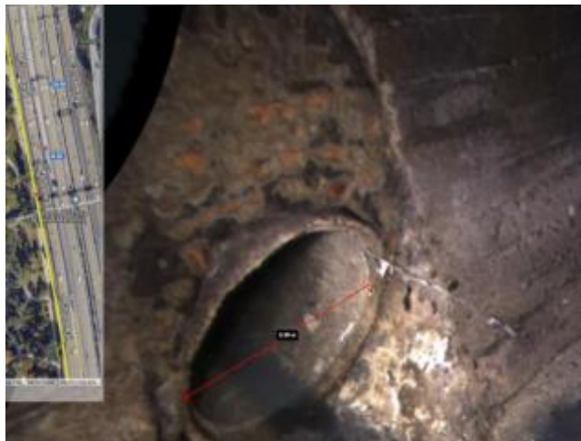
Figura 19. Imagen de medición de una acometida del colector inspeccionado
