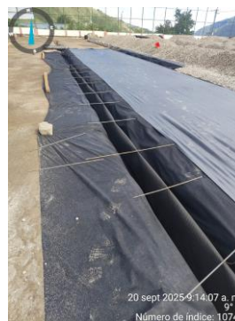
Suministro e instalación de geodren circular de 6"
