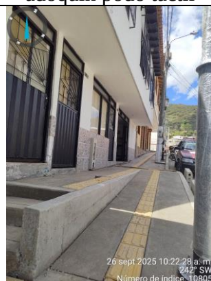
Instalación de placas podotáctiles
