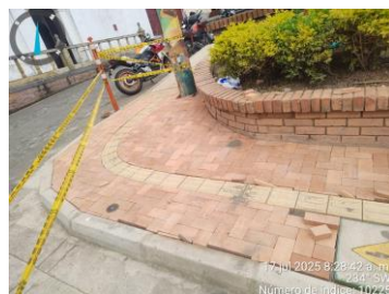
Avance primer corte
