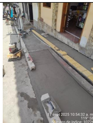
Placa contrapiso e instalación de adoquín podotáctil
