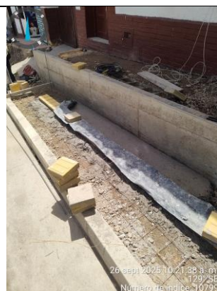
Construcción placa contrapiso
