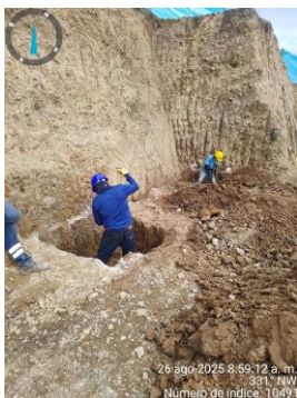
Excavación manual sin clasificar
