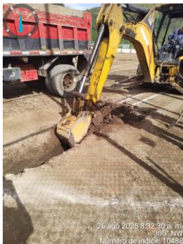
Excavación a máquina
