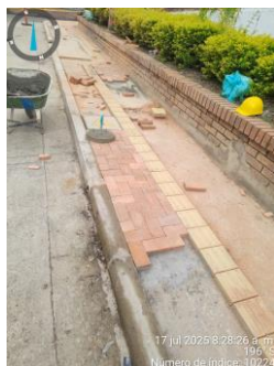
Avance primer corte
