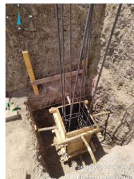
Pedestal en concreto 21 MPa
