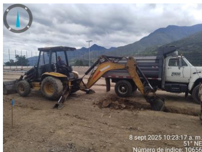
Excavación a máquina
