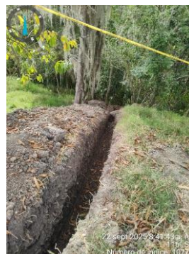
Excavación manual sin clasificar
