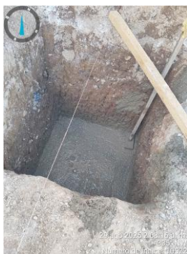
Suministro e Concreto ciclopeo 21 Mpa. Sección 100 \text{ cm}^2 \leq A \leq 150 \text{ cm}^2 de geotextil
