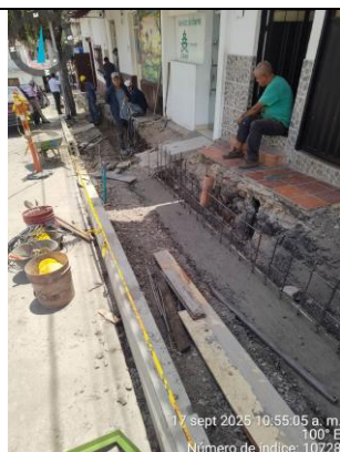
Muro de contención
