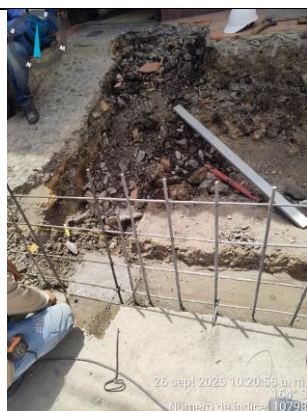
Muro de contención
