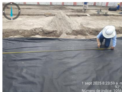
Suministro e instalación de geotextil
