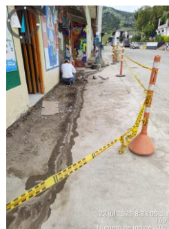
Actividades de demolición y excavación
