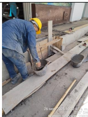
Instalación de bordillo
