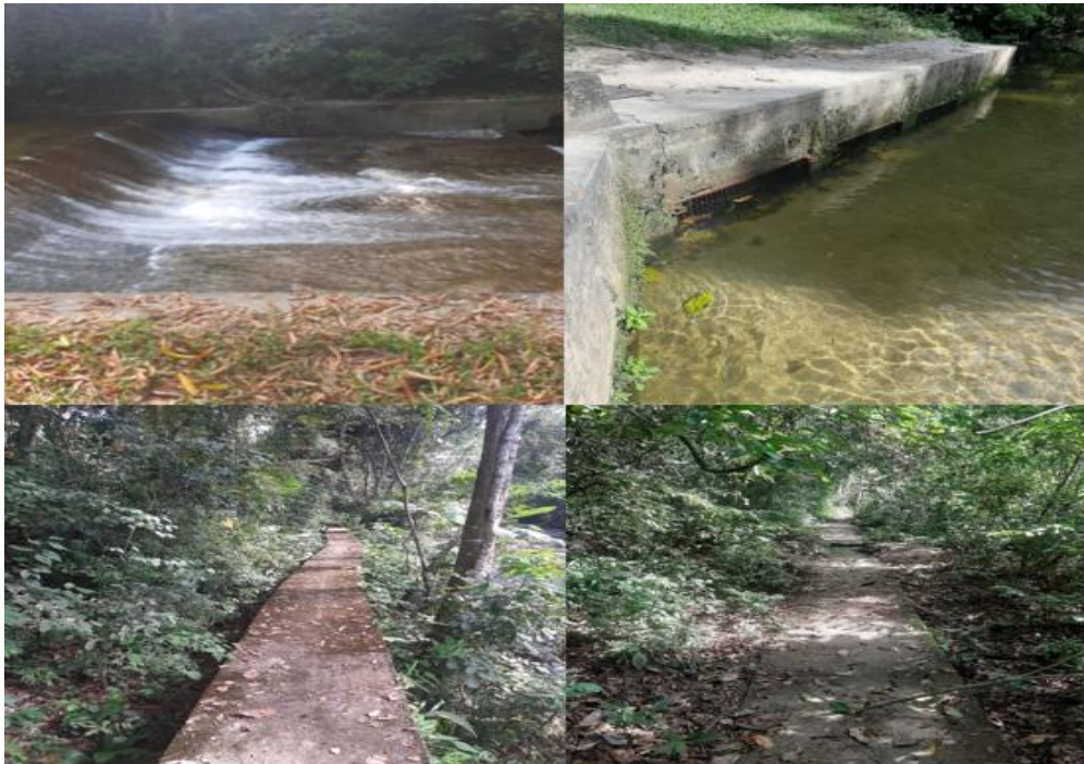
Figura 1. Bocatoma y canal de derivación EMCOPEY
