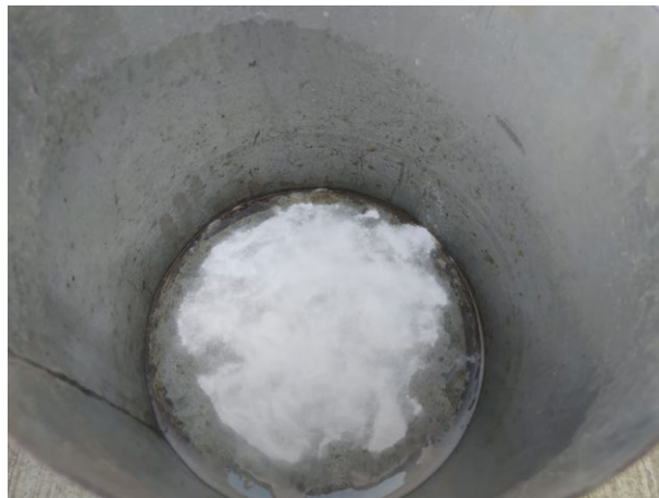
Figura 11. Aspersión y recubrimiento en la base del silo con Eco-Eff. (Fuente: propia 5-11-2022)
