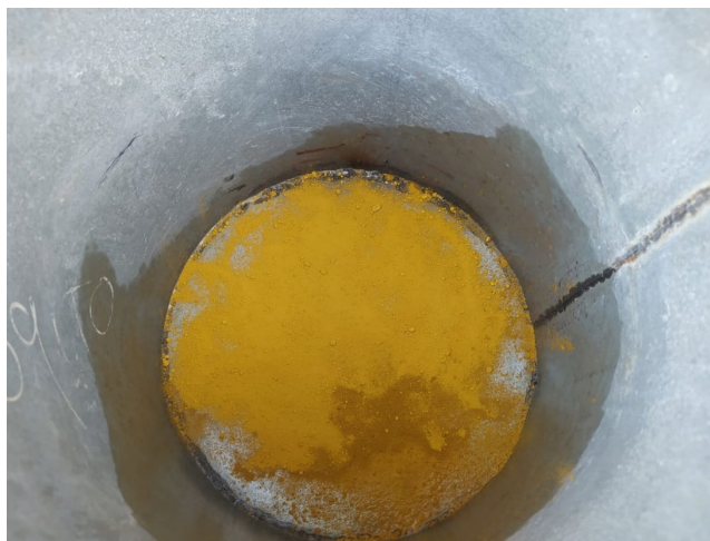
Figura 34 Aspersión y recubrimiento en la base del silo con F3.0 (Fuente: propia 5-11-2022)
