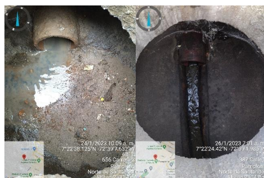
Ilustración 50 Pozos de inspección en profundidades entre 1.4 m a 2.0 m
