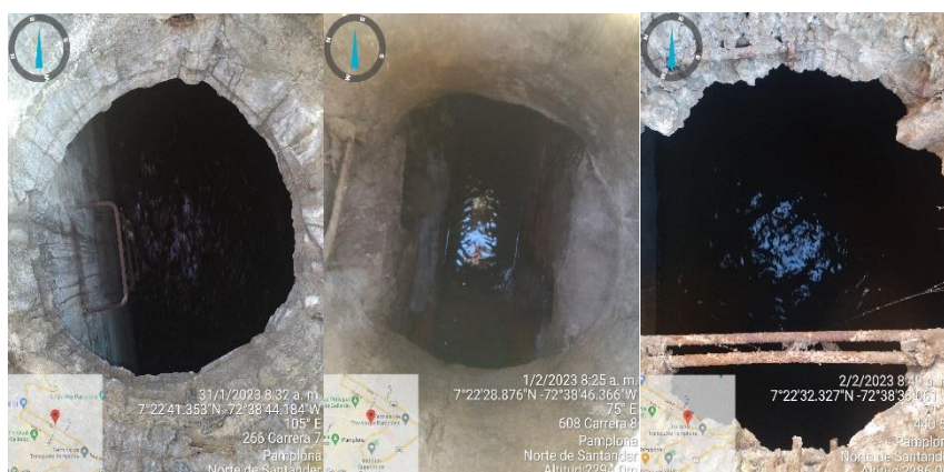
Ilustración 55 Pozos de inspección d Box Culvert
