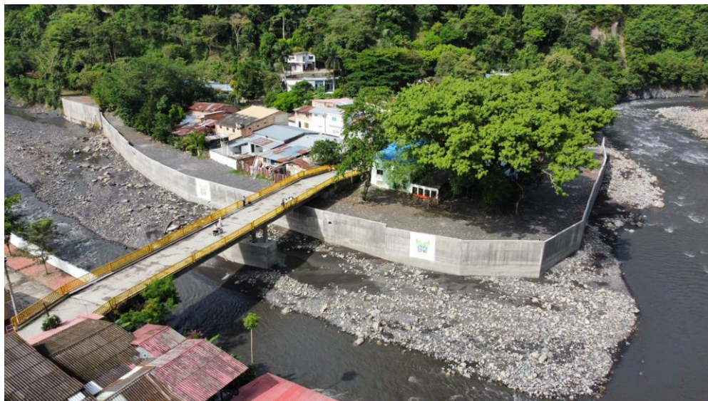
Ilustración 6. Muro de contención sobre los ríos Tobia y Negro, Nimaima, Colombia
