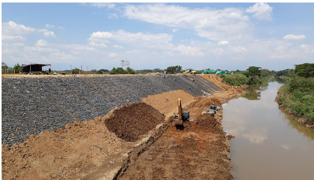
Ilustración 5. Dique a la orilla del Canal Interceptor Sur y del río Cauca, Cali, Colombia
