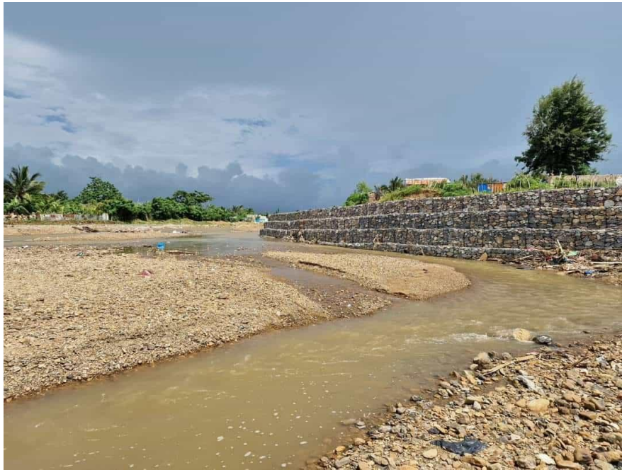
Ilustración 7. Muro de gaviones
