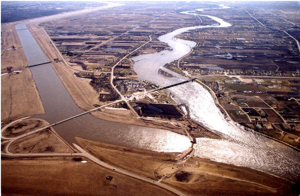
Ilustración 9. Canal de derivación en el “Red river”, Alberta, Canadá
