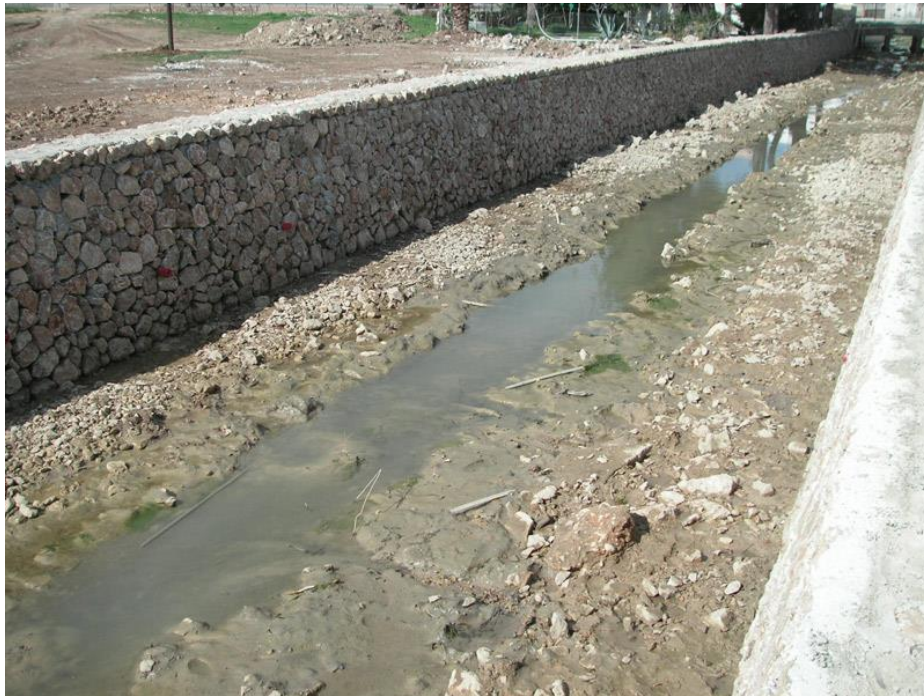
Ilustración 10. Encauzamiento de un arroyo, Mallorca, España
