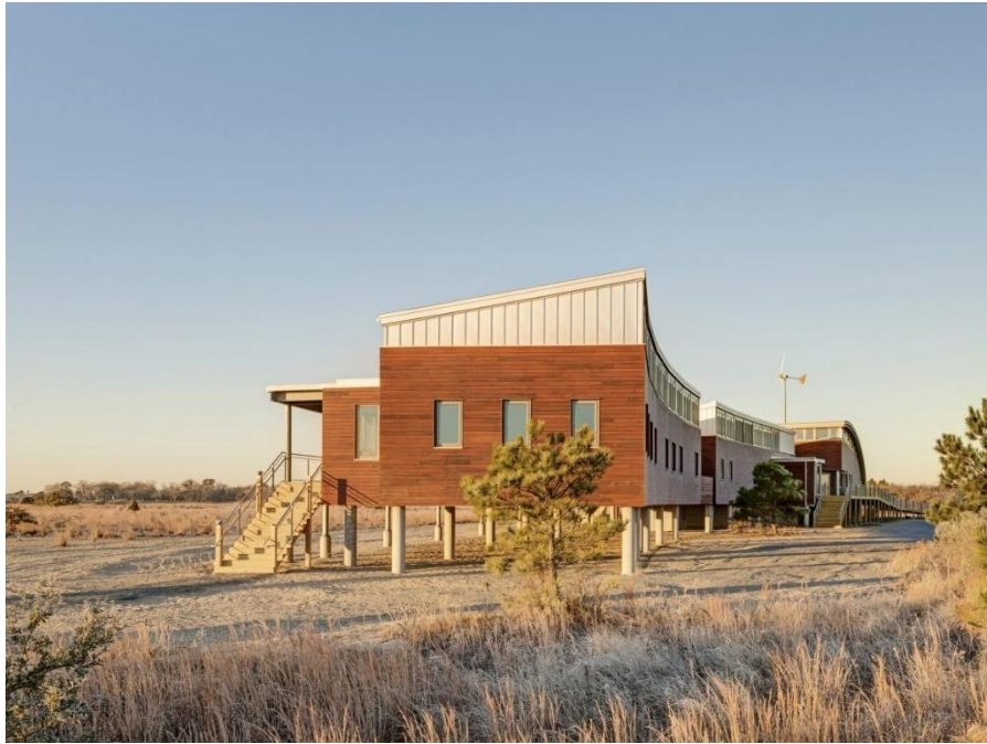
Ilustración 16. Centro Ambiental Brock, Virginia, US
