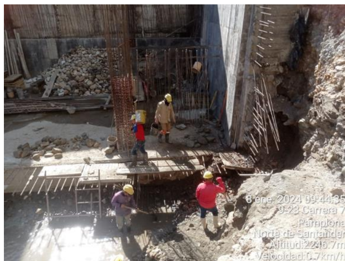
Figura 8. Excavación de Tierra.
