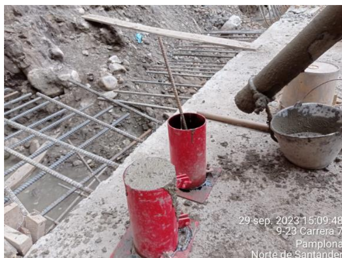
Figura 28. Elaboración de cilindros para ensayos.
