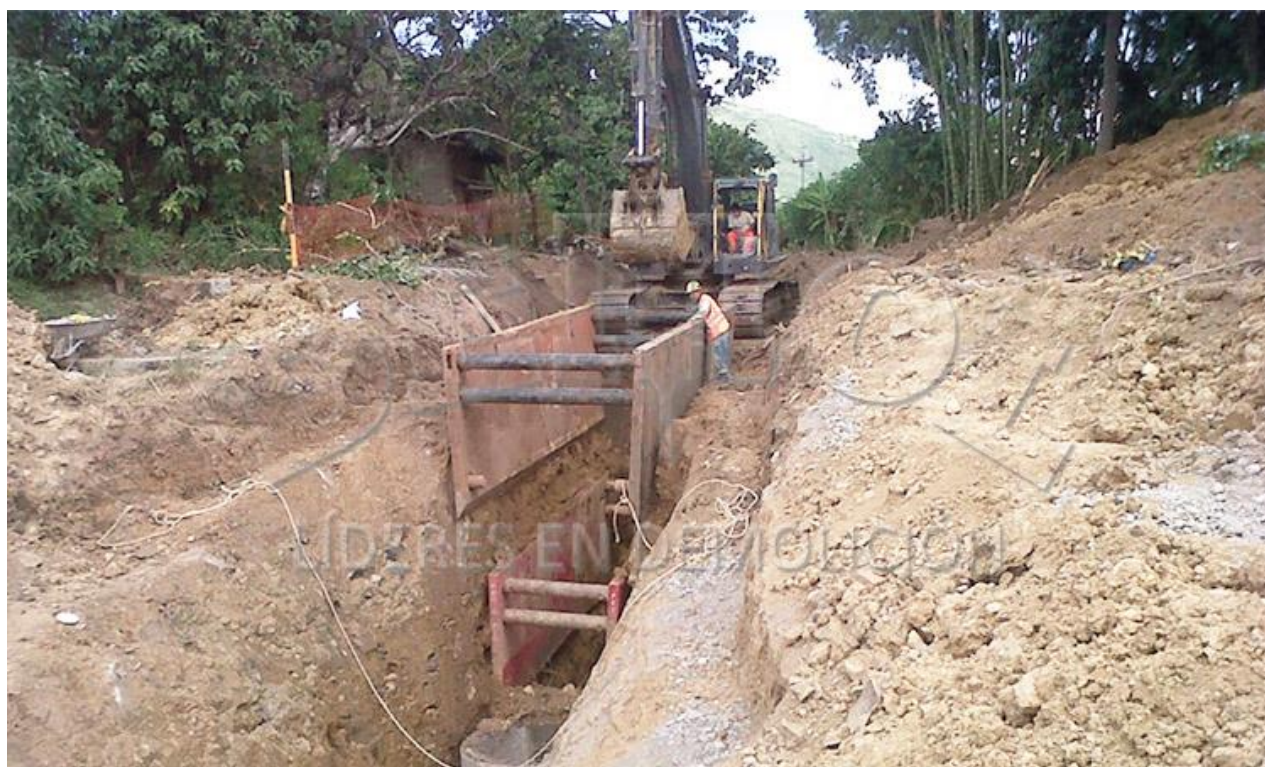
Ilustración 26. Excavación con entibados.
