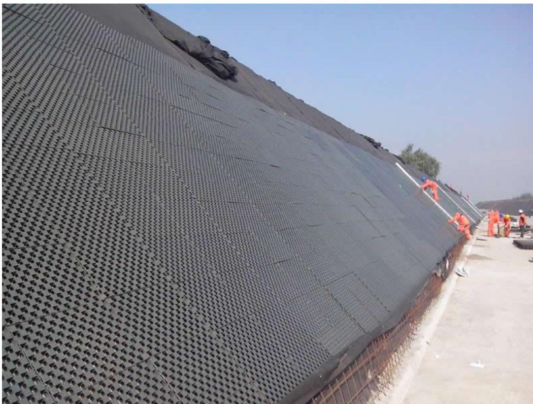
Ilustración 31. Canal cubierto con geomalla.
