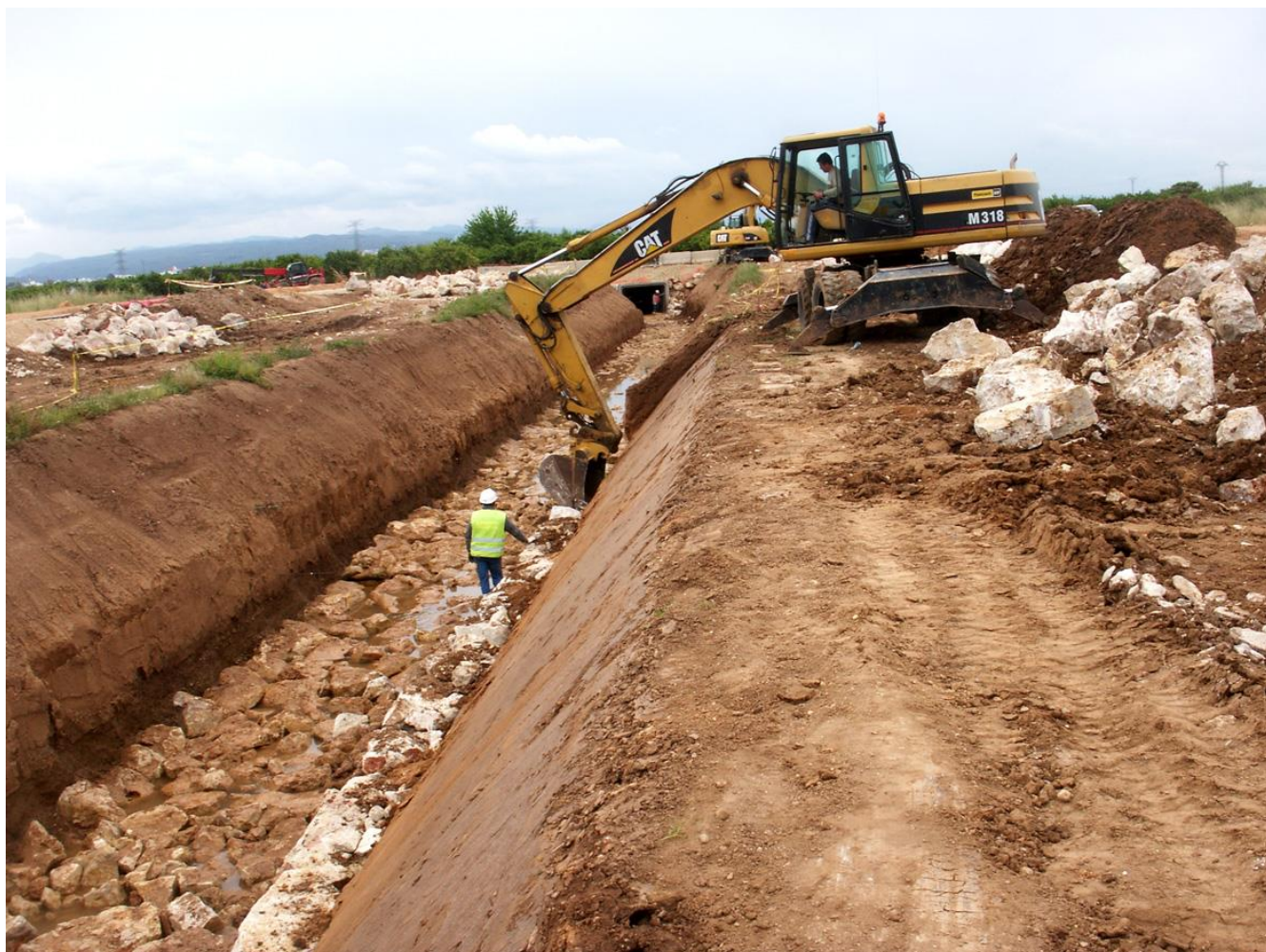
Ilustración 27. Estabilización de taludes en n canal.
