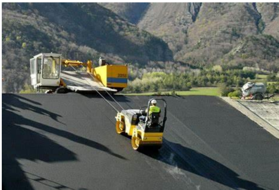
Ilustración 28. Compactación de un talud.
