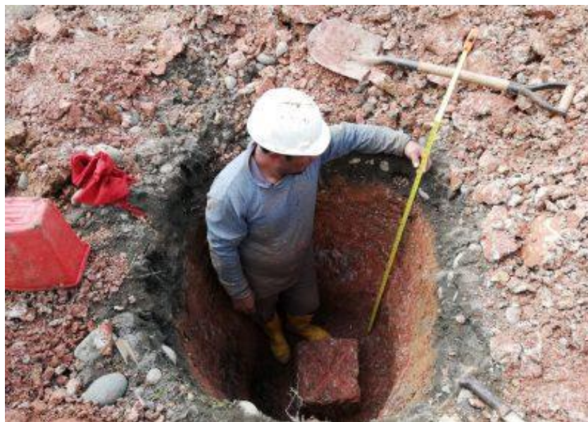
Ilustración 23. Estudios de mecánica de suelos, geotecnia.
