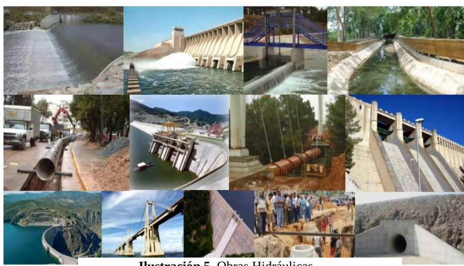
Ilustración 5. Obras Hidráulicas Fuente: (Cerero, 2014)
