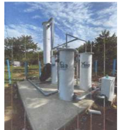
Instalación de planta de tratamiento de agua.
