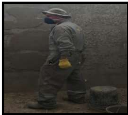
Figura 37. Uso de botas de seguridad en obra
