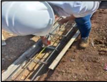
Figura 4. Viga de arrastre.
