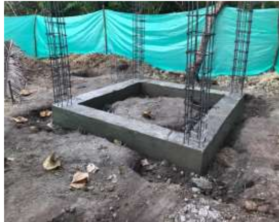
Vigas de 0,30 m x 0,30m x 2,50 m por cada lado.
