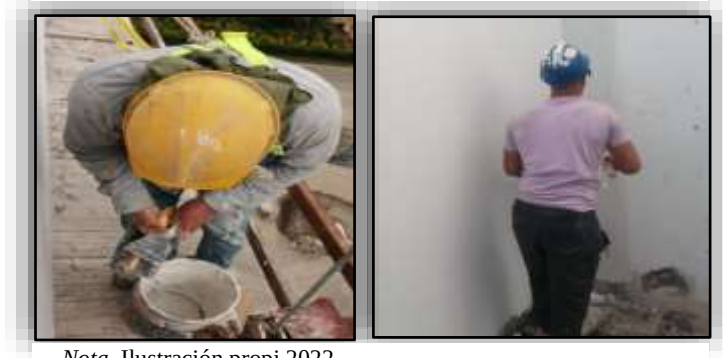
Figura 31. Aplicación de estuco y pintura
