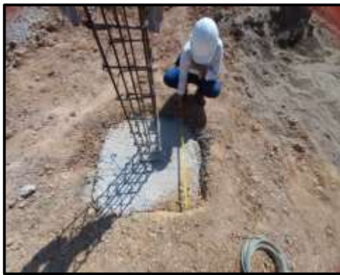
Figura 5. Rectificación medida zapatas
