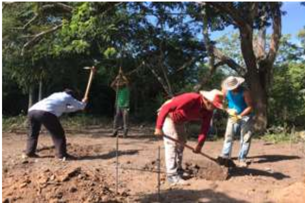
Figura 8, Excavación e instalación de acero
