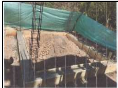
Figura 29. Construcción de caseta.
