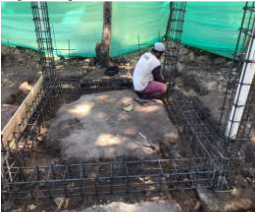
Instalación de hierro de viga de arrastre.
