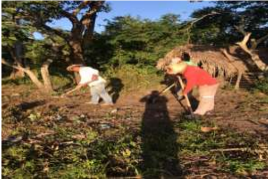
Figura 7. Limpieza y descapote
