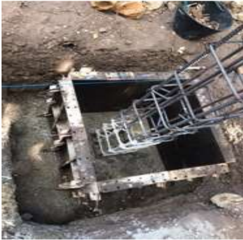
Formaletas de pedestal.
