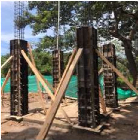
Encoframiento de columnas de 2,70 m.
