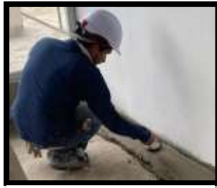
Figura 35. Uso de casco en obra
