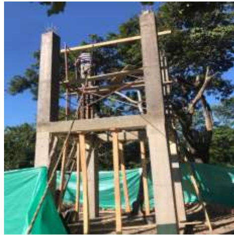
Columnas desencofradas.
