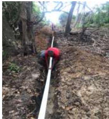
Figura 13, Instalación de tubería de conducción y distribución
