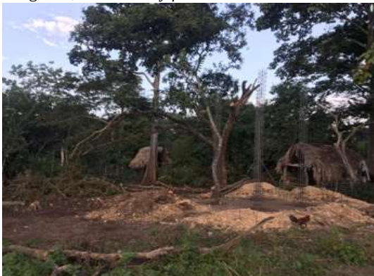
Figura 9, Instalación y fundición
