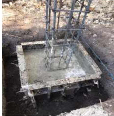
Fundición de pedestal.
