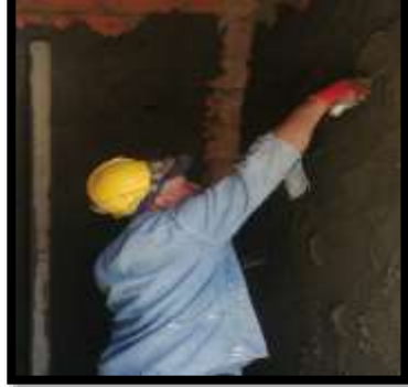
Figura 32. Aplicación de concreto en obra
