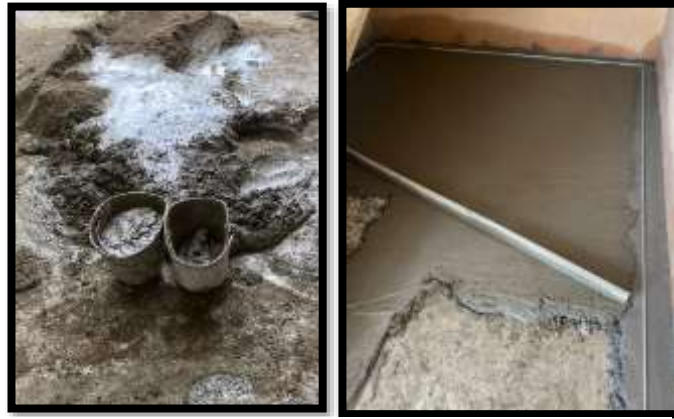
Figura. Fundición ante piso en mortero
