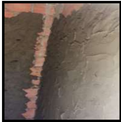
Figura. Pañete de muro
