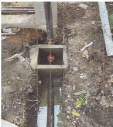
Instalación de tubería AC3", válvula de compuerta de 3".
