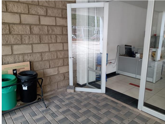
figura 92 Zona junto a la puerta principal de ingreso
