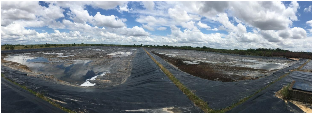
Ilustración 15 lagunas facultativas, fuente propia
