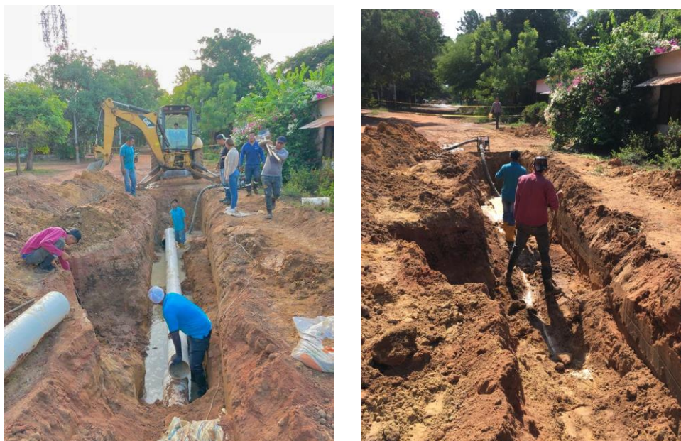
Ilustración 20 Reparación de la línea de impulsión, fuente propia
