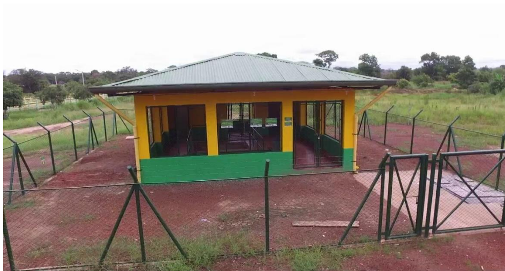
Ilustración 5 estación de bombeo occidental, fuente gobernación de Vichada
