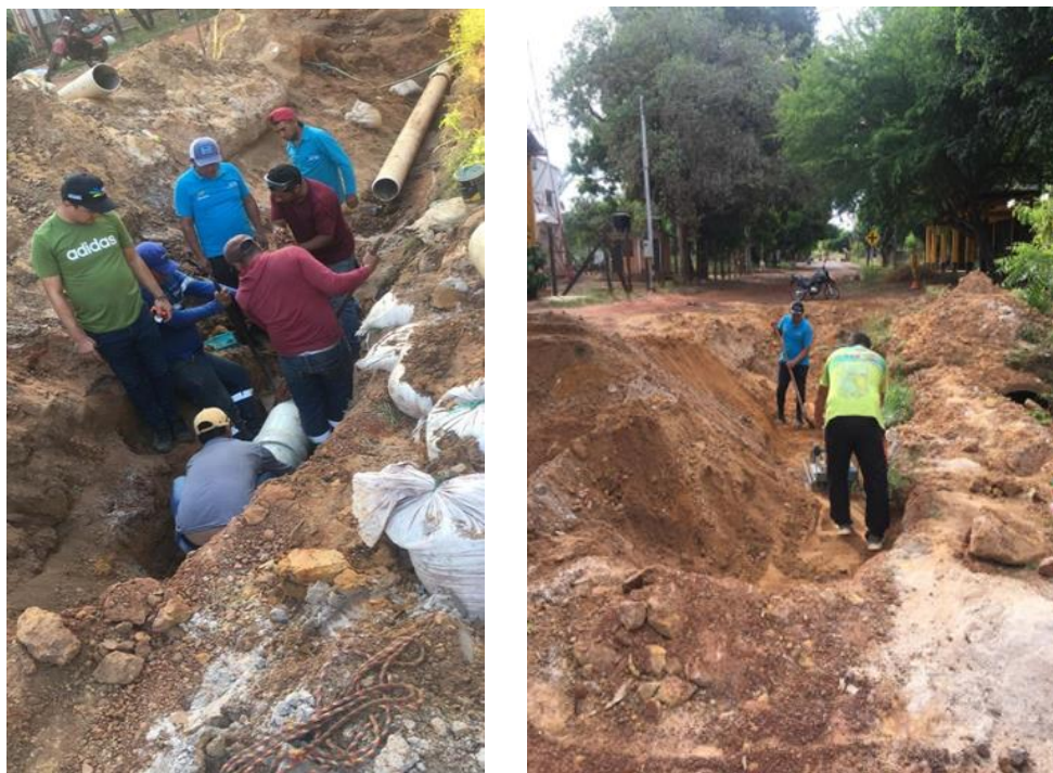
Ilustración 18 Reparación de la línea de impulsión, fuente propia.
