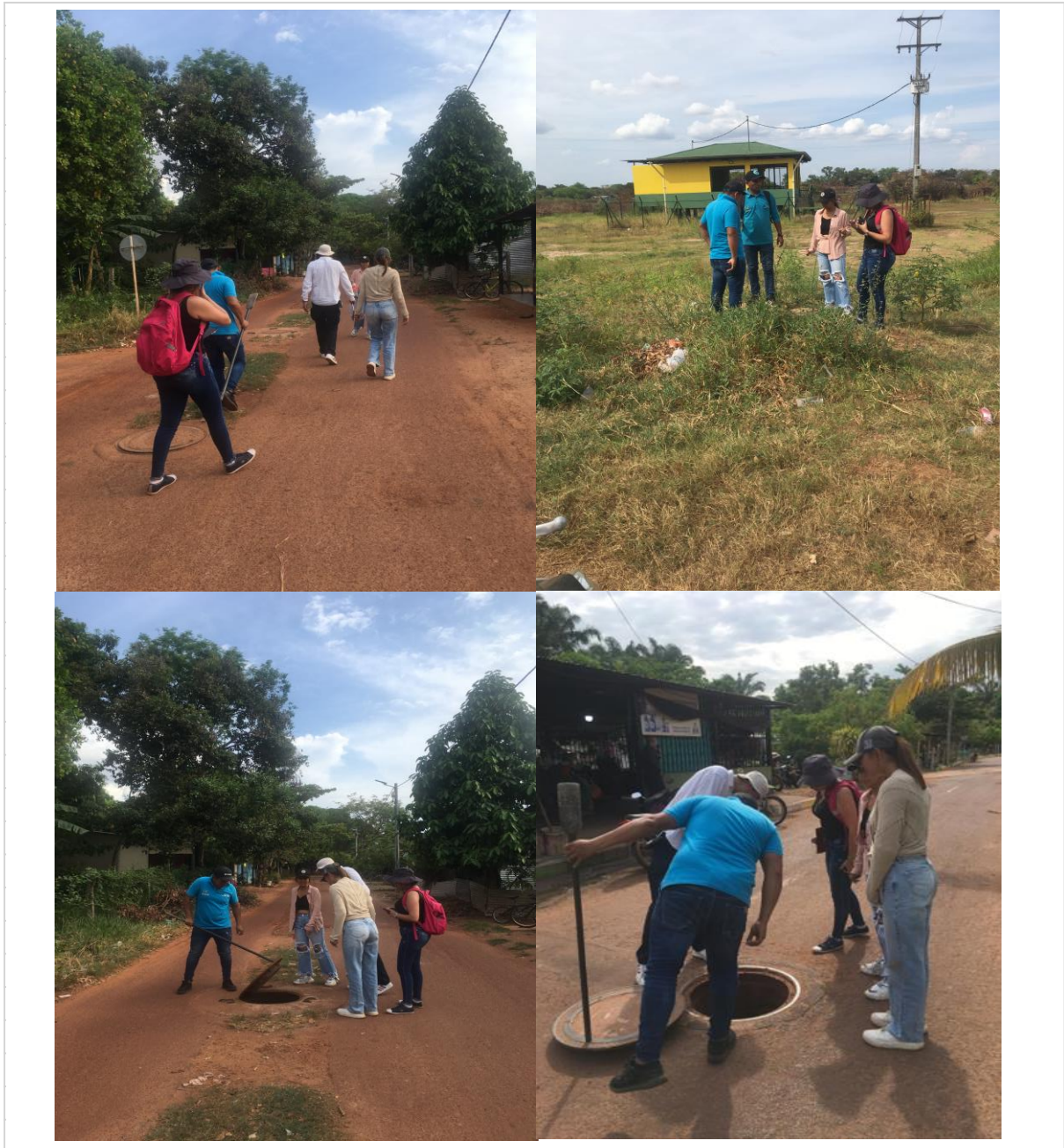
Ilustración 27 recorrido y verificación de los 8 pozos de conexión del alcantarillado nuevo con el antiguo, fuente propia
