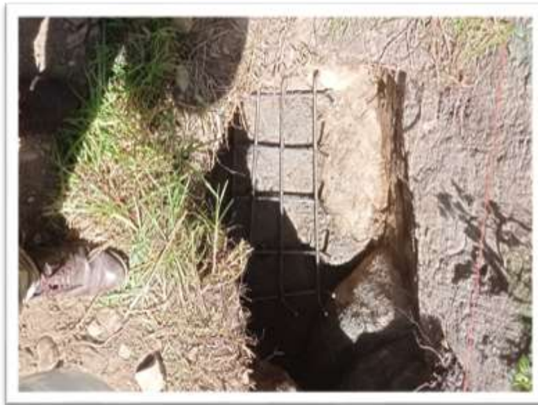
Ilustración 34 Acompañamiento durante la realización de zapatas y columnas para soporte
