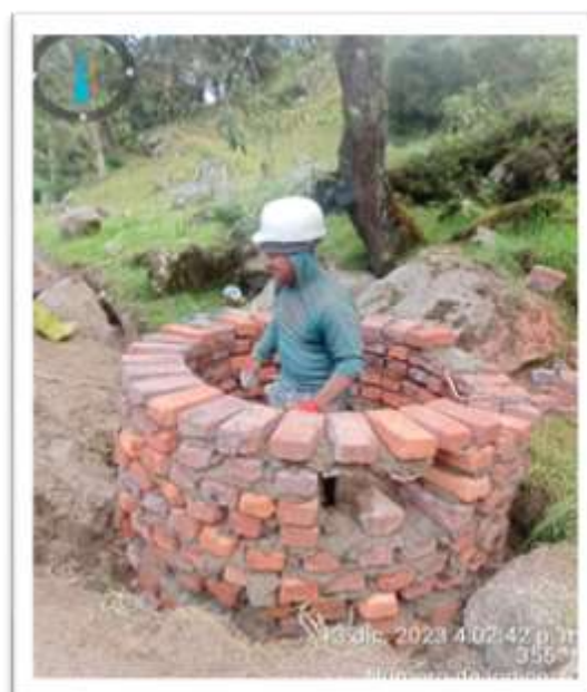
Ilustración 32 Vigilancia en la realización de los pozos cilíndricos
