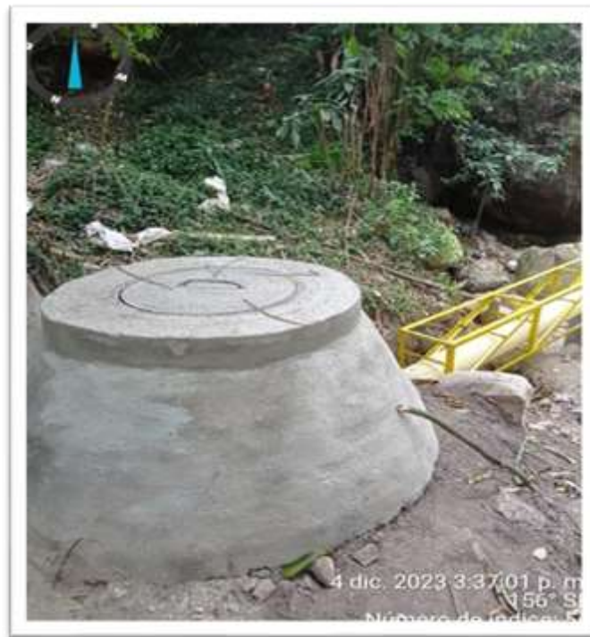
Ilustración 26 elementos en concreto proyecto Prolongación Emisario Final
