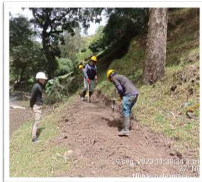
Ilustración 31 Acompañamiento durante la excavación manual en material sin clasificar y roca
