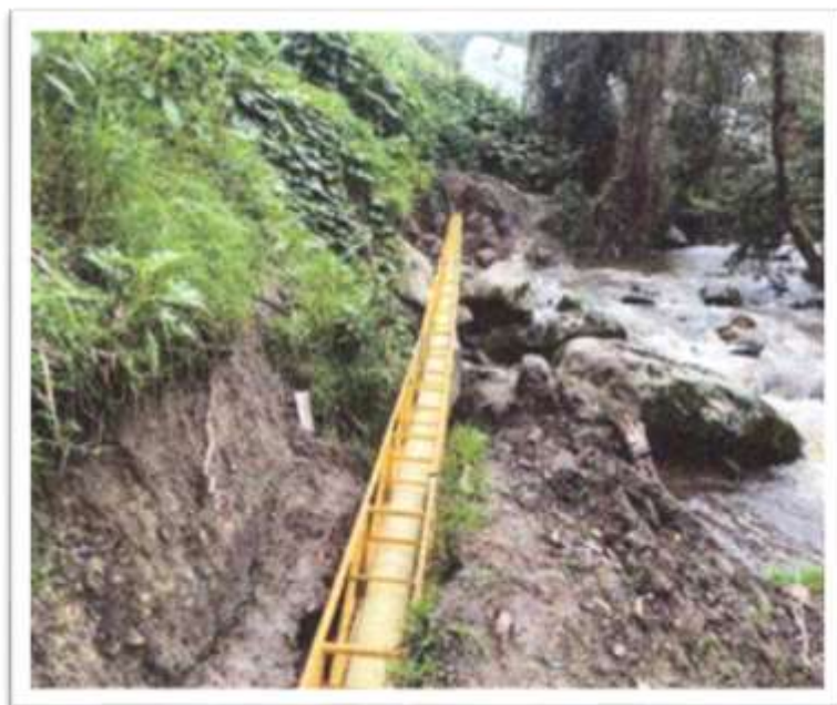
Ilustración35 Supervisión en la instalación de cercha para soporte de tubería
