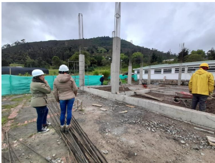
Ilustración 40: Visita por parte de interventoría. Fuente propia
