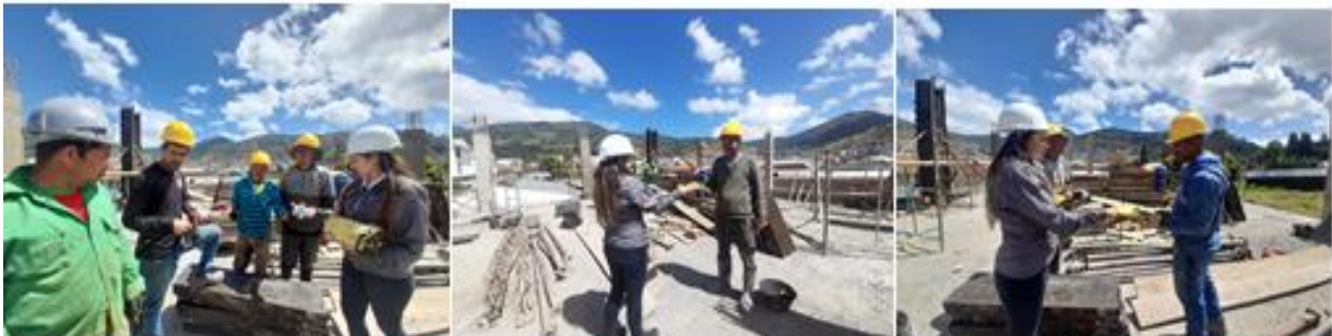
Ilustración 15: Evidencia del cumplimiento de las normas de seguridad en obra Fuente propia
