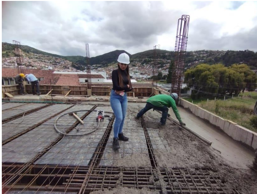
Ilustración 28: Fundida de placa aligerada Fuente propia
