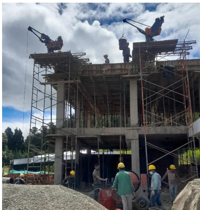
Ilustración 31: Transporte de concreto con pluma grúa Fuente propia
