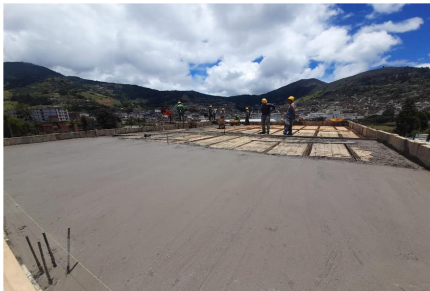
Ilustración 30: Fundida placa cubierta Fuente propia
