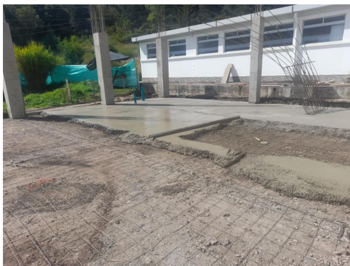
Ilustración 33: Fundida placa de contra piso Fuente propia
