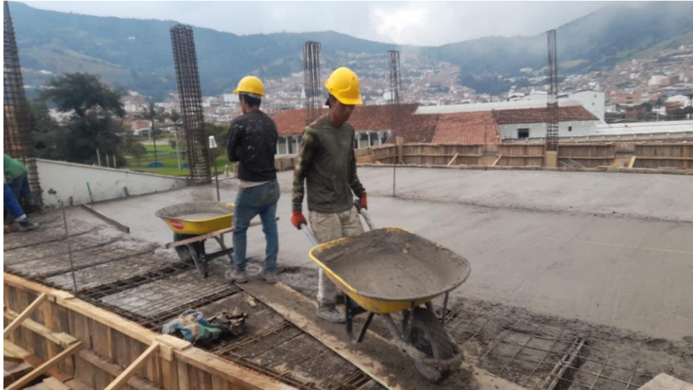
Ilustración 29: Transporte de concreto en carreta Fuente propia
