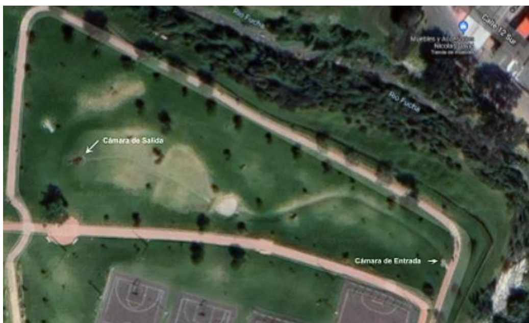
Imagen 13, Vista aérea del sistema MySUDS del Parque San Cristobal (Sistemas de drenaje urbano sostenible, s. f.)
