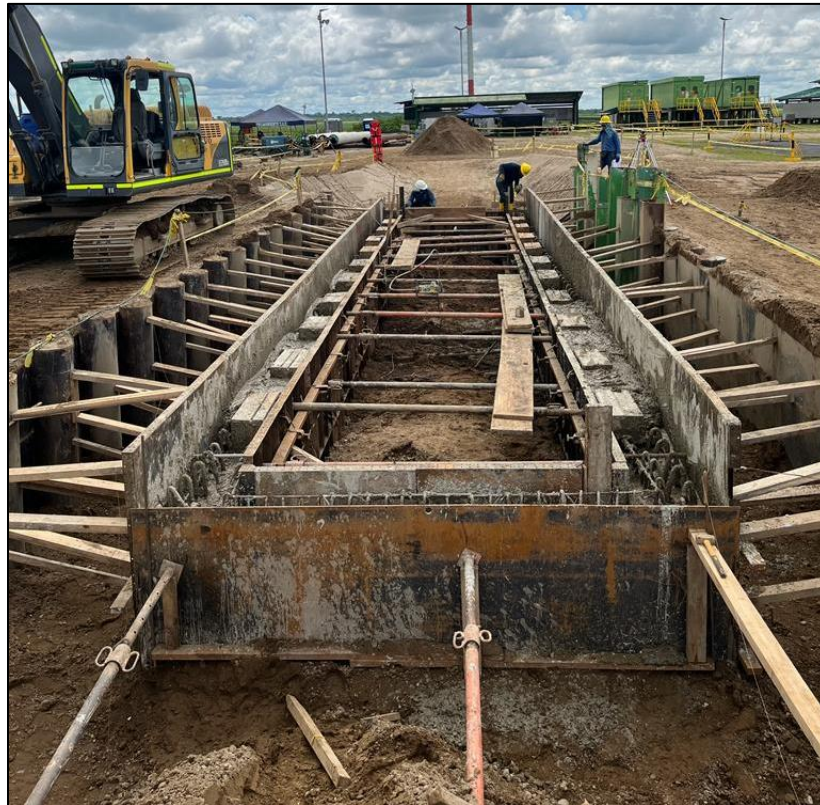
Ilustración 22. Armado de formaleta
