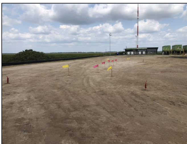
Ilustración 17. Replanteo topográfico
