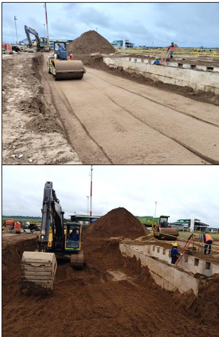
Ilustración 25. Relleno perimetral y compactación.
