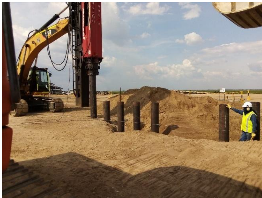
Ilustración 19. Hincado de tubería de 12” para tablestacado.
