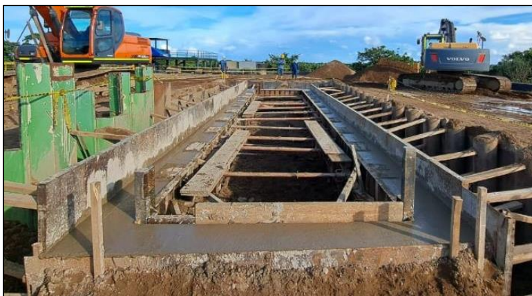
Ilustración 23. Fundida del cárcamo
