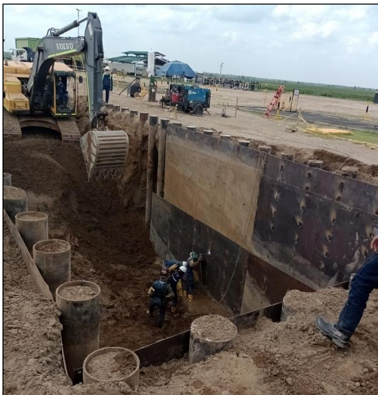
Ilustración 20. Instalación de lamina
