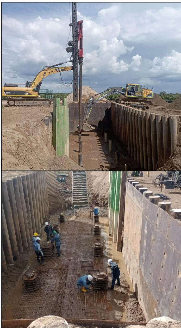
Ilustración 21. Hincado de tubería de cimentación y armado de acero
