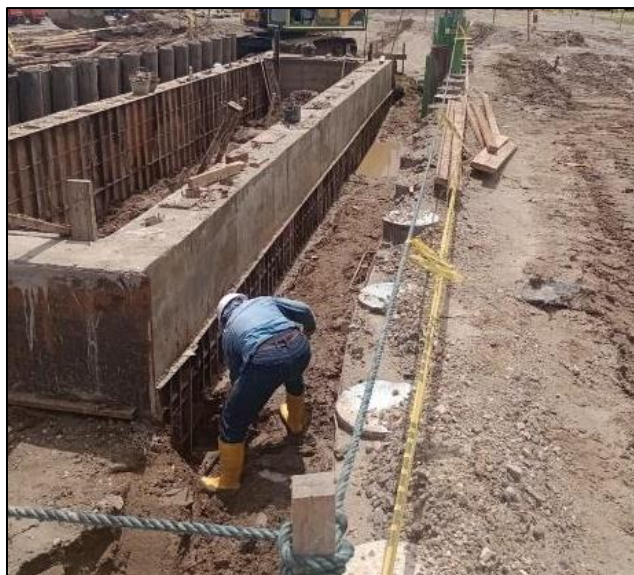
Ilustración 24. Retiro de formaleta
