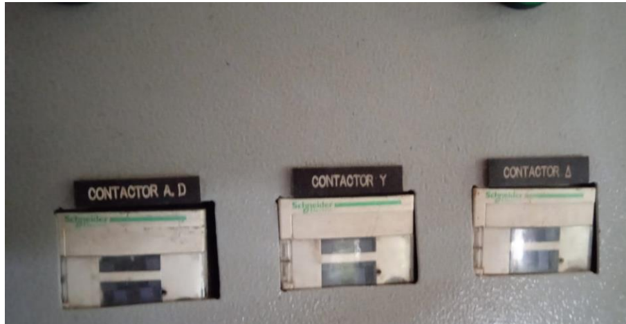
Figura 41 Contactor
