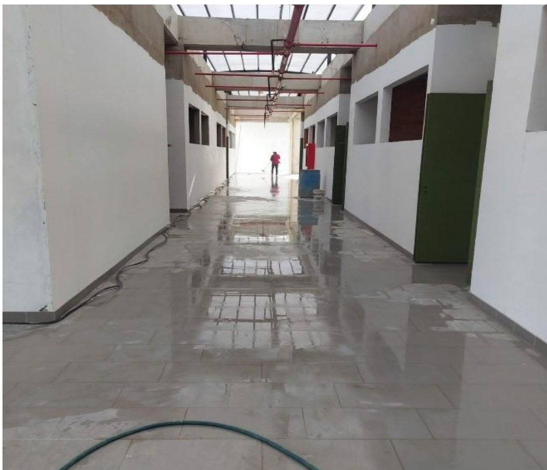
Ilustración 35 . Limpieza y lavado de pisos, enchapes y muros interiores del módulo principal.
