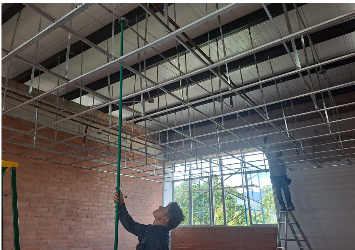
Ilustración 36 Suministro e instalación de salida para tomacorriente doble con polo a tierra para sistema normal en canaleta metálica, incluye accesorios de montaje
