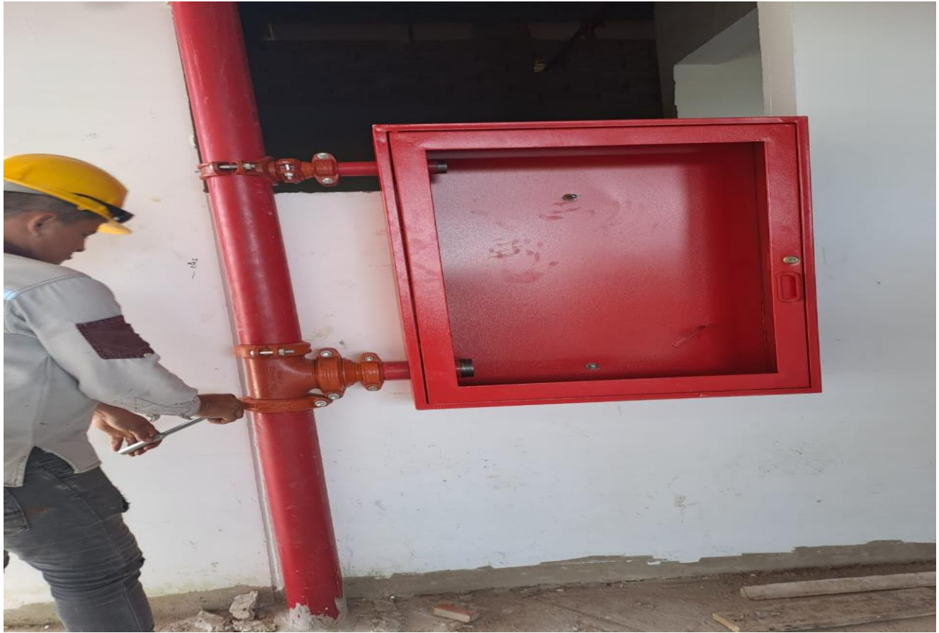
Ilustración 30 Instalación red general contra incendio, redes de acero para incendios, tubería en acero
