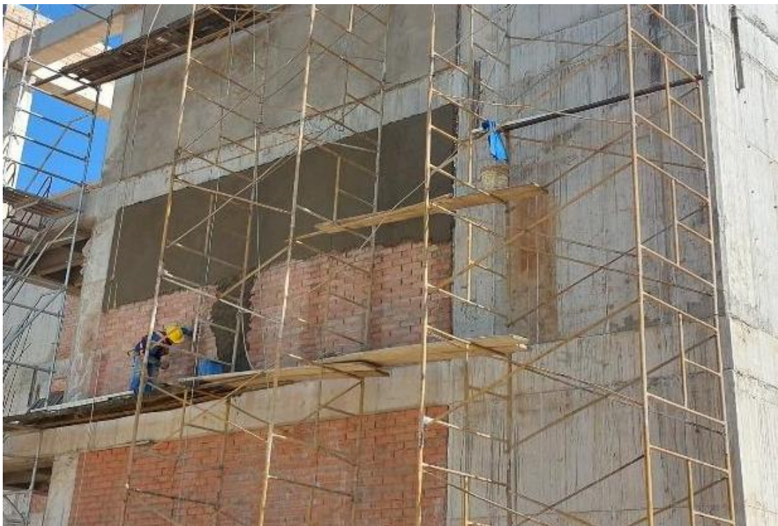
Ilustración 27 Pañete impermeabilizado muros fachada
