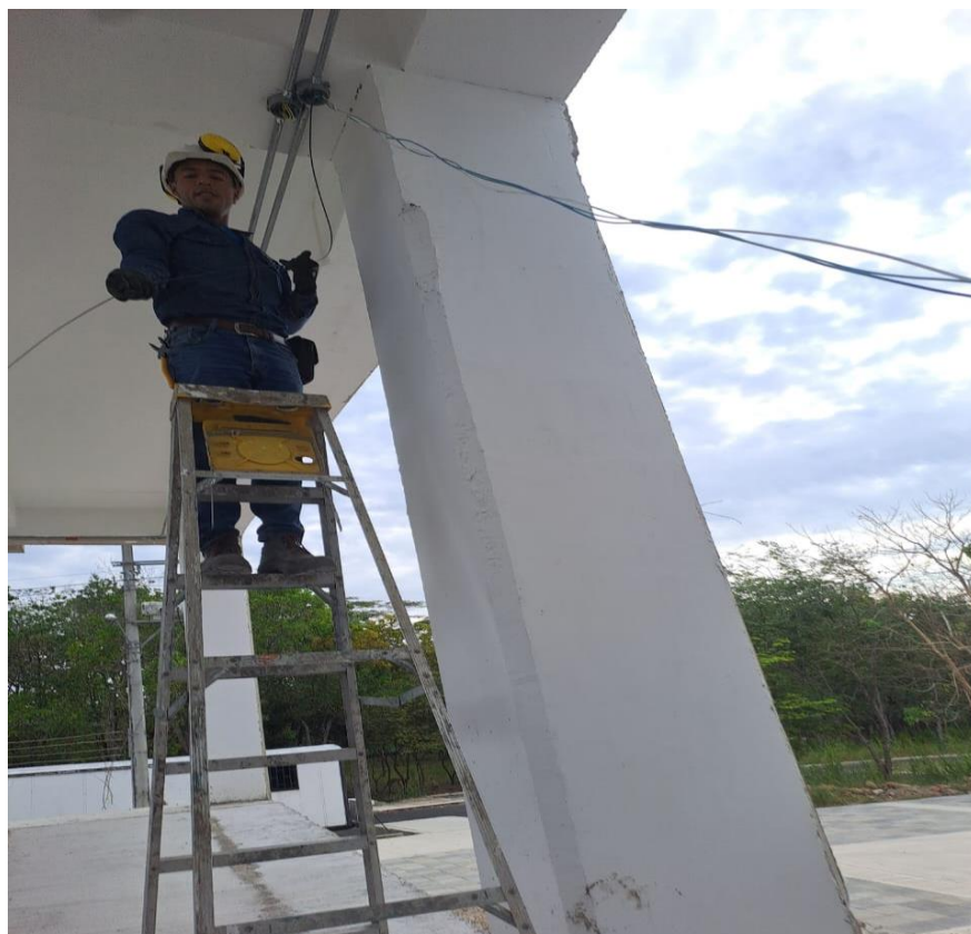
Ilustración 37. Suministro e instalación de red eléctrica y luminarias para rampas y zonas para personas con movilidad reducida
