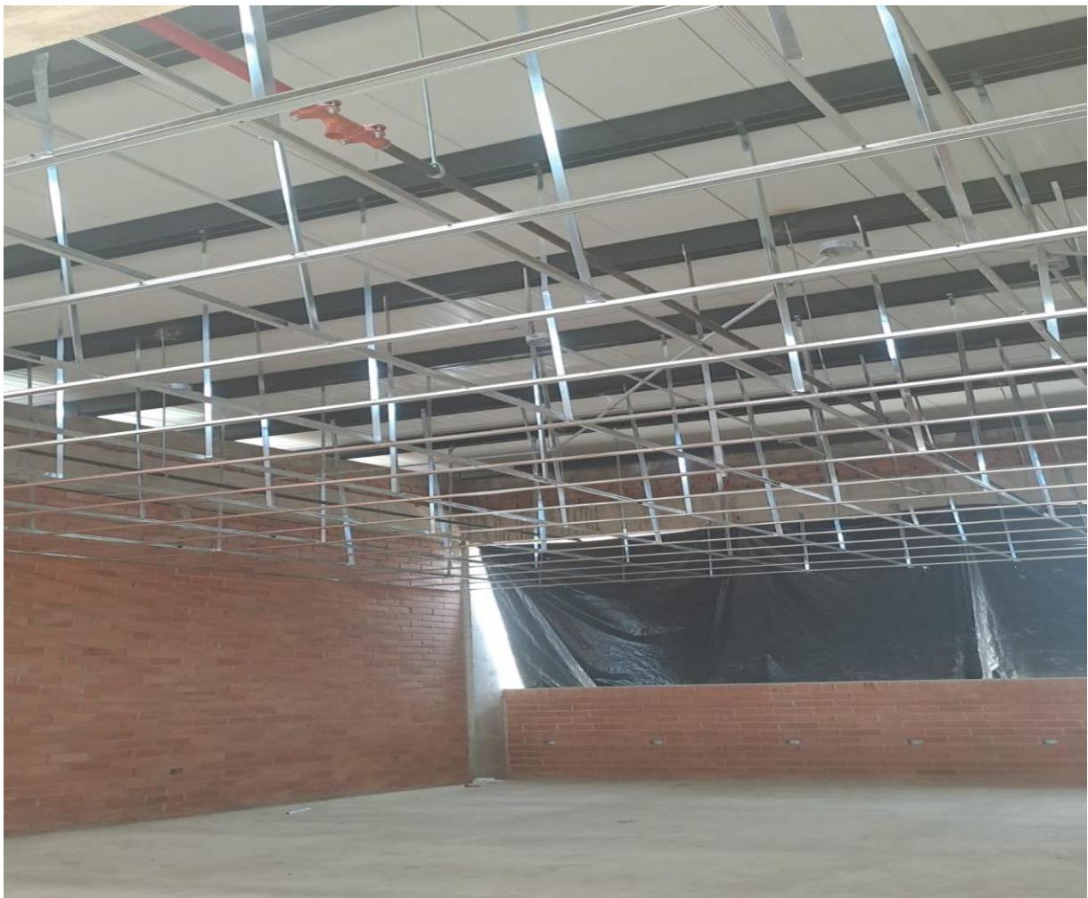
Ilustración 32 Cielo raso metálico aluminio microperforado.
