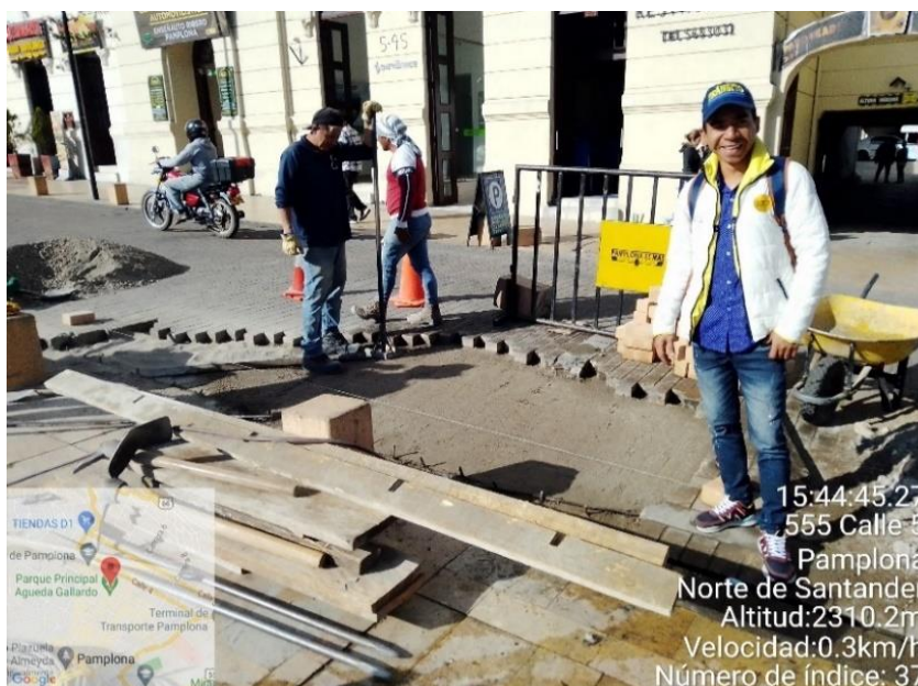
Figura 98 Seguimiento Vía a Reparar
