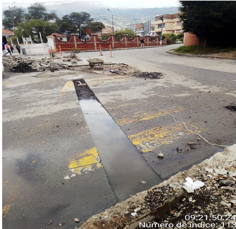
Figura 75 Excavación Para Anclar Pompeyano
