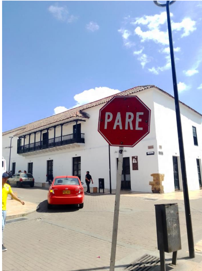
Figura 90 Señalización Después del Mantenimiento
