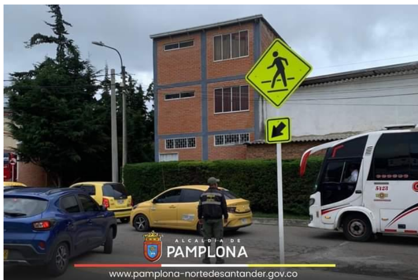
Figura 53 Señal Vertical Instalada SP-46B
