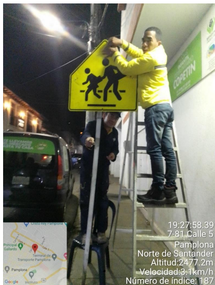
Figura 55 Instalación de Señal Vertical SP-47A
