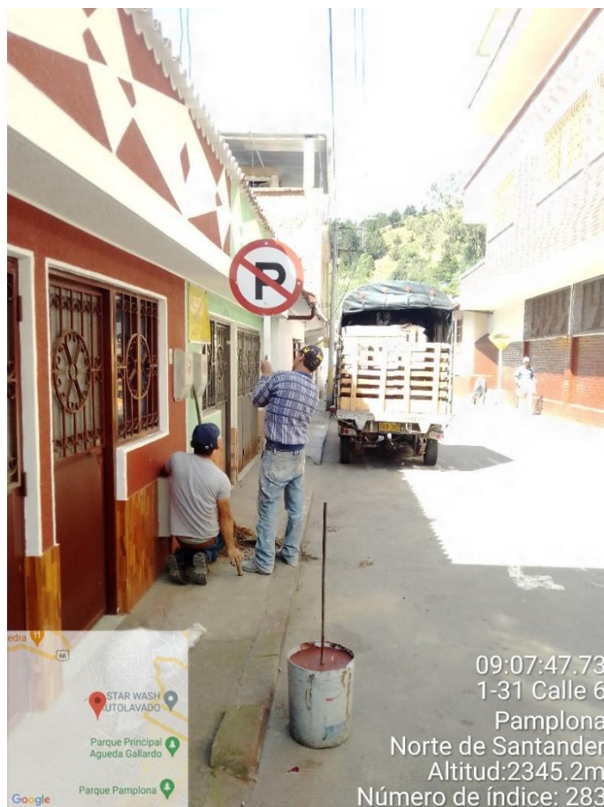
Figura 49 Instalación N°3 de Señal Vertical
