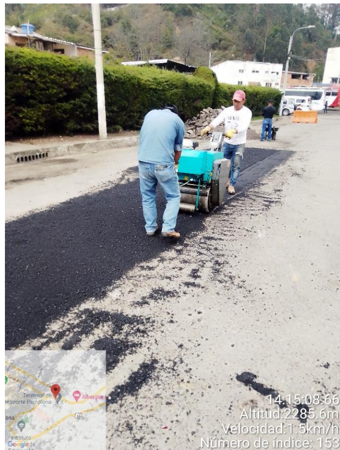
Figura 96 Vibro compactación
