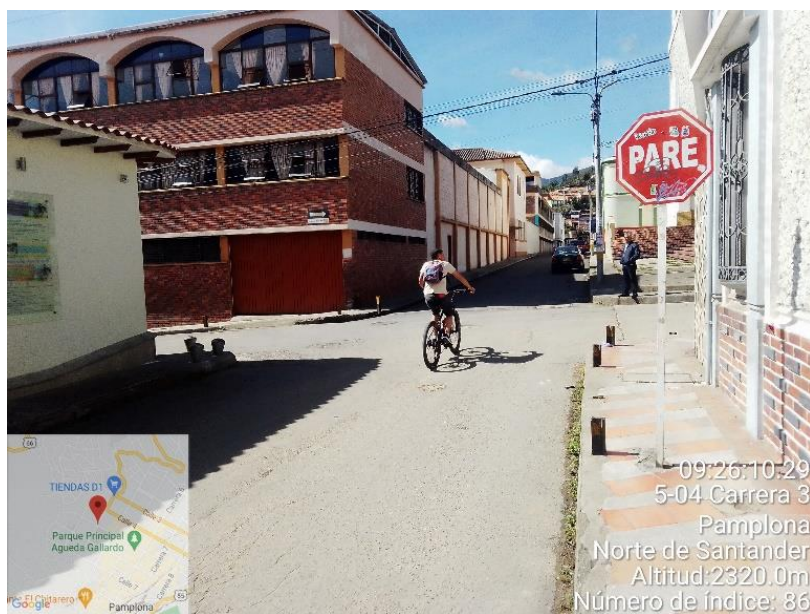
Figura 35 Ausencia Demarcación Horizontal Pare
