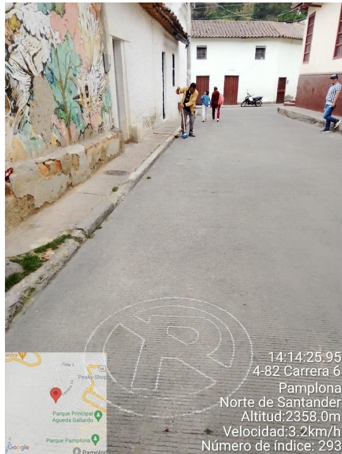
Figura 67 Limpieza y Marcación de la zona
