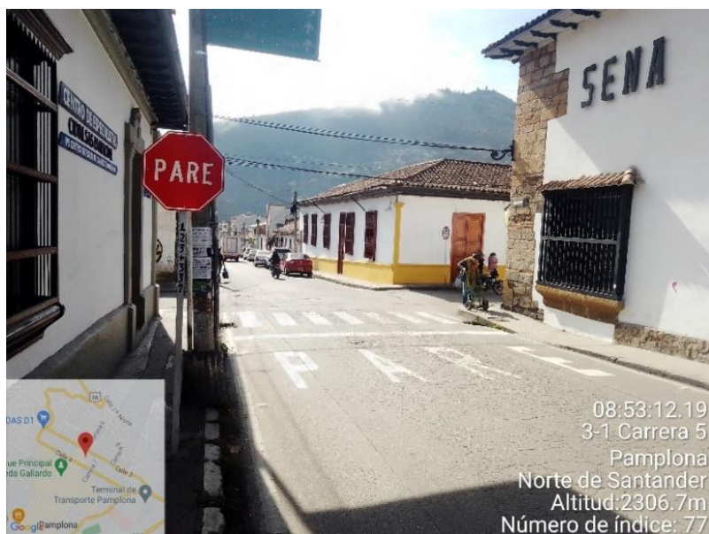
Figura 31 Estado de Señales en la Calle 4 con Carrera 5
