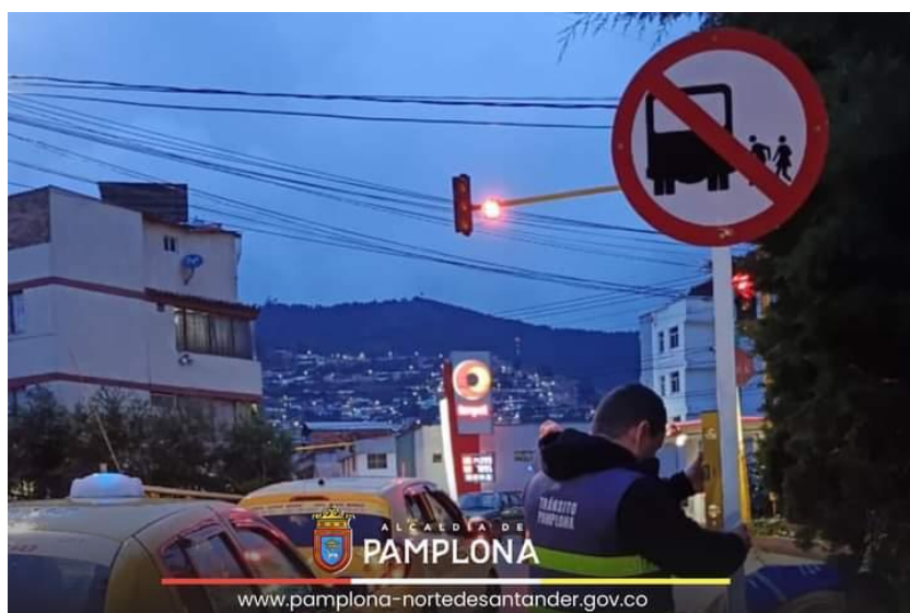
Figura 51 Instalación de Señal Vertical SR-41
