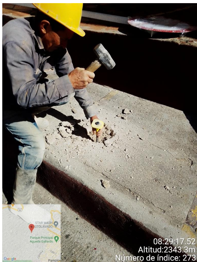
Figura 46 Preparación del Sitio
