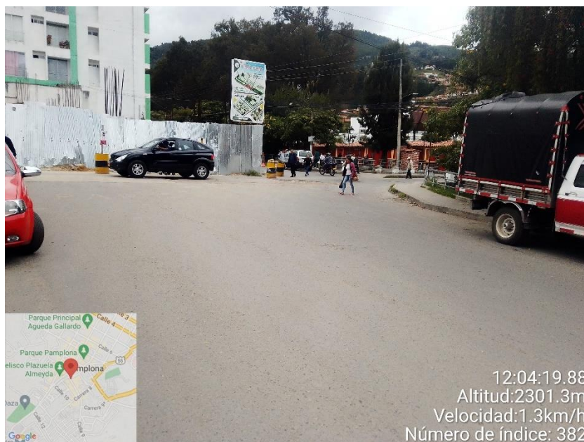
Figura 16 Ausencia de Señalización
