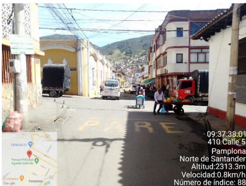
Figura 36 Ausencia Demarcación Vertical Pare
