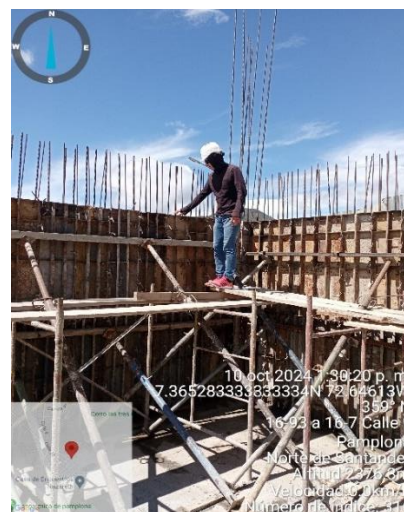
Figura 43. Verificación de Formaleta antes de la fundida de los muros
