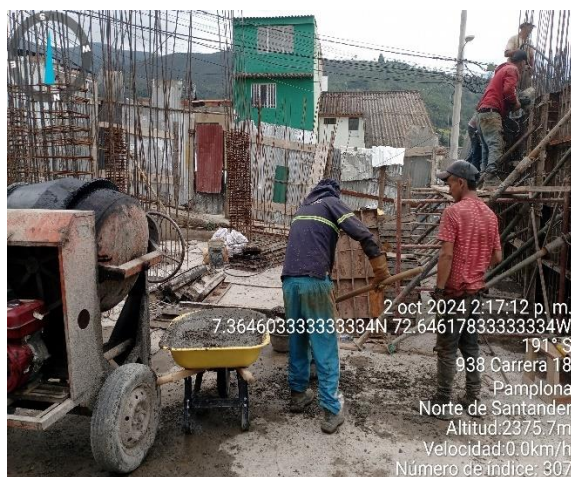
Figura 52. concreto hecho en obra
