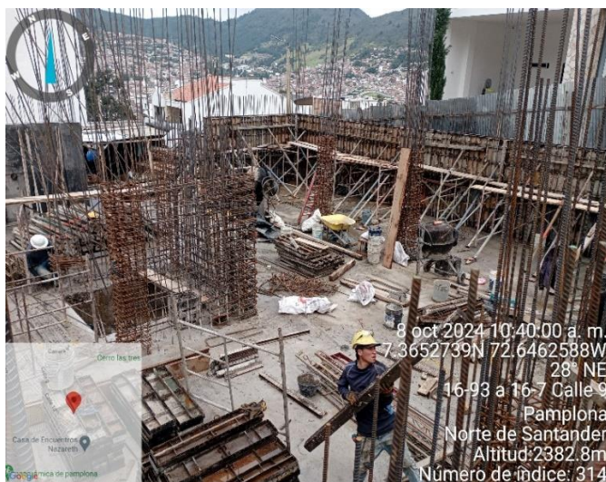
Figura 43. Verificación de Formaleta antes de la fundida de los muros
