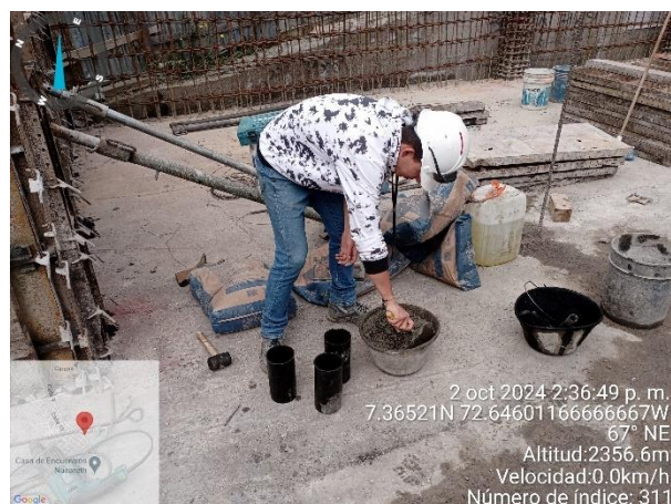
Figura 53. toma de especímenes de concreto hecho en obra
