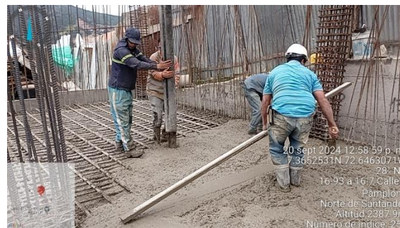
Figura 37. Vertimiento del concreto y nivelación
