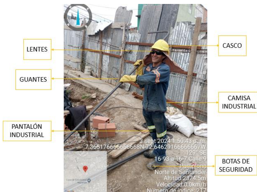
Figura 56. Trabajador haciendo uso de los implementos de seguridad
