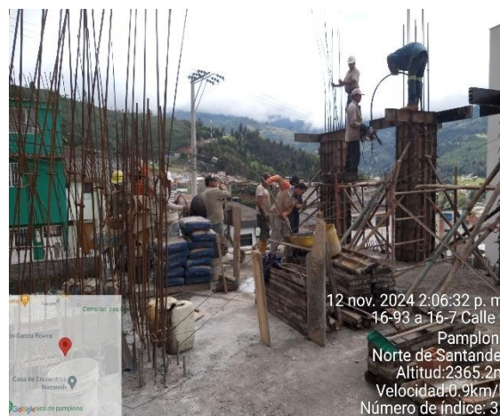
Figura 52. concreto hecho en obra
