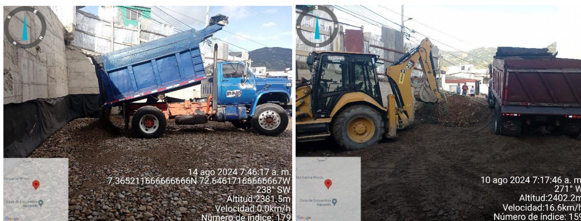
Figura 29. Descargue de sub base granular
