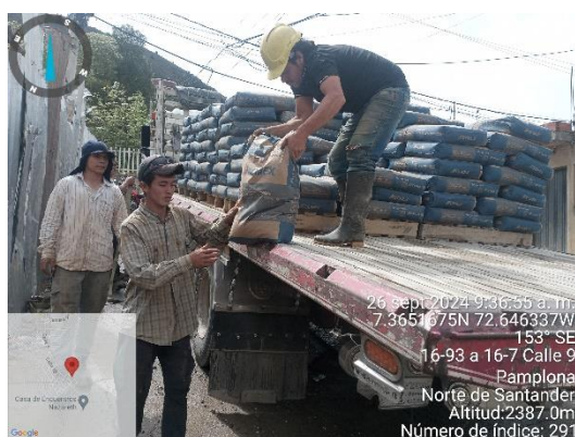
Figura 24. Recibimiento de cemento estructural
