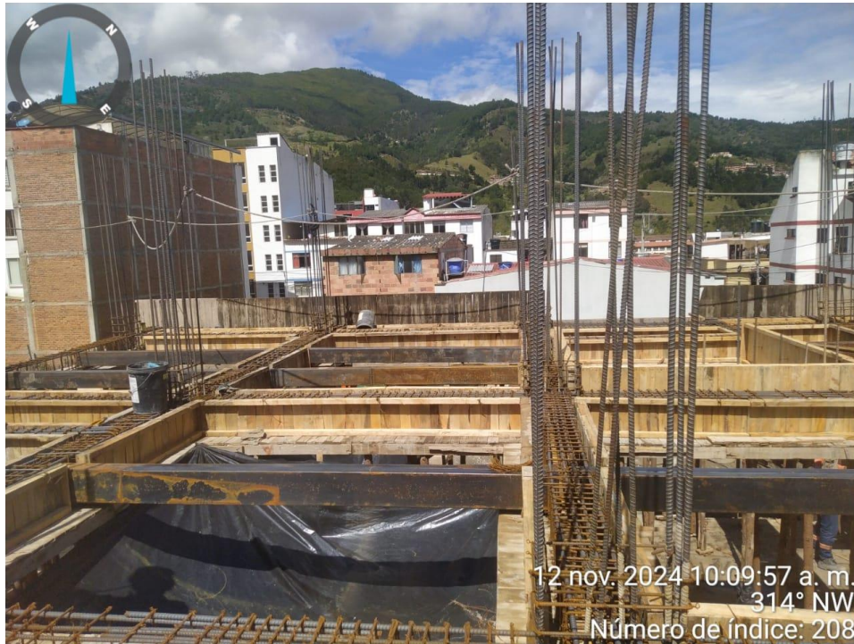
Imagen 9 Armado formaleta para vigas
