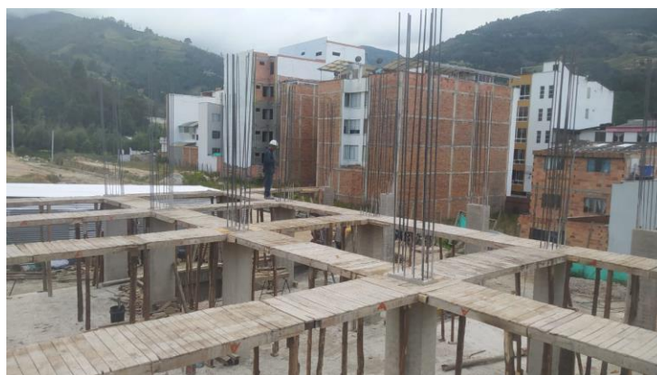
Imagen 4 Armado de formaleta base para vigas completado
