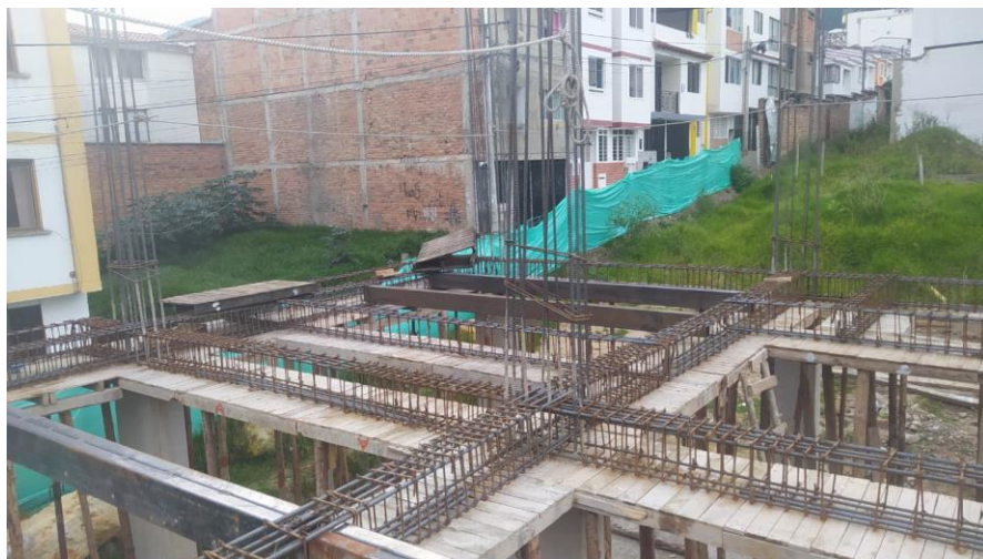
Imagen 7 Colocado de perlines
