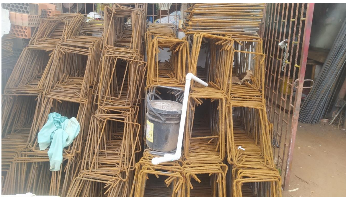
Imagen 30 Inadecuado almacenamiento del material
