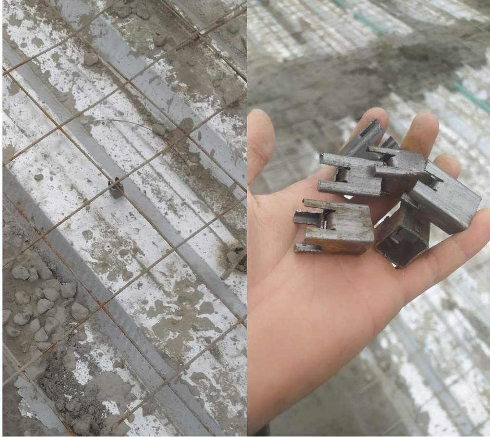
Imagen 11 Separadores realizados por la empresa para malla electrosoldada
