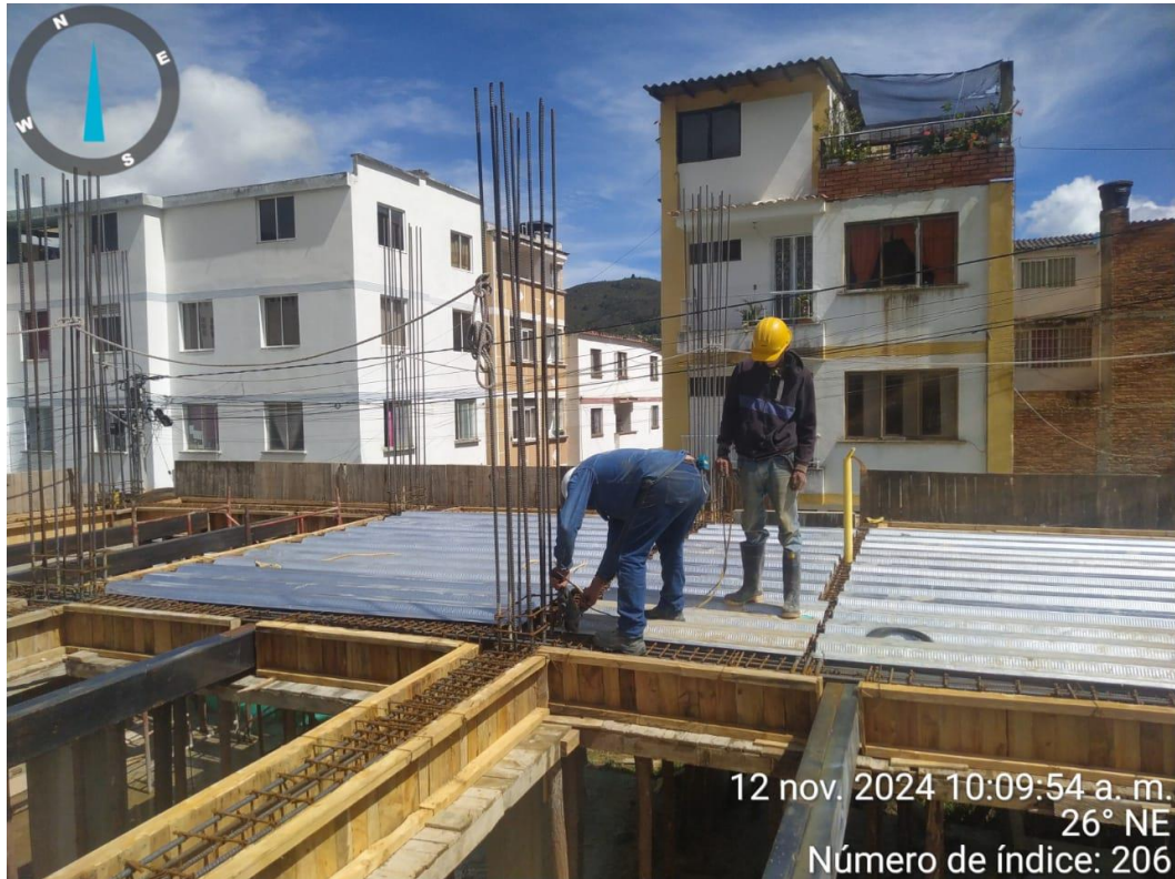
Imagen 10 Instalación de láminas de metaldeck
