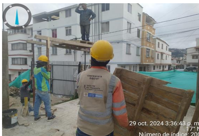
Imagen 3 Armado de formaleta base para vigas
