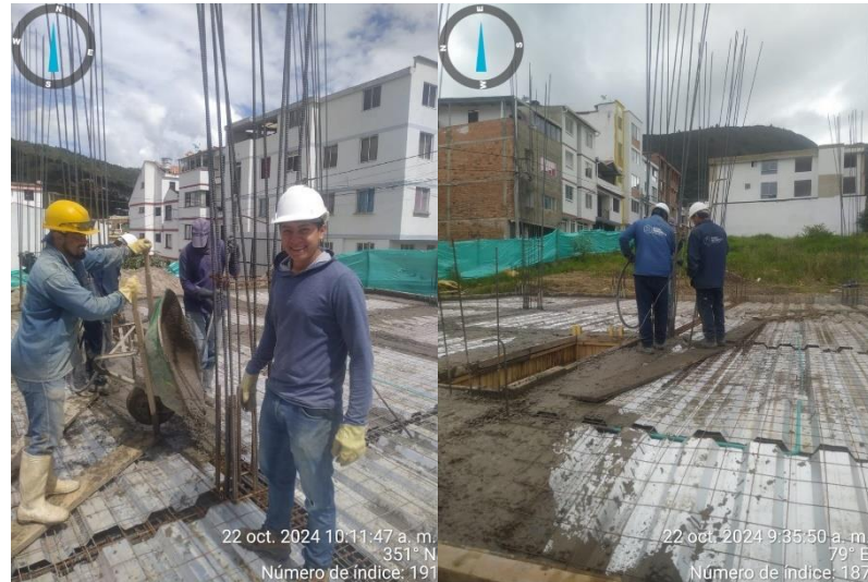
Imagen 13 Fundidas vigas
