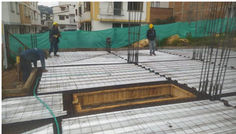
Imagen 12 Instalación de malla electrosoldada
