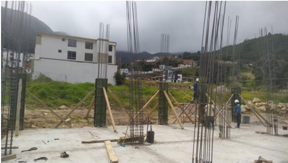
Imagen 1 Armado de aceros de columnas
