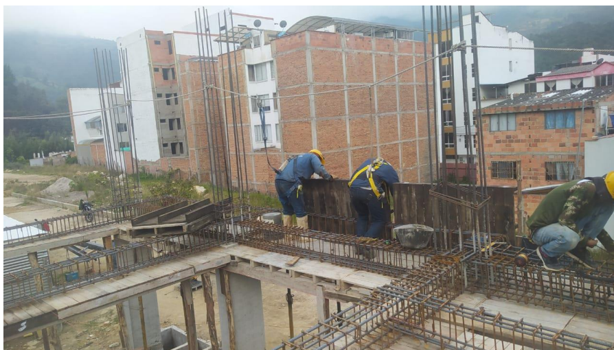
Imagen 8 Armado formaleta para vigas
