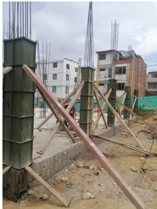
Imagen 2 Armado de formaleta y fundida de columnas
