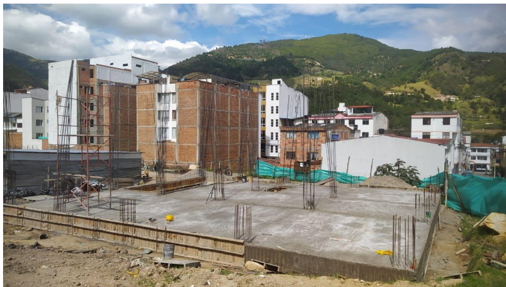
Imagen 15 Un día después de la fundida de viga y placa
