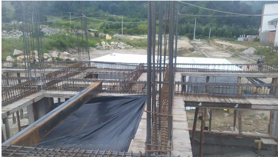
Imagen 6 Colocado de perlines
