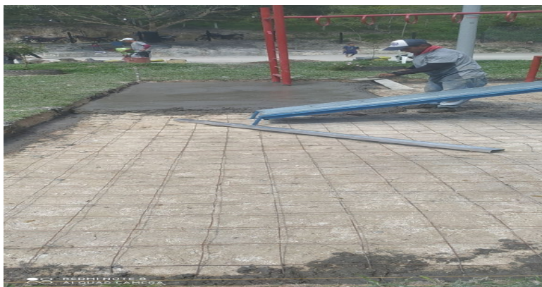
Ilustración 50. Vaciado De Placa Para El Parque Infantil En El Corregimiento El Rosario.
