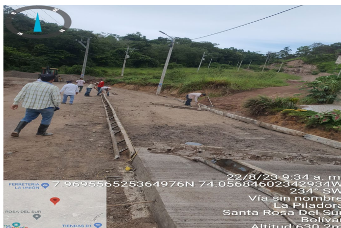
Ilustración 12. Encofrado Para Riego De Subbase
