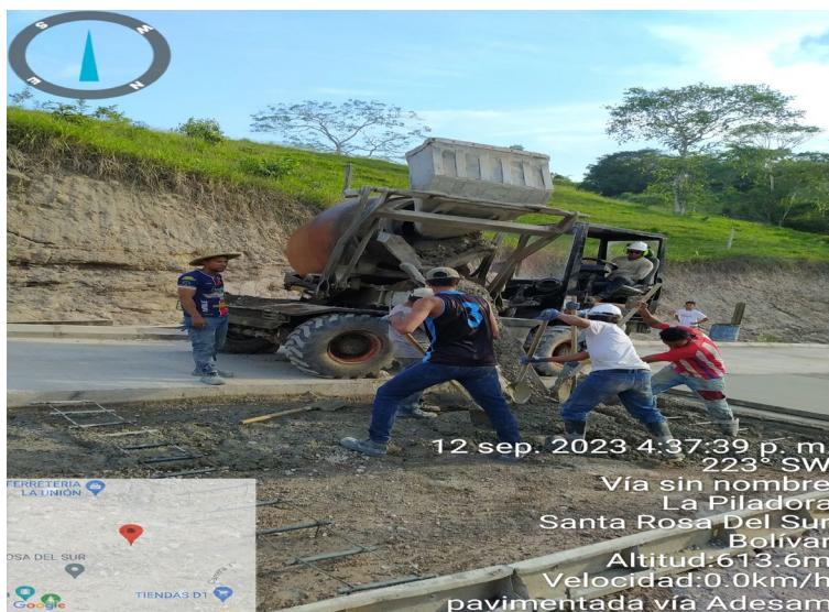
Ilustración 16. Vaciado Con Mini Camión Mezclador f'c 4000 Psi
