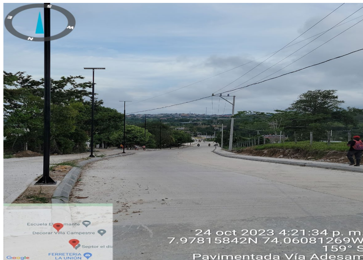
Ilustración 28. Finalización De La Pavimentada K 1+400
