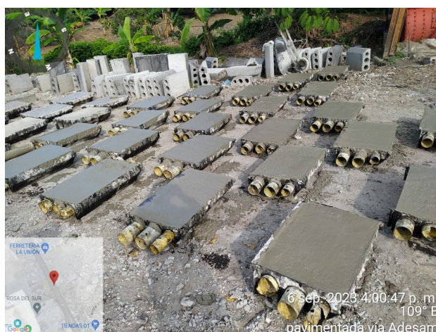
Ilustración 22. Vaciado De Bordillos Prefabricados F'c 4000 Psi
