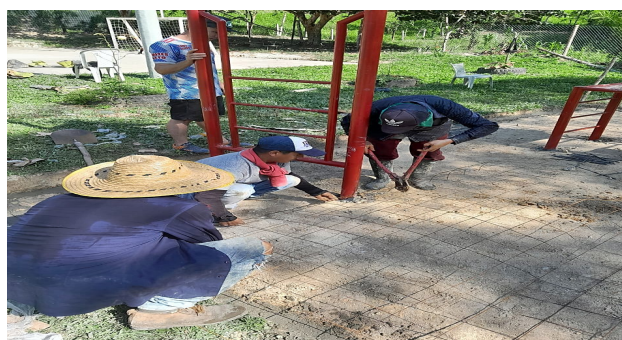
Ilustración 48. Instalación Malla Electrosoldada Para El Parque Infantil En El Corregimiento El Rosario.
