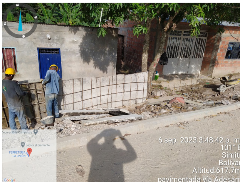
Ilustración 25. Encofrado Muro Contención K 0+900 Fuente: Autor.
