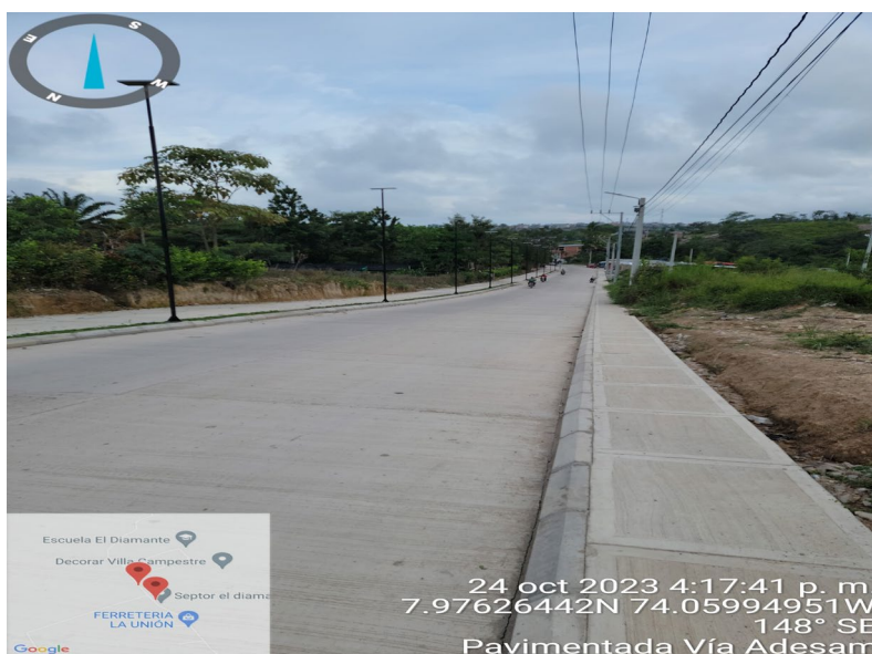
Ilustración 29. Finalización De La Pavimentada K 1+200
