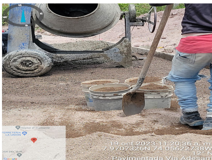
Ilustración 17. Dosificación f'c 4000 Psi Mezcladora
