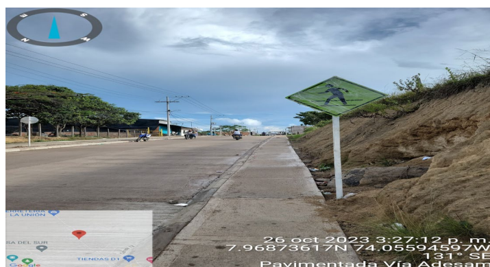
Ilustración 27. Finalización De La Pavimentada K 0+220
