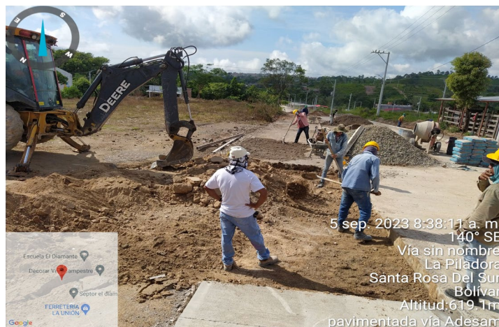
Ilustración 10. Excavación Y Replanteo Pavimentada Fuente: Autor.
