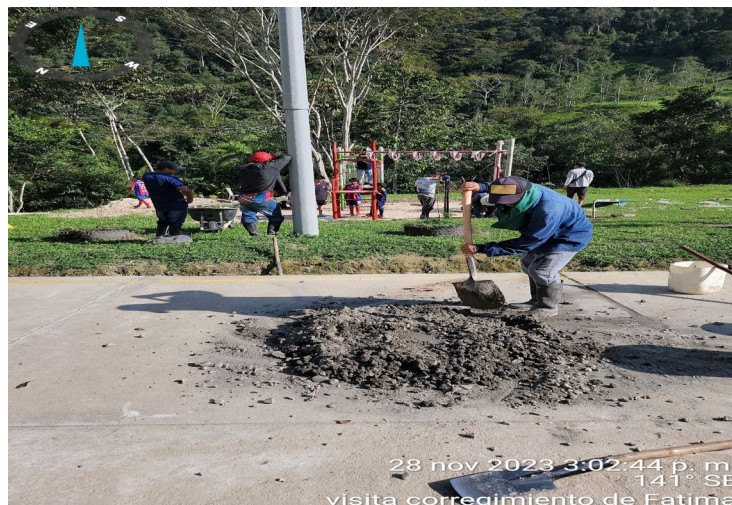
Ilustración 47. Mezcla Manual De Concreto f'c 3000psi
