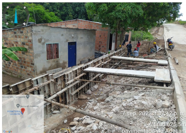
Ilustración 26. Apuntalamiento De Muro Contención K 0+900
