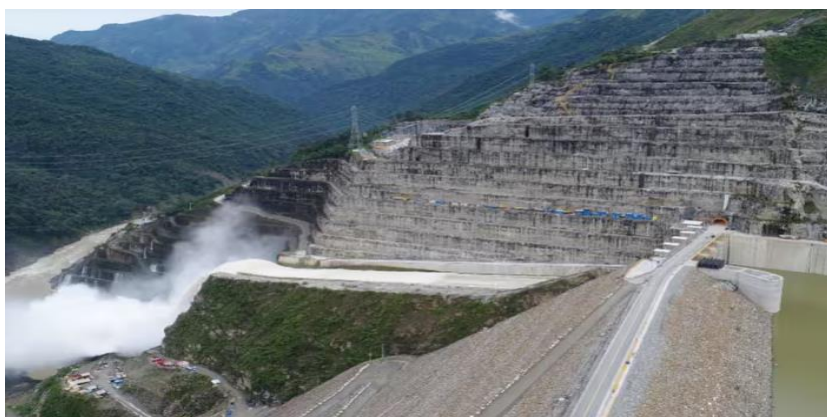
Presa de Hidroituango
