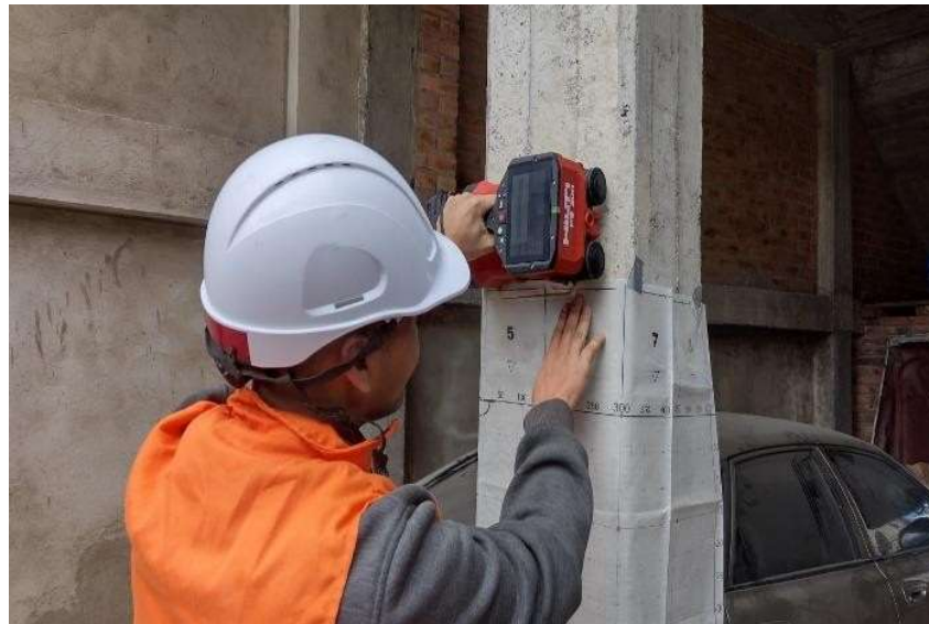
Ilustración 36. Escaneo con ferroscom. Fuente: Propia.
