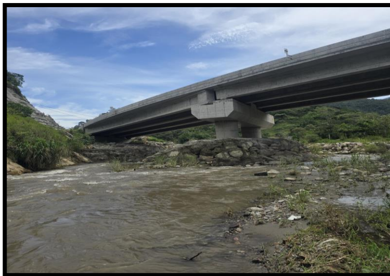
Figura 7. Perspectiva aguas arriba del puente principal sobre el río Pamplonita, utilizada como referencia para modelado hidráulico. (Elaboración propia).
