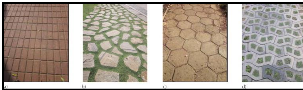
Figura 9. Tipos de pavimentos permeables
