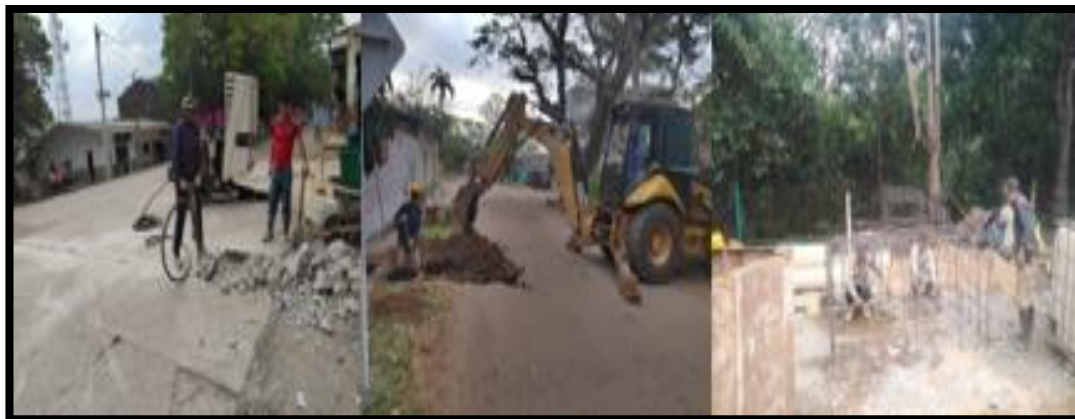
Figura 33. Amarre de acero para estructura de sumidero, demolición de pavimento y excavación mecánica. Fuente: propia.
