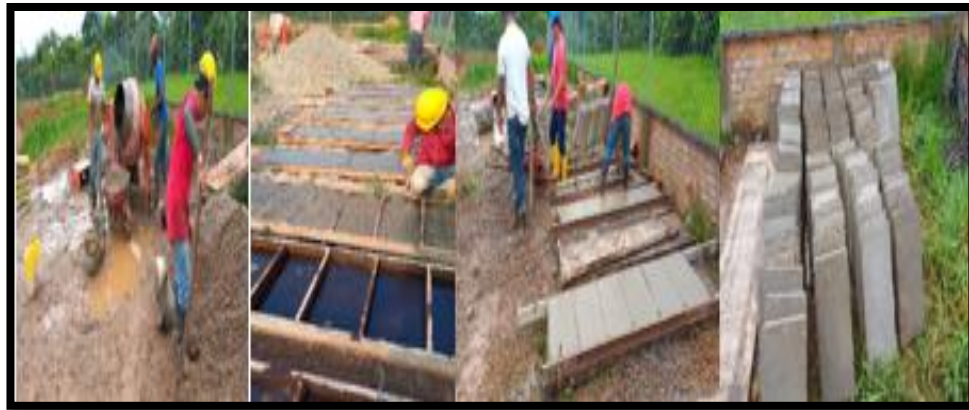
Figura 45. Construcción de ladrillos de concreto reforzado. Fuente: propia.
