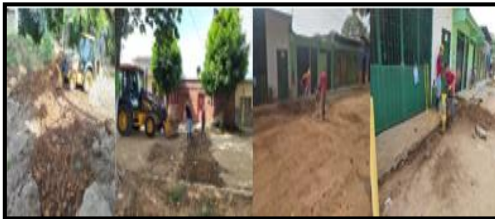
Figura 26. Relleno con material de recebo a excavación y compactación. Fuente: propia.
