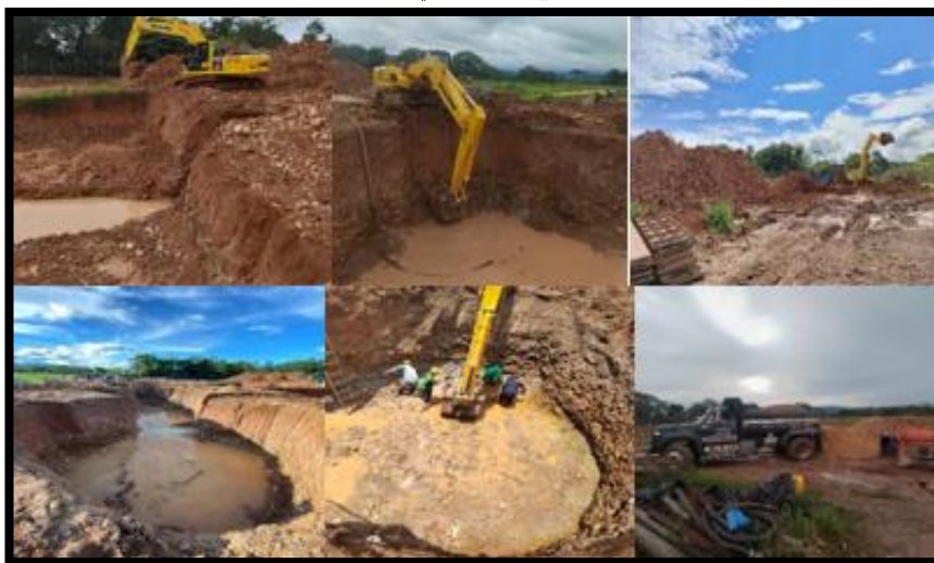
Figura 48. Excavación mecánica y replanteamiento con nivel y estación topográfica. Fuente: propia.
