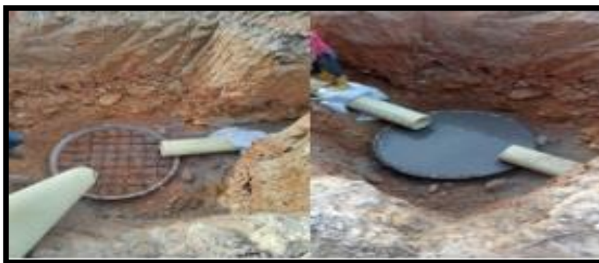
Figura 9. Construcción de placa de piso de concreto reforzado. Fuente: propia.
