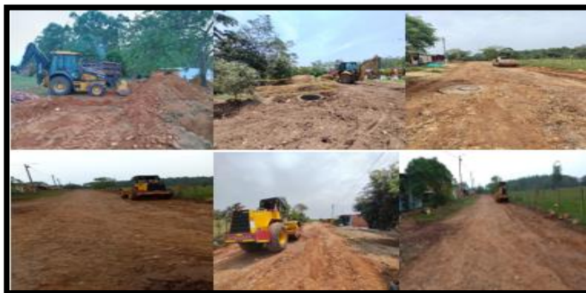
Figura 21. Relleno con material y compactación. Fuente: propia.
