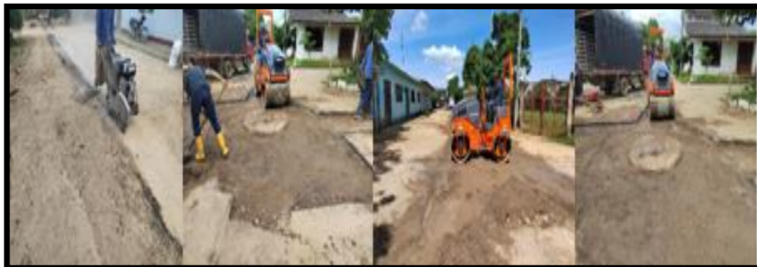
Figura 40. Replanteamiento, corte para perfilar pavimento y compactación. Fuente: propia.
