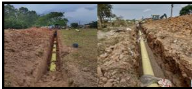
Figura 19. Instalación de tubería de alcantarillado sanitario. Fuente: propia.
