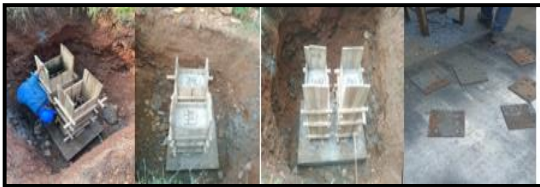
Figura 32. Construcción y fundida de pedestales. Fuente: propia.
