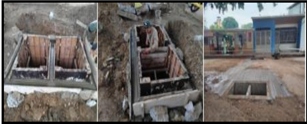
Figura 35. Formaleteada y fundida de pared y viga de sumidero. Fuente: propia.
