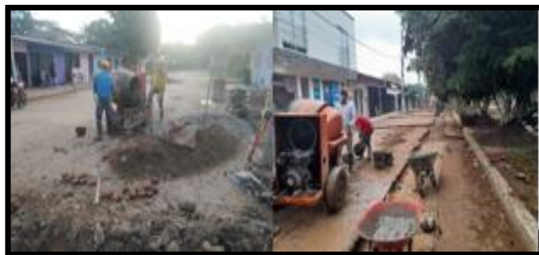
Figura 37. Mezclada de concreto. Fuente: propia
