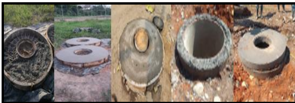
Figura 12. Construcción de tapas o cubiertas de pozos de inspección. Fuente: propia.
