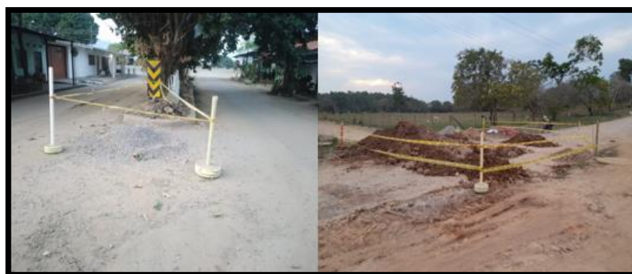
Figura 59. Cerramiento y señalización. Fuente: propia.
