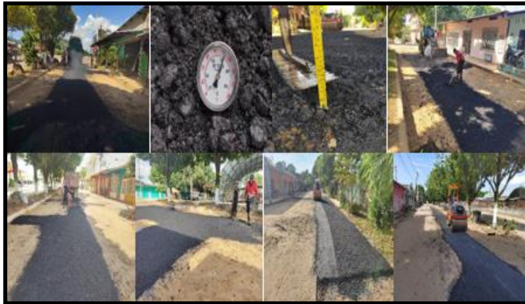
Figura 42. Riego y expansión de carpeta de asfáltica, con su debida compactación. Fuente: propia.
