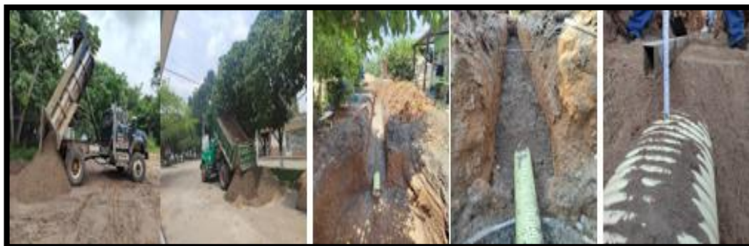
Figura 20. Tubería de alcantarillado con su respectiva cama de arena. Fuente: Propia.
