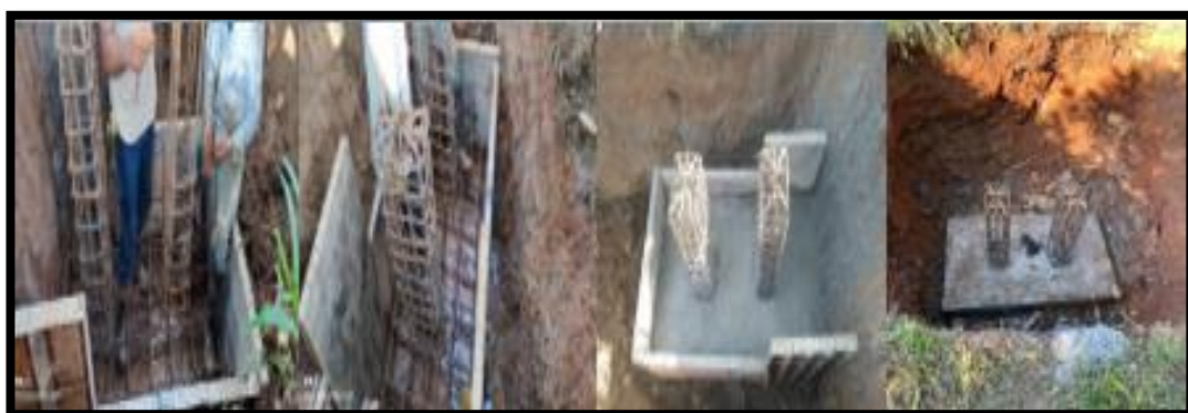
Figura 31. Construcción y fundida de zapatas para paso elevado. Fuente: propia.
