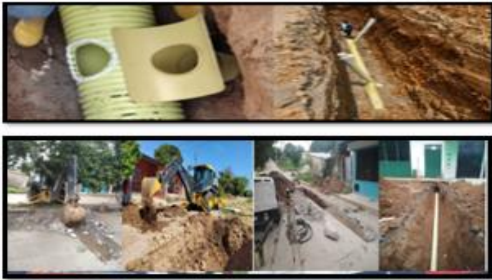
Figura 24. Excavación mecánica, instalación de silla TEE PVC 6" Y instalación de tubería. Fuente: propia
