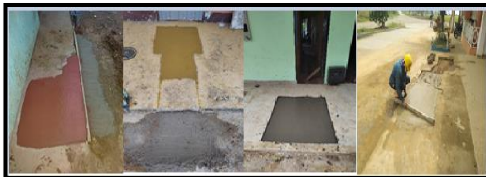
Figura 17. Construcción de tapas o cubiertas de pozos de inspección. Fuente propia.
