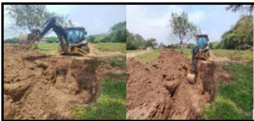
Figura 8. Excavación mecánica y replanteo para pozos de inspección. Fuente: propia
