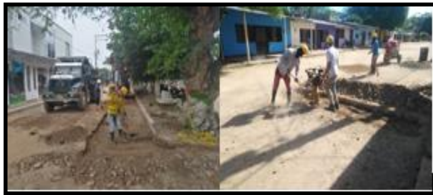
Figura 36. Replanteamiento y compactación para fundida de concreto reforzado. Fuente: propia.
