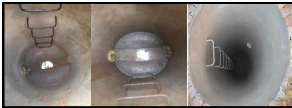
Figura 11. Construcción de cañuelas y pañetes internos de pozos de inspección. Fuente: propia.
