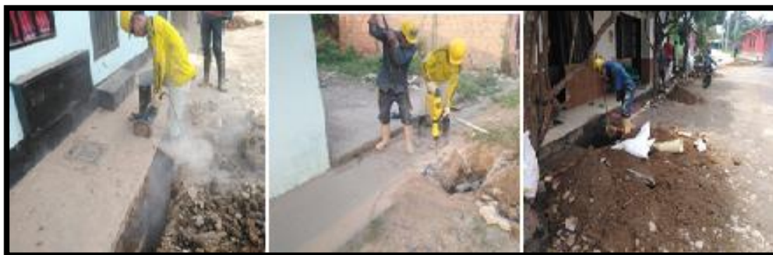
Figura 13. Construcción de tapas o cubiertas de pozos de inspección. Fuente: propia
