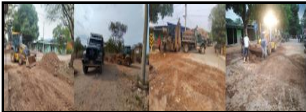
Figura 22. Realización de limpieza del material sobrante, producto de la excavación. Fuente: propia.
