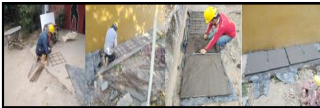
Figura 16. Construcción de tapas o cubiertas de pozos de inspección. Fuente: propia.
