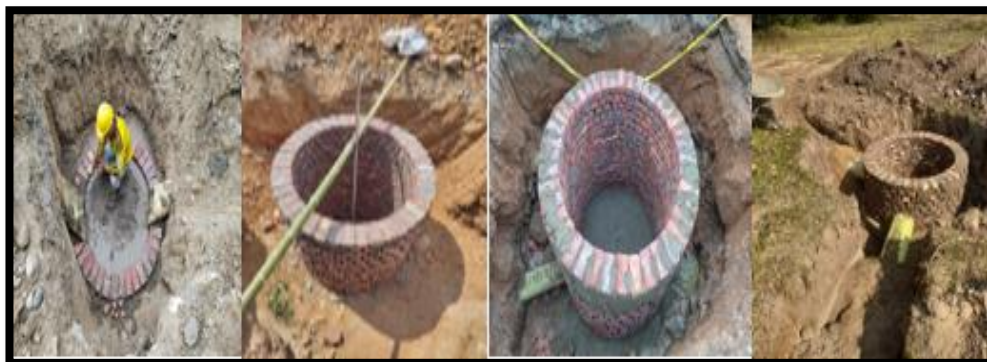
Figura 10. Construcción del cilindro para pozo de inspección. Fuente: propia.
