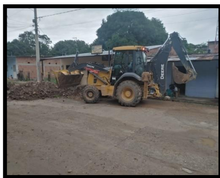
Figura 55. Retroexcavadora John Deere.
