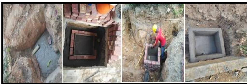
Figura 15. Construcción de tapas o cubiertas de pozos de inspección. Fuente: propia.
