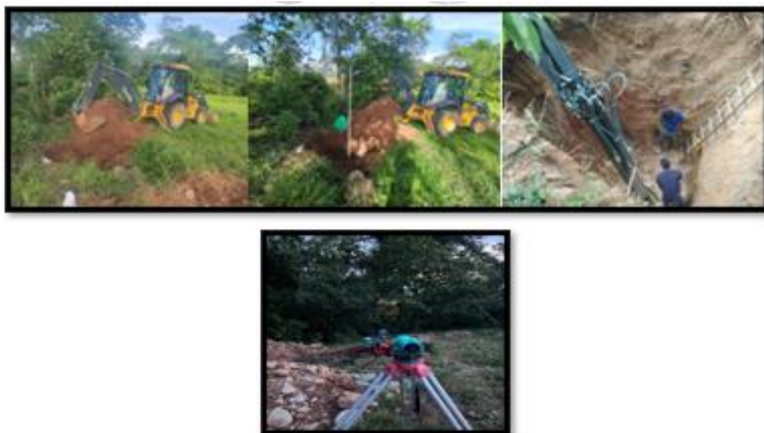
Figura 30. Excavación mecánica y replanteamiento con nivel topográfico. Fuente: propia.
