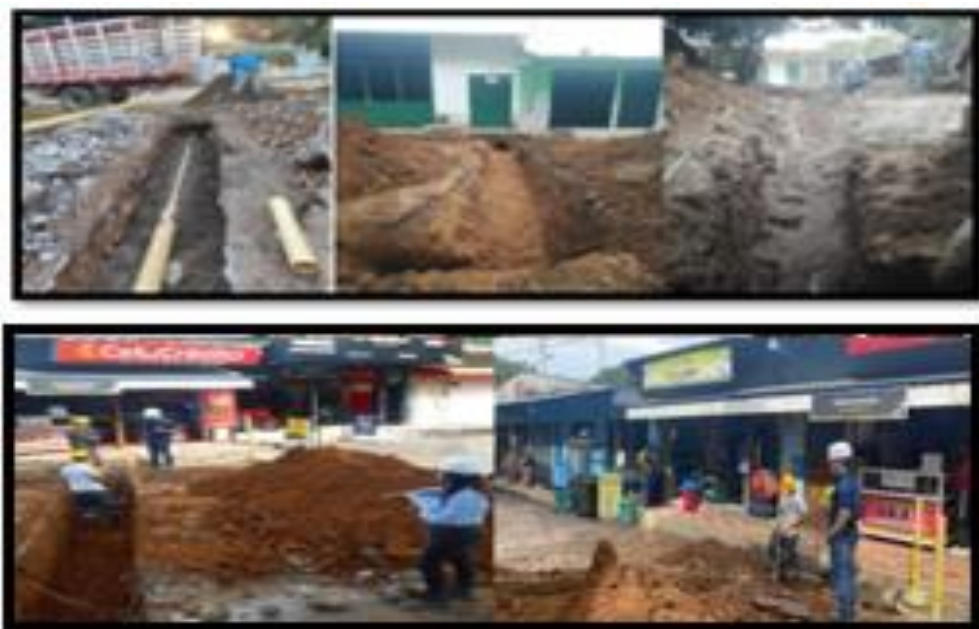
Figura 25. Tubería de acometida domiciliaria con su respectiva cama de arena. Fuente: propia.
