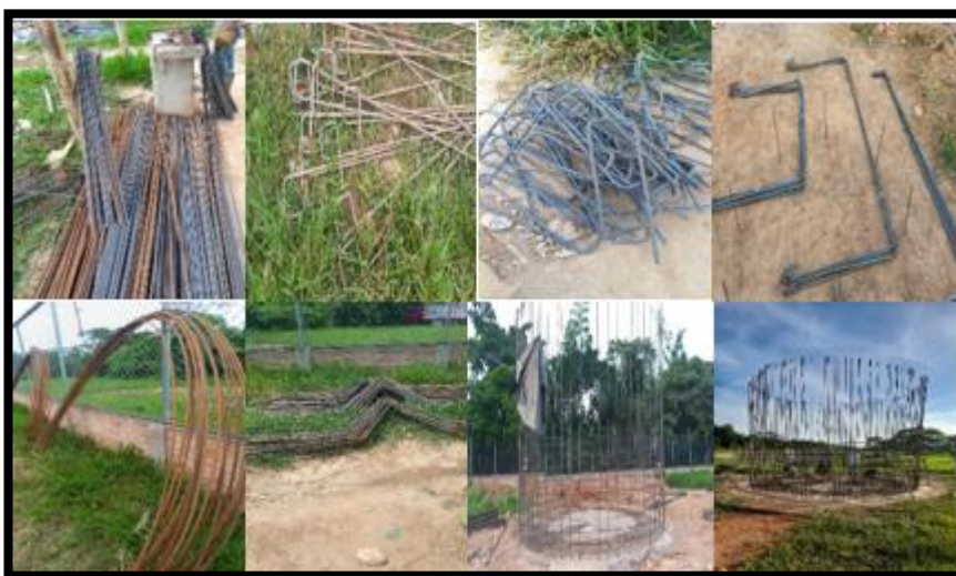
Figura 49. Despiece, figurado y amarrado de hierro para reactores. Fuente: propia.
