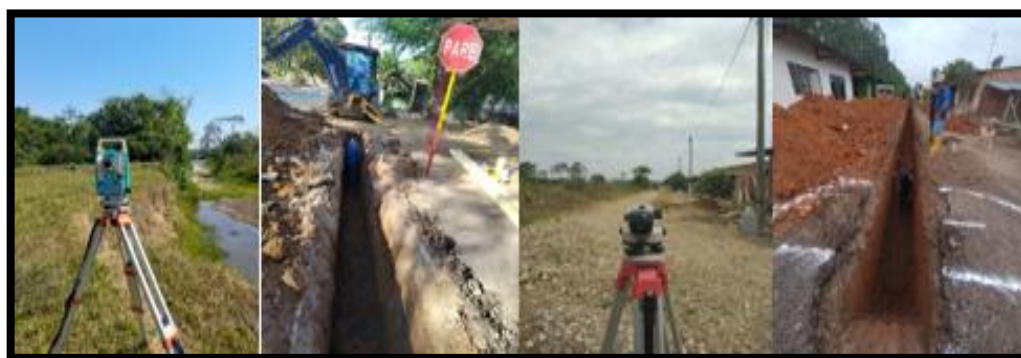
Figura 18. Excavación mecánica y replanteamiento con nivel para dar la pendiente necesaria. Fuente: propia.
