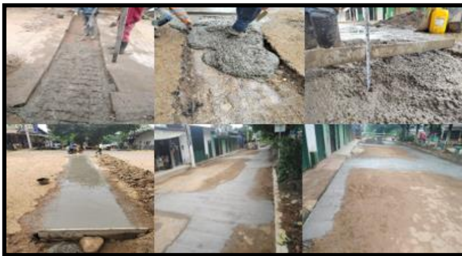
Figura 39. Fundida y alistado concreto de concreto reforzado. Fuente: propia.
