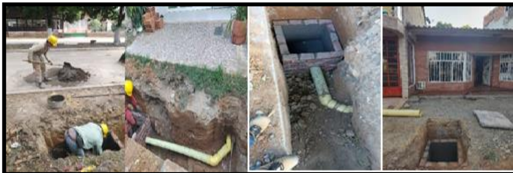
Figura 14. Construcción de tapas o cubiertas de pozos de inspección. Fuente: propia
