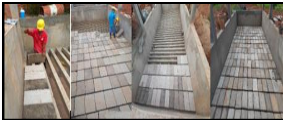
Figura 46. Distribución y colocación de ladrillos en lechos de secado. Fuente: propia.
