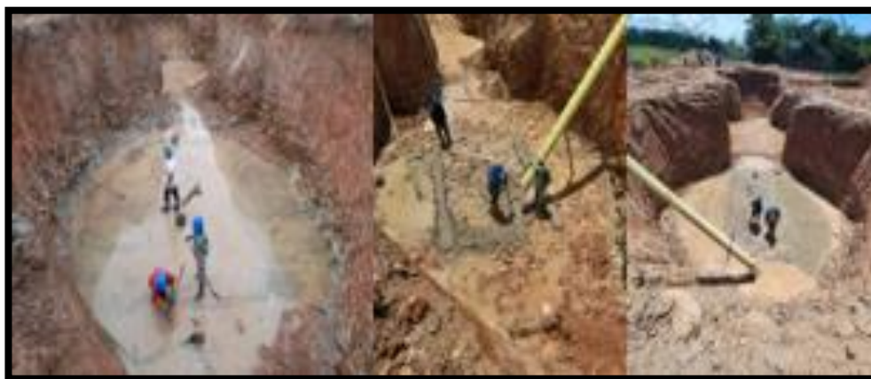
Figura 51. Construcción de los solados de limpieza para reactores. Fuente: propia.
