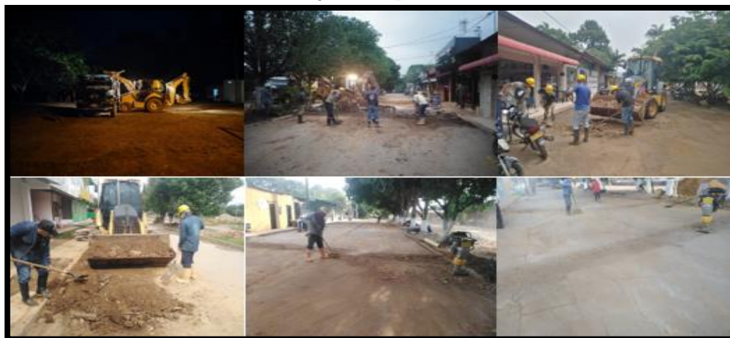
Figura 27. Realización de limpieza producto de la excavación domiciliaria. Fuente: propia.
