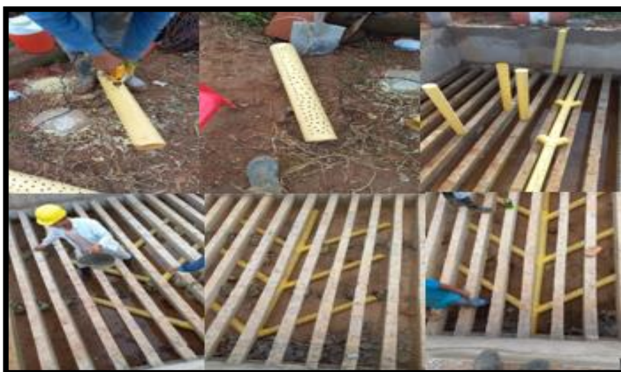
Figura 44. Perforación e instalación de tubería en lechos de secado. Fuente: propia.
