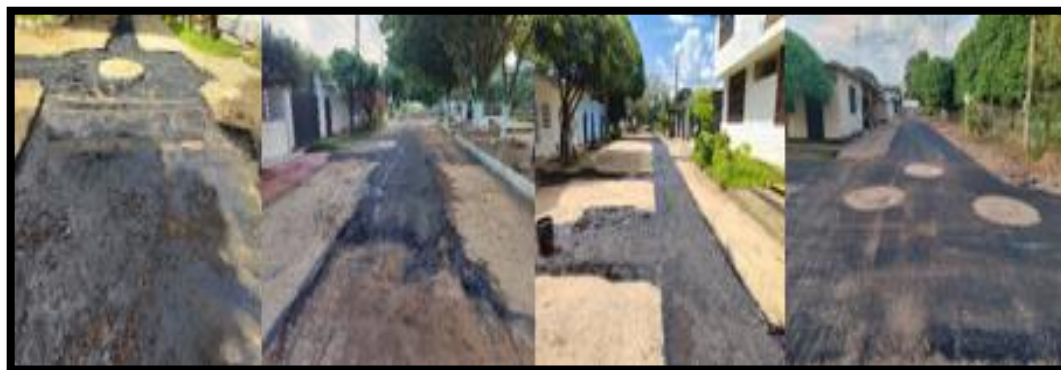
Figura 41. Riego de imprimación o emulsión para de adherencia de carpeta asfáltica. Fuente: propia.
