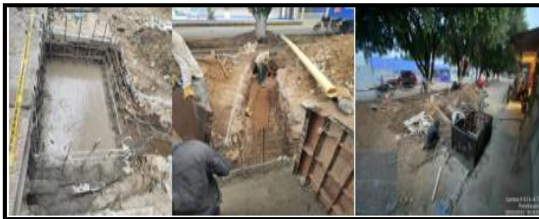
Figura 34. fundida de solado y piso para sumidero. Fuente: propia.
