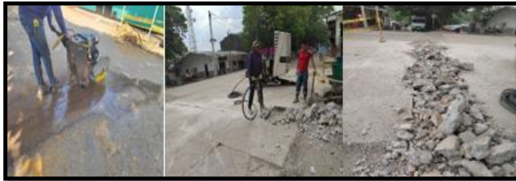
Figura 23. corte y demolición de pavimento. Fuente: propia.
