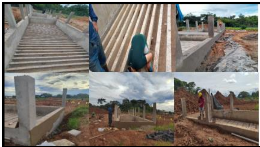
Figura 43. Resane de filos de estructuras de lechos de secado. Fuente: propia.
