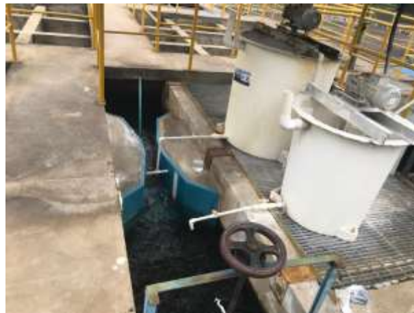
Ilustración 21. Canaleta Parshall
