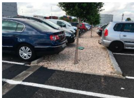
b) Trinchera de infiltración en Ribarroja
