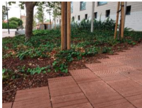
d) Pavimento cerámico permeable en Benicàssim.
