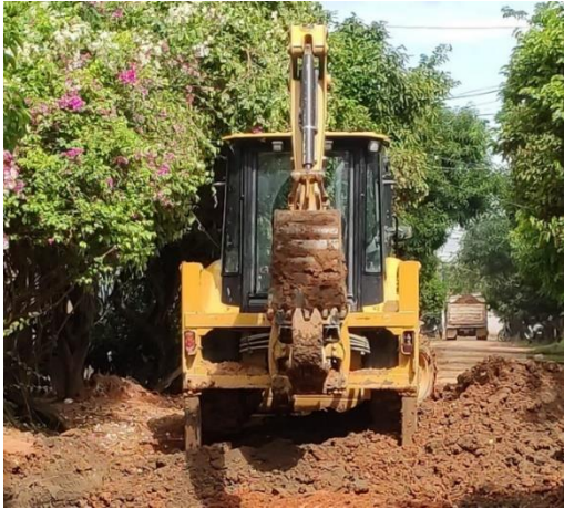
Ilustración 10. Retroexcavadora. fuente propia
