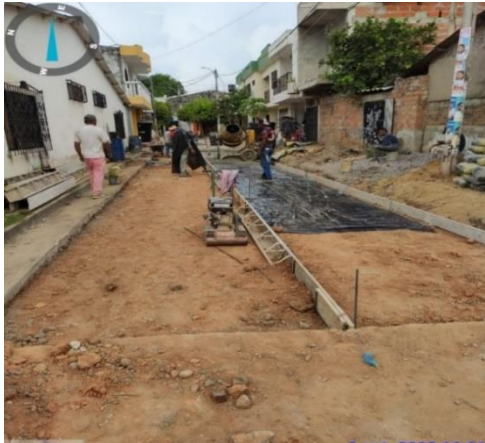
Ilustración 29. Instalación de geotextil. Fuente propia.
