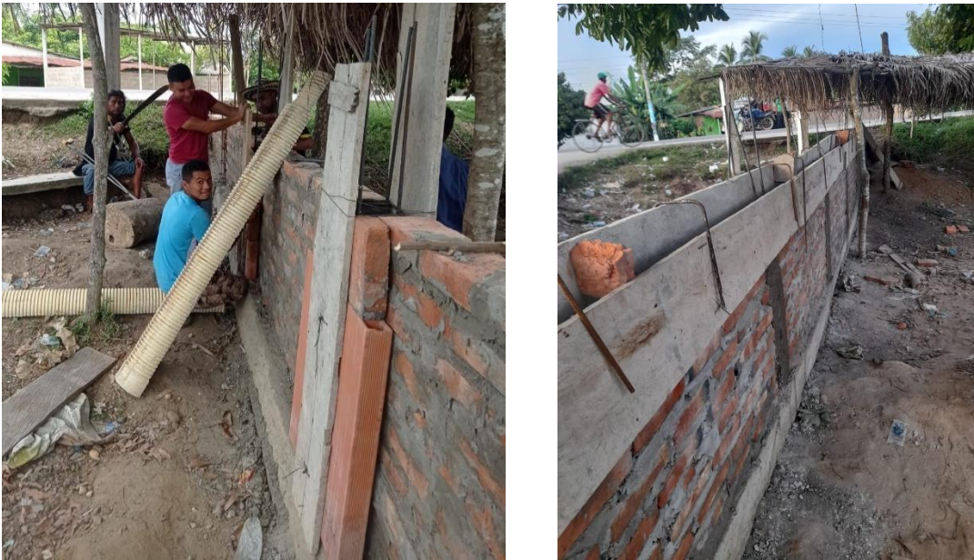
Ilustraciones 61 y 62. Muro de mampostería, Rinconada, Fuente Propia
