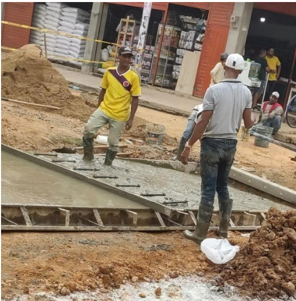
Ilustración 30. Canastillas pasa juntas. Fuente propia
