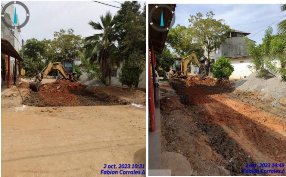
Ilustraciones.34 y 35. Excavación con maquinaria (incluye retiro). Fuente propia
