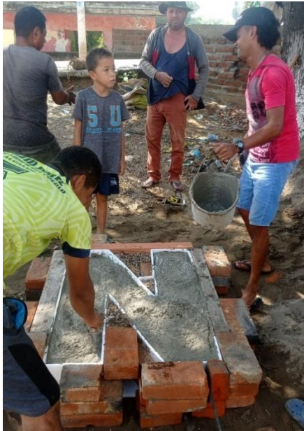
Ilustraciones 63, 64, 65 y 66. Vaciado de concreto, Rinconada, Fuente Propia
