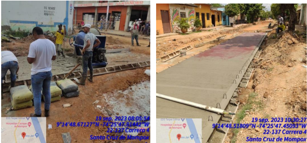
Ilustraciones 26 y 27. Vaciado de pavimento hidráulico. Fuente propia
