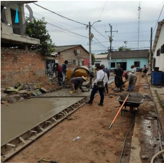
Ilustración 18 . Supervisión de reemplazo de subbase. Fuente propia
