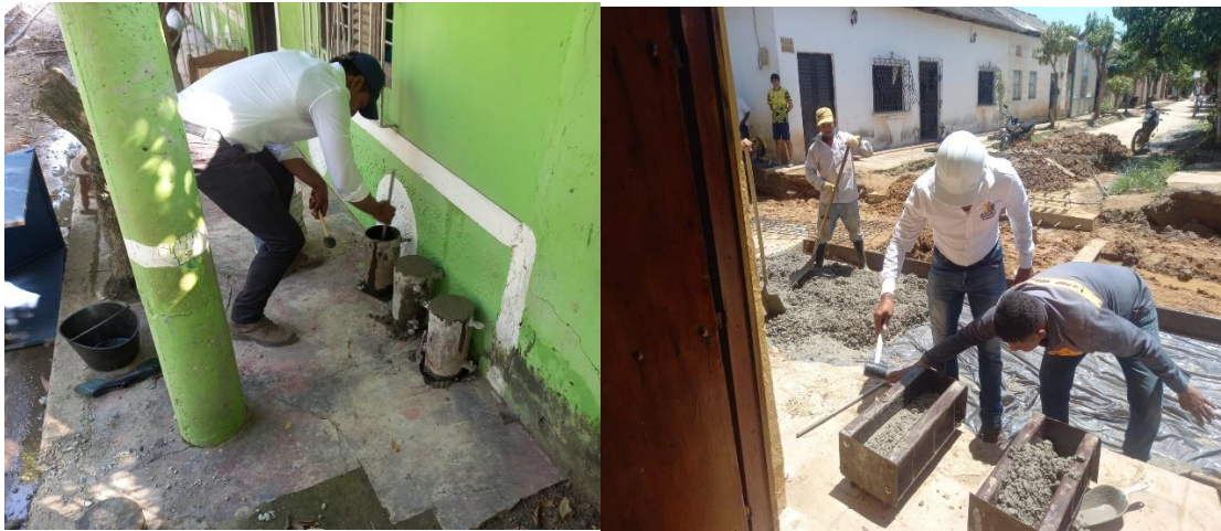
Ilustración 46 y 47. Cilindros en obra. Fuente propia
