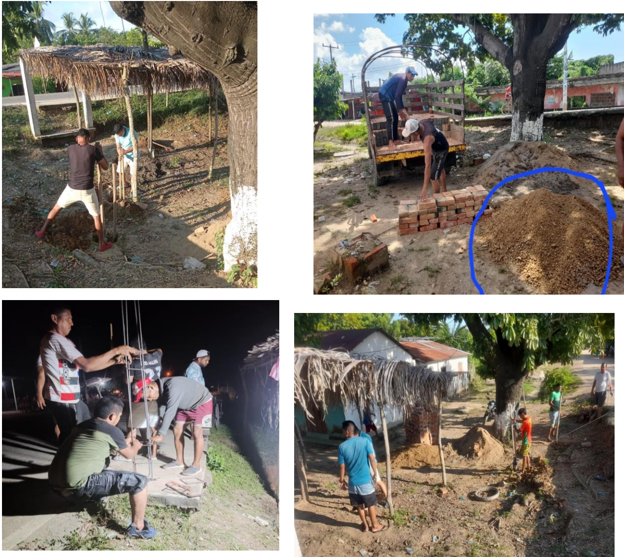
Ilustraciones 54, 55, 56 y 57. Excavaciones de obra, Rinconada, Fuente Propia
