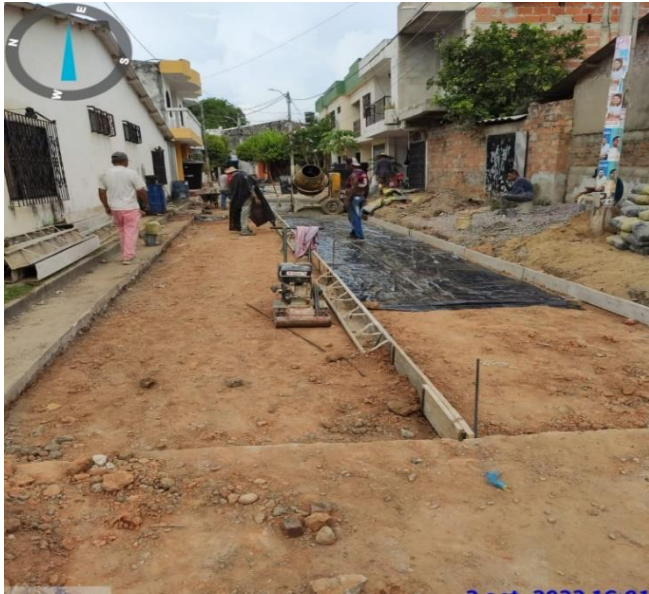
Ilustración 28. Relleno y compactación (formaleta). Fuente propia.
