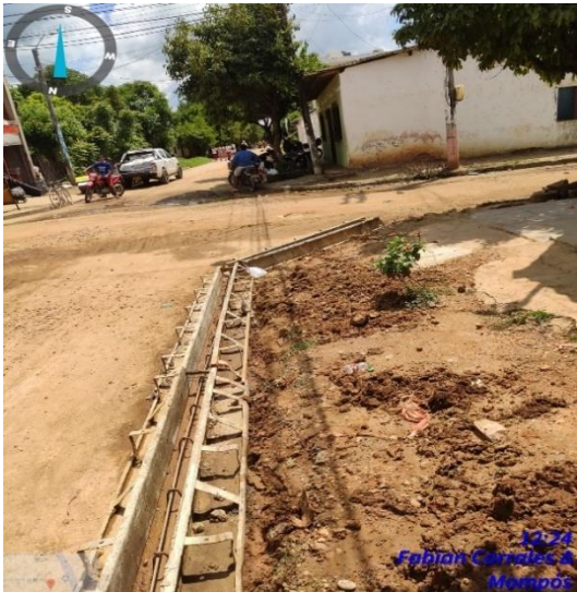
Ilustración 33. Encofrado de bordillos. Fuente propia
