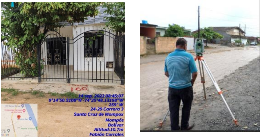
Ilustraciones 21 y 22. Localización y replanteo con equipo topográfico. Fuente propia
