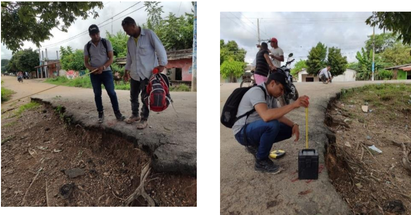
Ilustración 52 y 53. Replanteo, Fuente Propia
