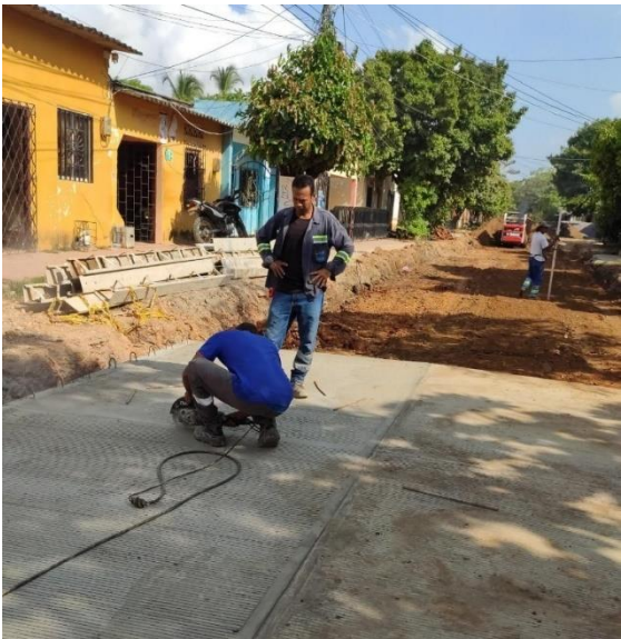
Ilustración 32. Corte de losas. Fuente propia.
