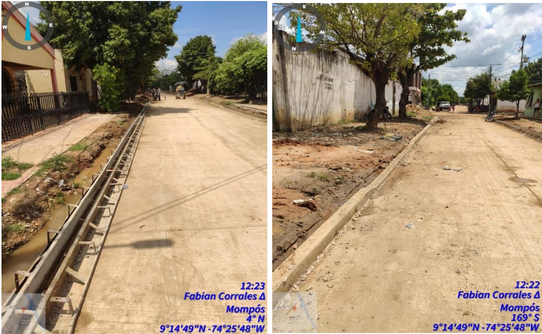
Ilustraciones 37 y 38. Bordillos construidos. Fuente propia
