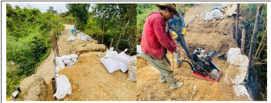
Ilustración 81. Relleno y compactación. Fuente propia.
