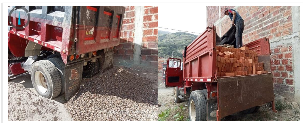
Ilustración 87. Descarga y almacenamiento material de construcción. Fuente propia.
