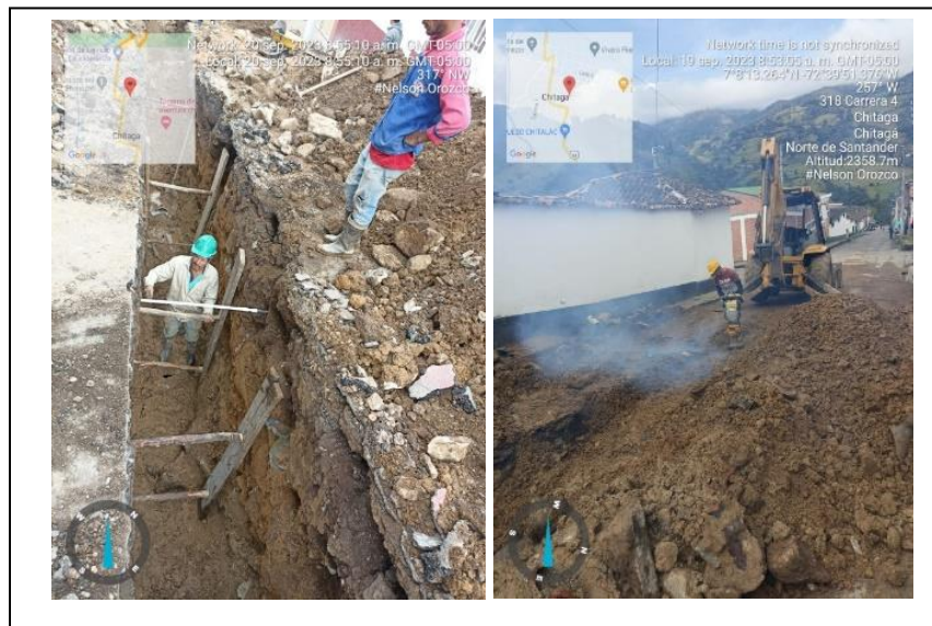
Ilustración 45. Instalación de tubería y relleno. Fuente propia.
