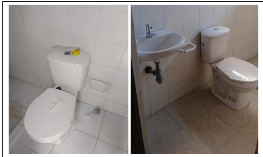
Ilustración 16. Instalación batería sanitaria. Fuente propia.
