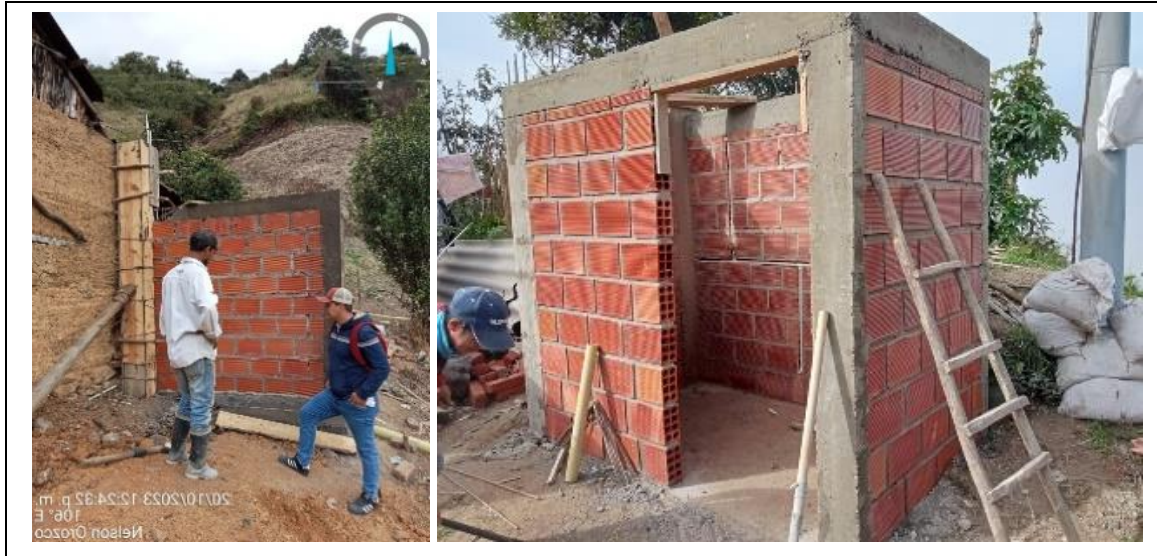
Ilustración 11. Encofrado y colado de viga corona. Fuente propia
