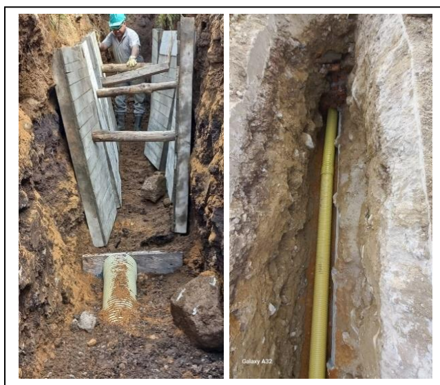
Ilustración 25. Instalación tubería sanitaria 6 pulg. Fuente propia.
