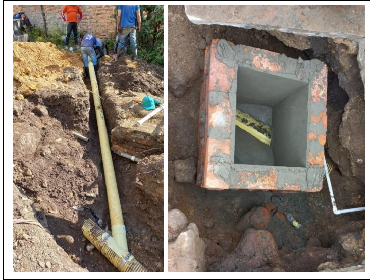
Ilustración 26. Instalación tubería sanitaria 4 pulg y caja de inspección. Fuente propia.
