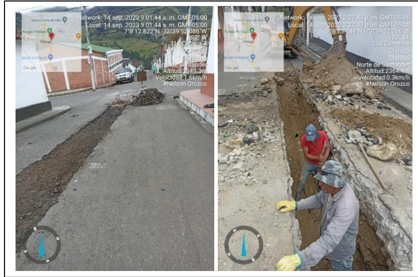
Ilustración 44. Excavación manual y con maquinaria. Fuente propia.
