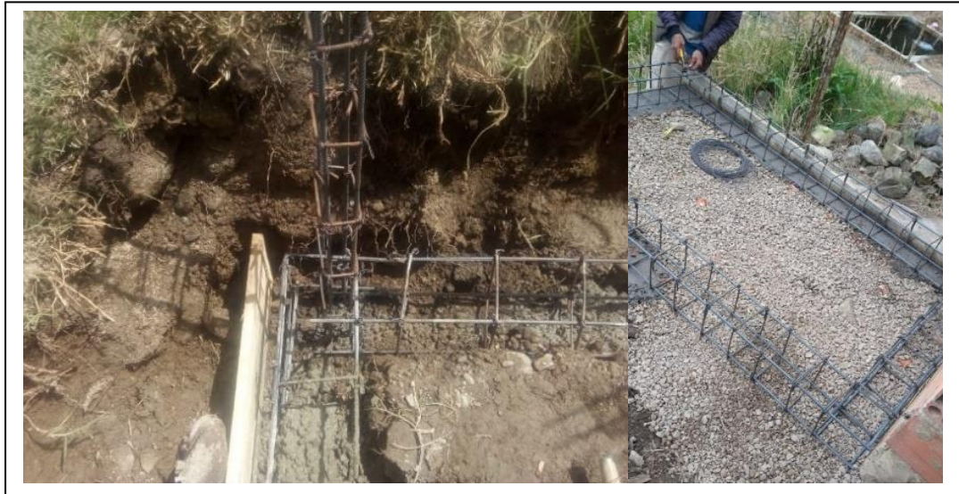
Ilustración 6. Figurado de acero. Fuente: propia.
