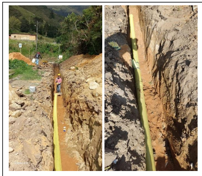
Ilustración 31. Instalación tubería 6 pulg. Fuente propia.
