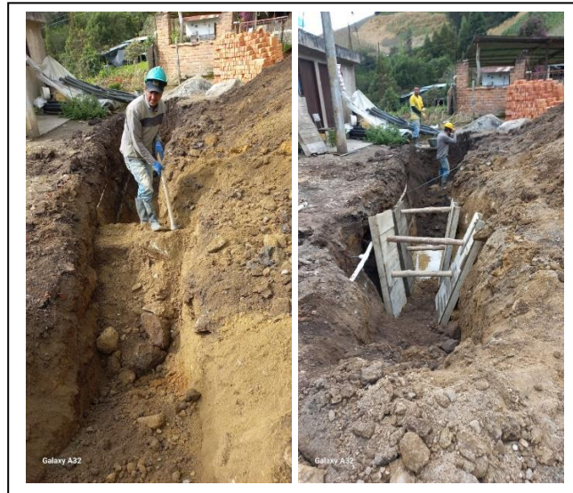
Ilustración 36. Excavación manual y con maquinaria. Fuente propia.
