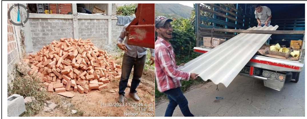
Ilustración 88. Descargue y almacenamiento material de construcción. Fuente propia.
