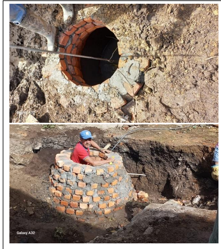
Ilustración 33. Construcción pozo de inspección. Fuente propia.
