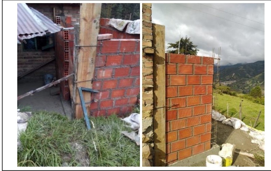
Ilustración 10. Encofrado y colado de columnas, vereda Hato grande. Fuente propia.
