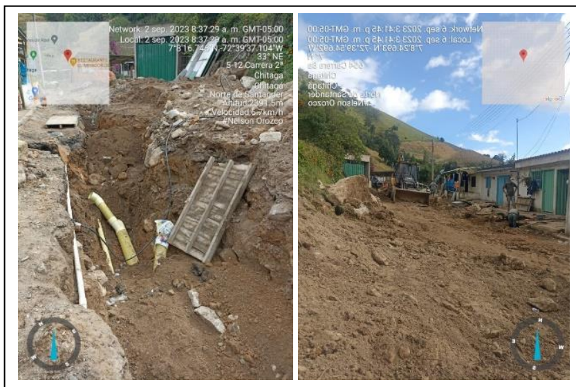
Ilustración 39. Relleno y compactación. Fuente propia.
