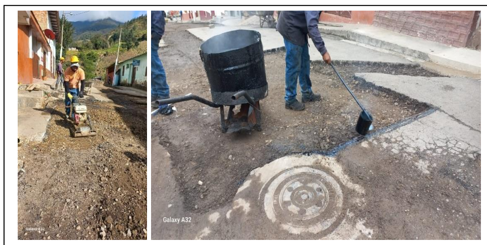
Ilustración 48. Compactación de material. Fuente propia.
