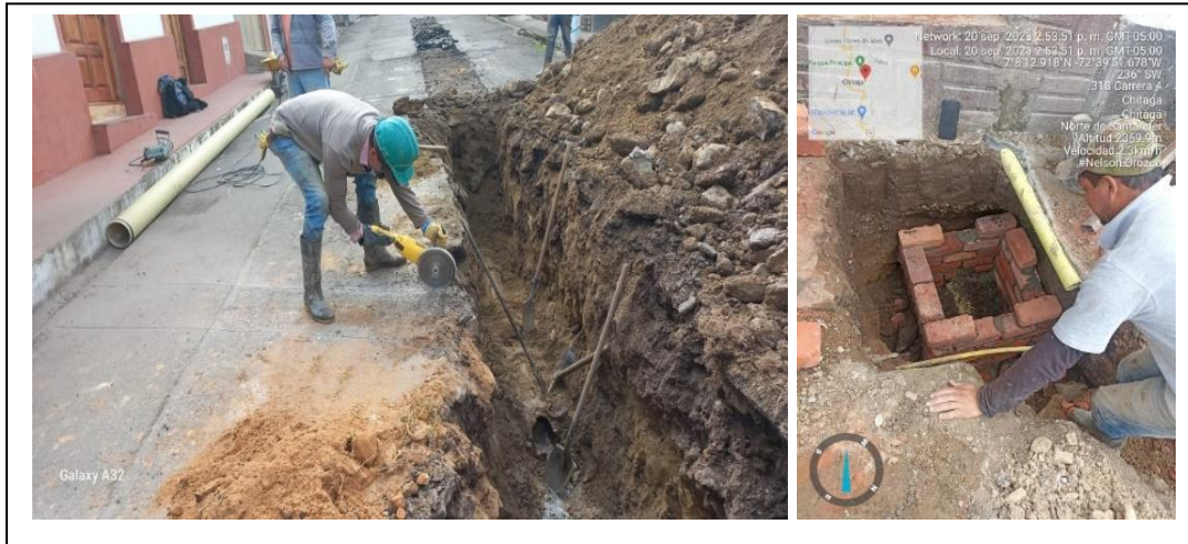
Ilustración 46. Acometidas y cajas de inspección. Fuente propia.
