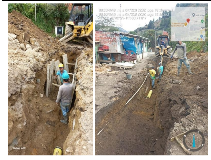
Ilustración 37. Instalación tubería 6 pulg. Fuente propia.
