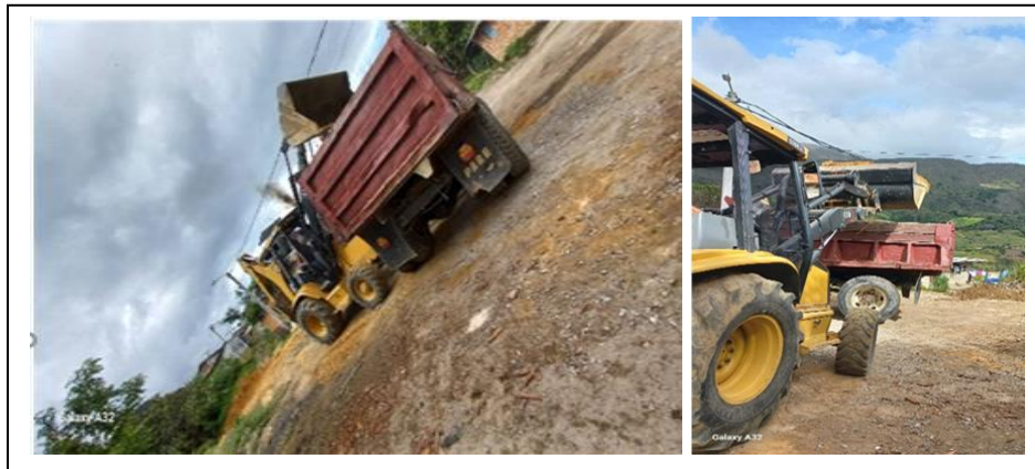
Ilustración 28. Retiro de escombros. Fuente propia.
