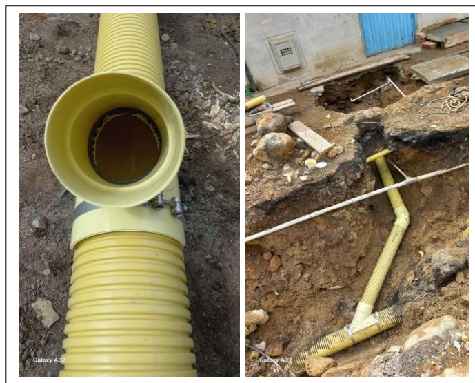
Ilustración 38. Instalación tubería 4 pulg y silla yee. Fuente propia.
