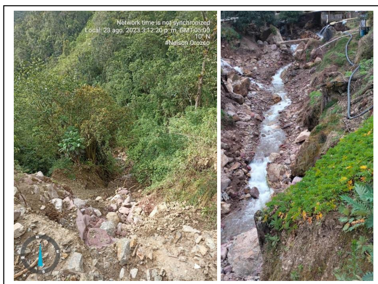
Ilustración 66. Antes y después del dragado de la quebrada. Fuente propia.
