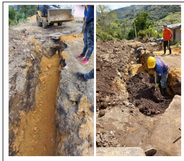
Ilustración 27. Relleno con material de excavación y compactación. Fuente propia.
