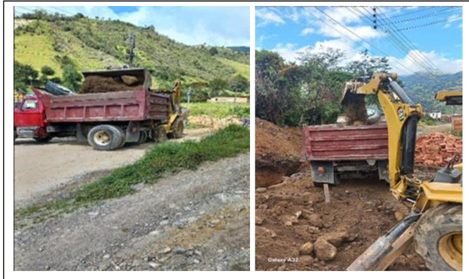
Ilustración 34. Retiro de escombros. Fuente propia.
