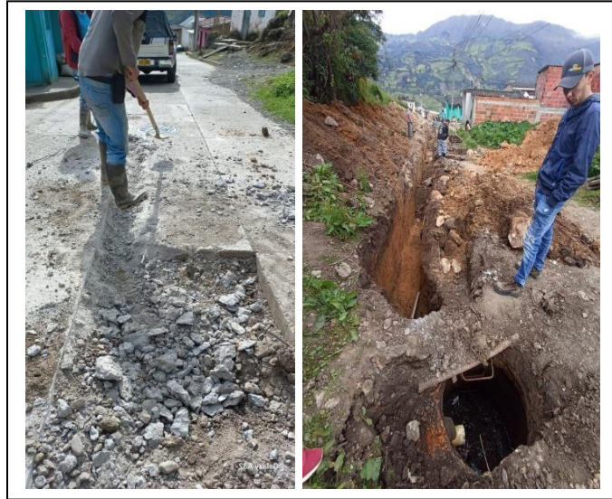
Ilustración 30. Excavación manual y con maquinaria. Fuente propia.
