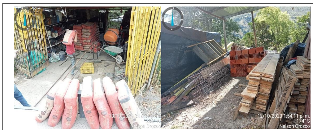
Ilustración 84. Descargue y almacenamiento material de construcción. Fuente Propia.
