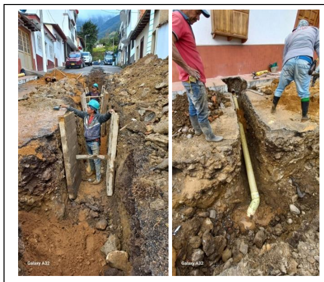
Ilustración 47. instalación de tubería. Fuente propia.
