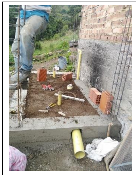
Ilustración 8. Instalación tubería sanitaria. Fuente propia.
