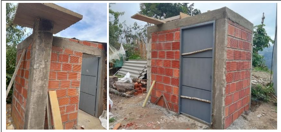
Ilustración 13. Instalación puerta metálica. Fuente propia.
