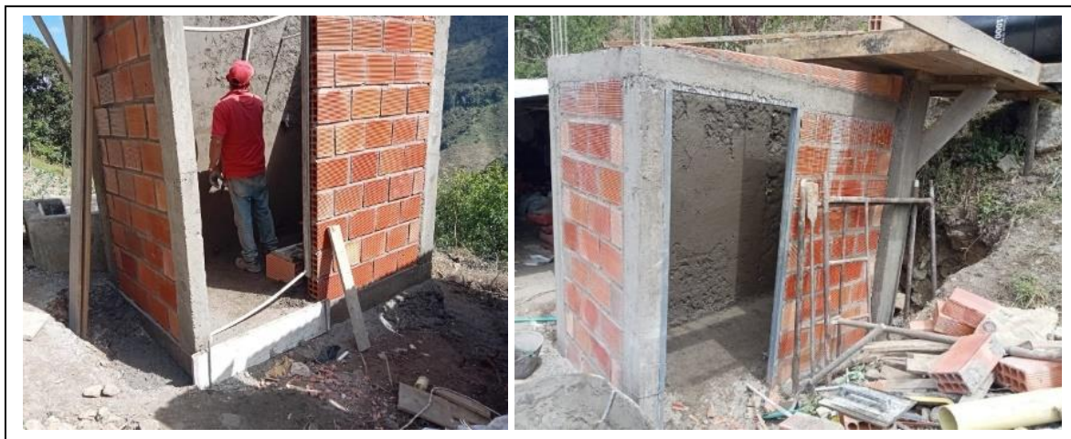
Ilustración 12. Encofrado y colado placa tanque, pañete interior. Fuente Propia.
