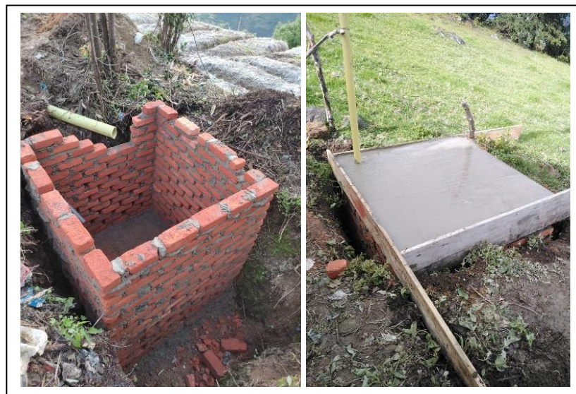
Ilustración 17. Construcción pozo séptico. Fuente propia.
