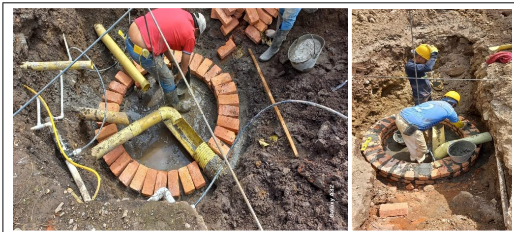
Ilustración 41. Construcción pozo de inspección. Fuente propia.
