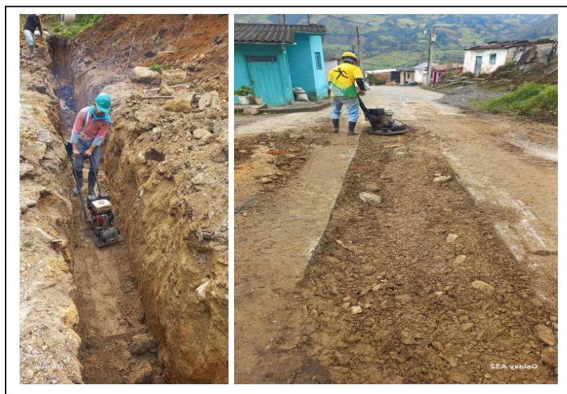
Ilustración 32. Relleno y compactación. Fuente propia.
