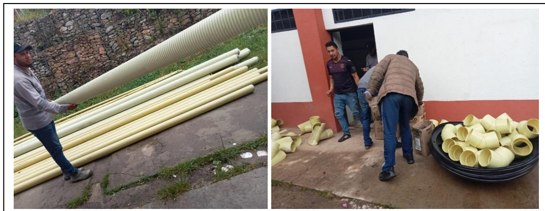
Ilustración 85. Descarga y almacenamiento tubería de 6 pulg y 4 pulg con accesorios. Fuente propia.
