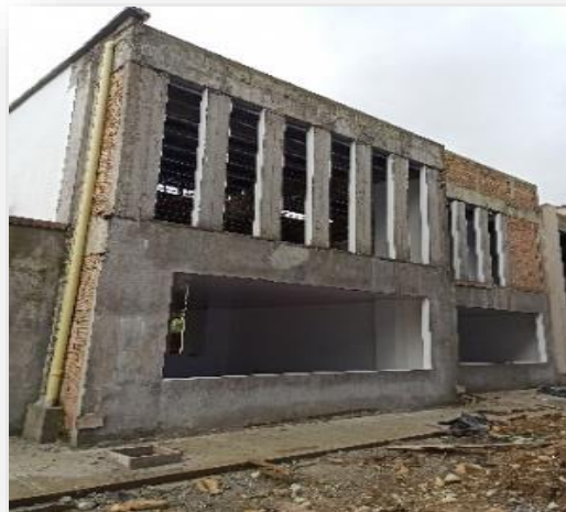
Figura 42. Armado bajantes aulas
