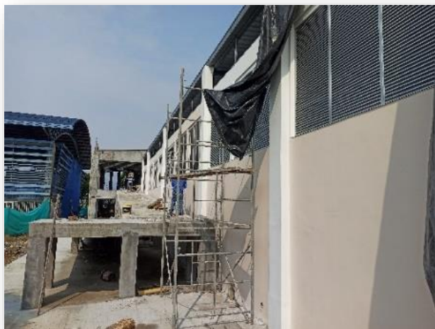
Figura 41. Estuco bajantes auditorio
