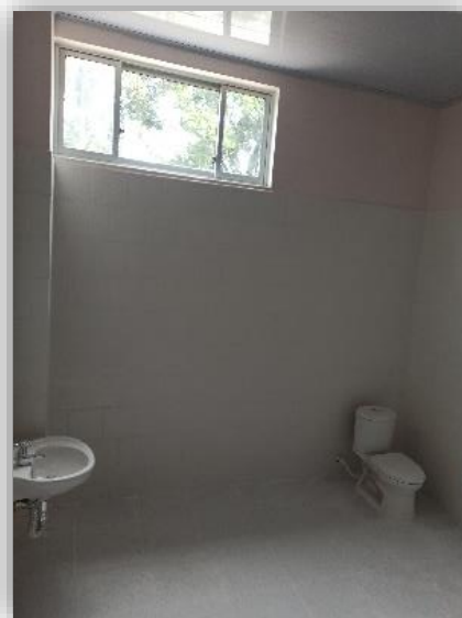
Figura 54. Instalación de baños
