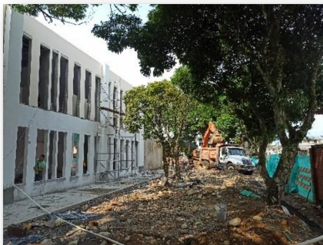
Figura 45. Estuco y Pintura exterior aulas
