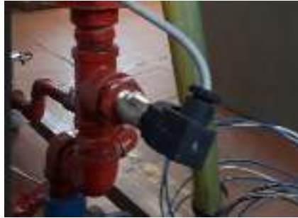
Ilustración 20 Sensor De Presión SITRANS P250 (7MF1641)
