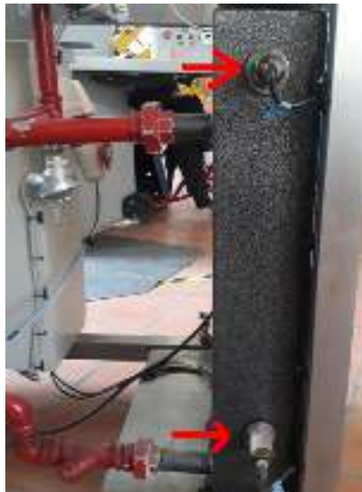
Ilustración 21 Sensores De Nivel SITRANS LVL100.
