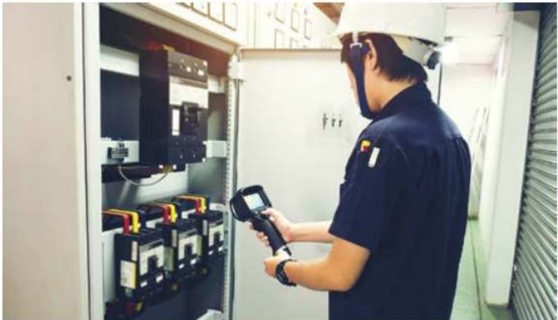
Ilustración 6 Cámara de Termografía - Medición De Temperatura.
