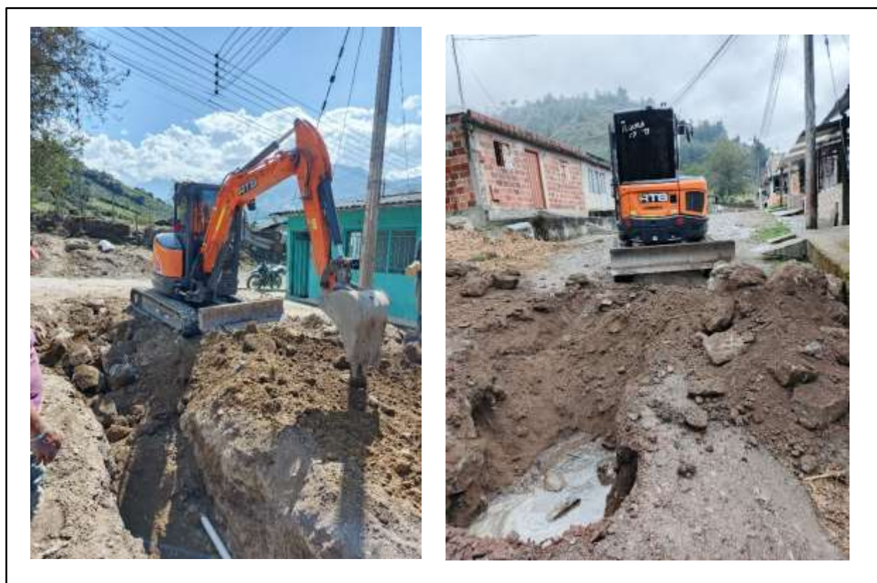
Figura 65. Excavación mecánica.
