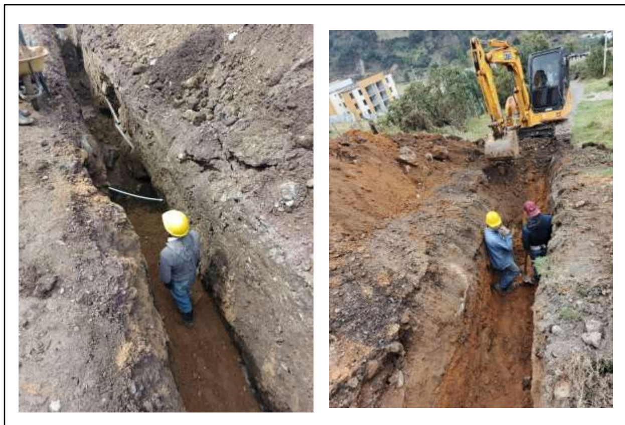
Figura 44. Excavación manual.
