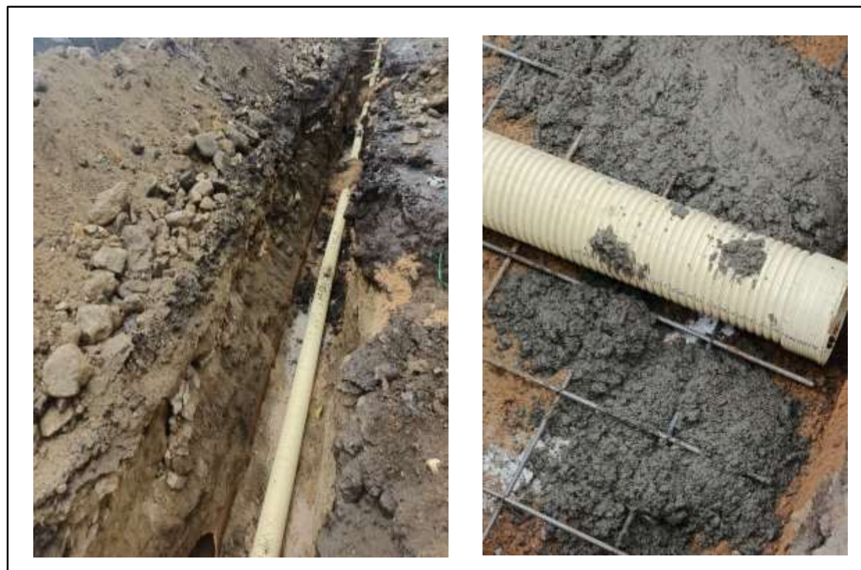
Figura 68. Suministro e instalación de tubería.
