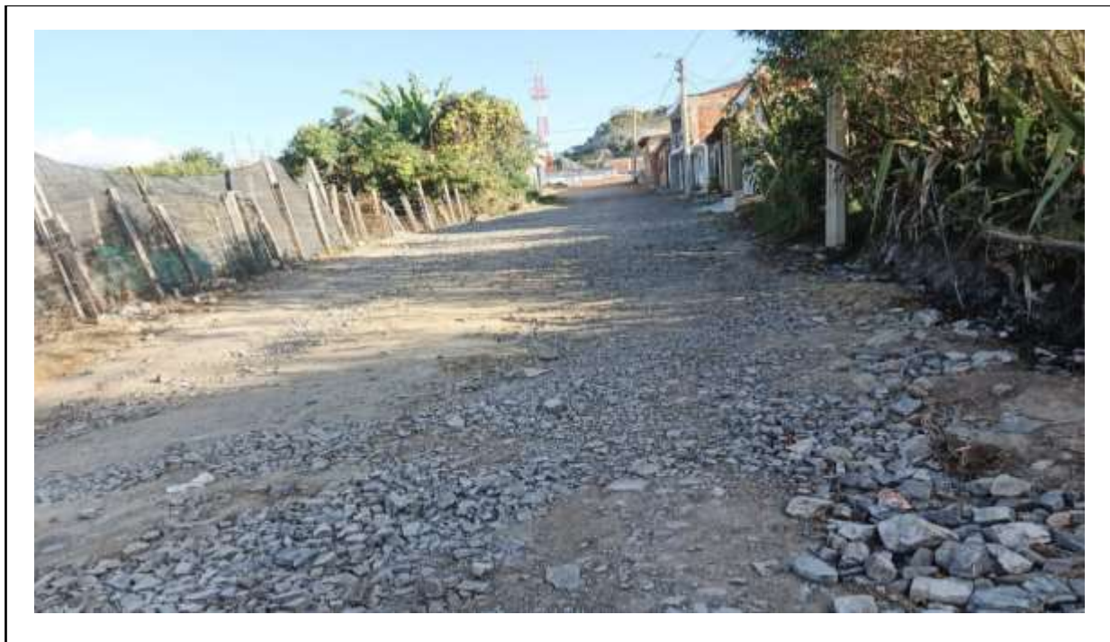
Figura 8. Tramo vial reemplazo de alcantarillado.
