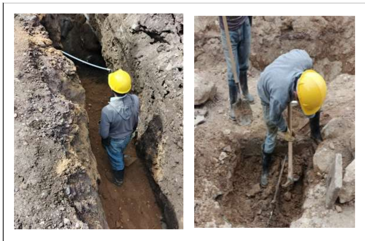
Figura 66. Excavación manual.
