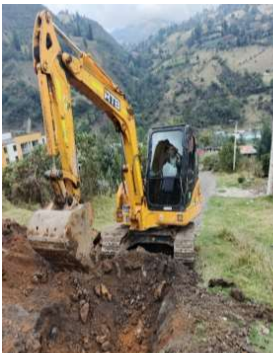
Figura 43. Excavación mecánica.
