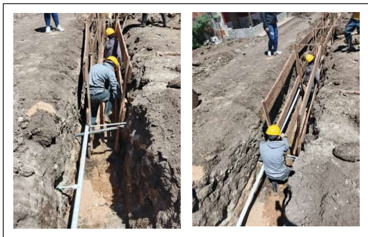
Figura 45. Entibado de madera h > 1.5 m.
