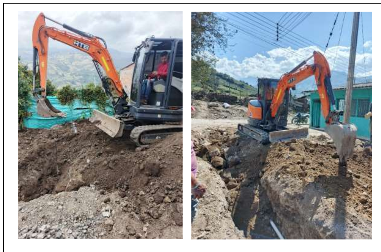
Figura 72. Compactación de material.
