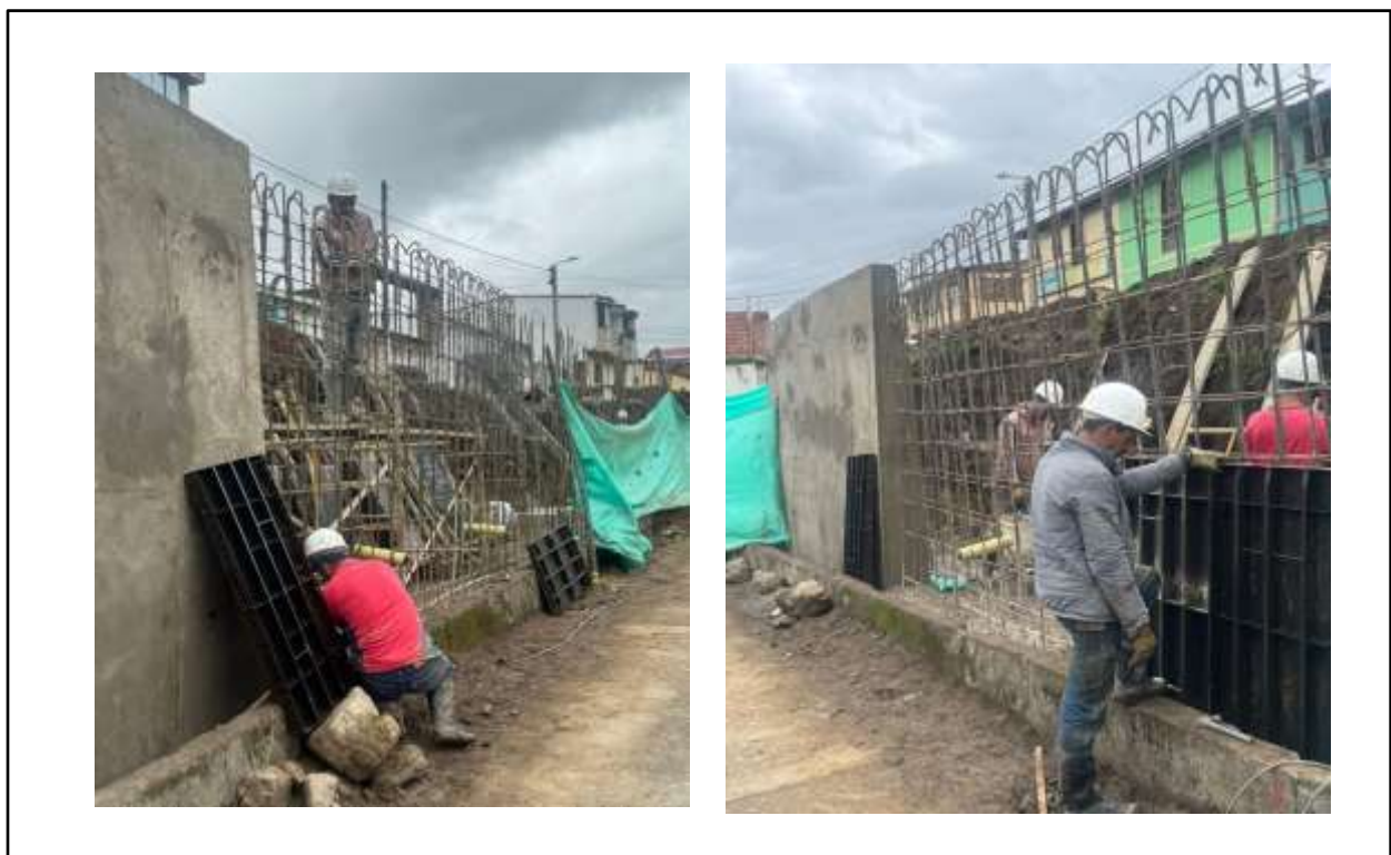
Figura 85. Muro de contención con acero de refuerzo.
