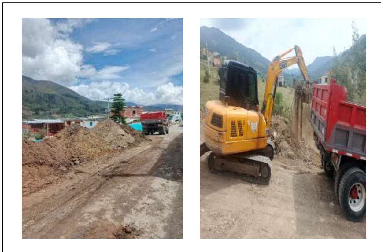
Figura 82. Retiro de material excavado.
