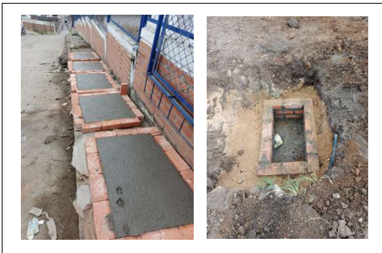
Figura 69. Construcción cajas de inspección.
