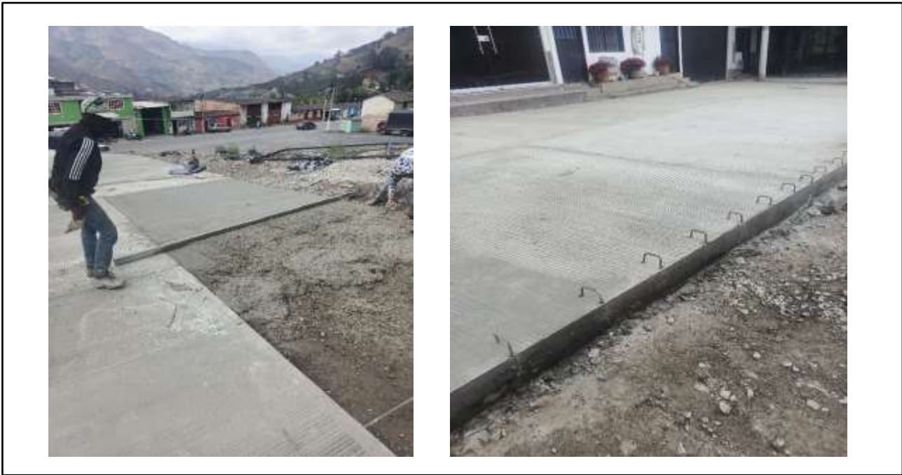
Figura 146. Visitas a obra.
