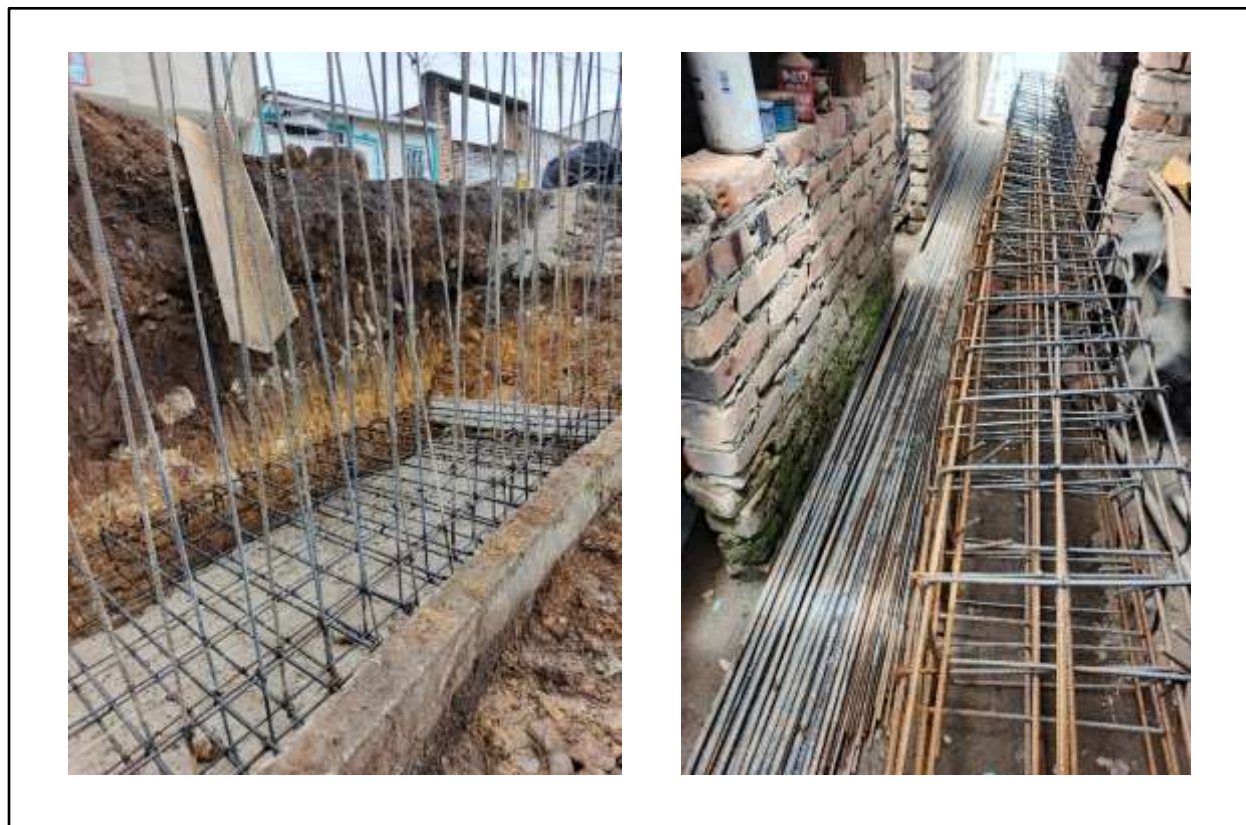
Figura 83. Acero de refuerzo.
