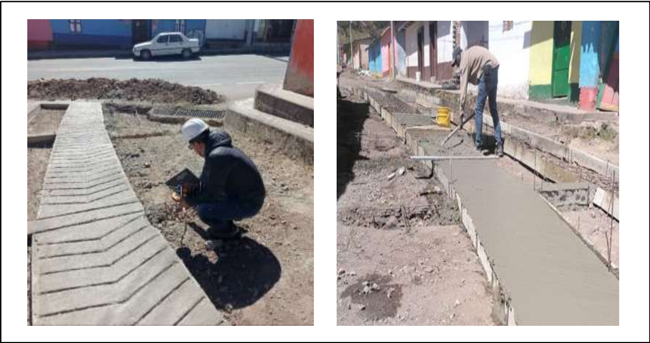
Figura 154. Visita de obra.
