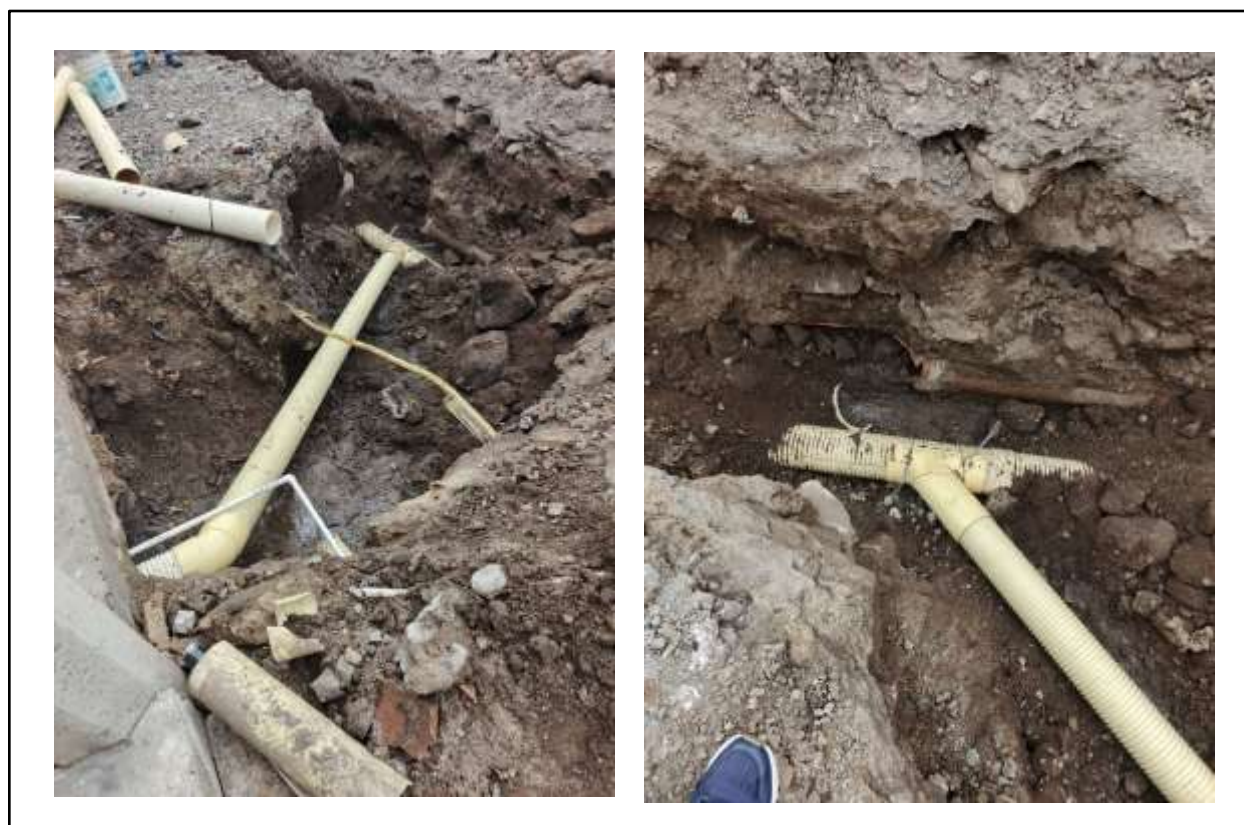
Figura 70. Suministro e instalación silla yee.
