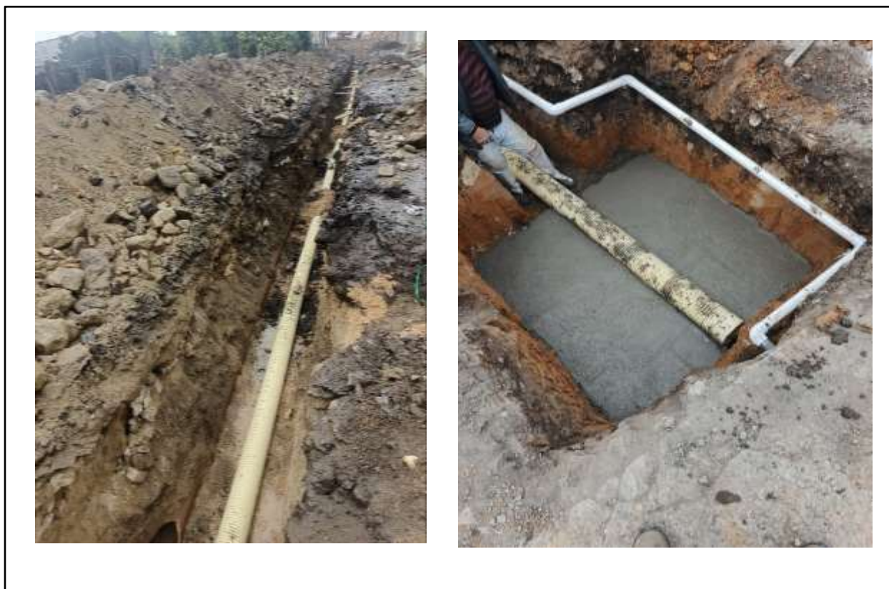
Figura 58. Suministro de tubería.
