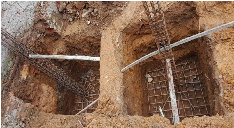
Figura 5. Cimentación, zapatas aisladas.
