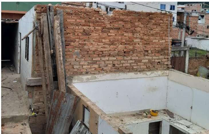
Figura 4. Fase de demolición, primera etapa.
