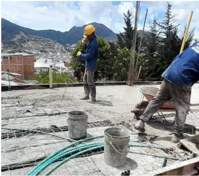
Figura 7. Vibrado manual del vaciado de concreto.
