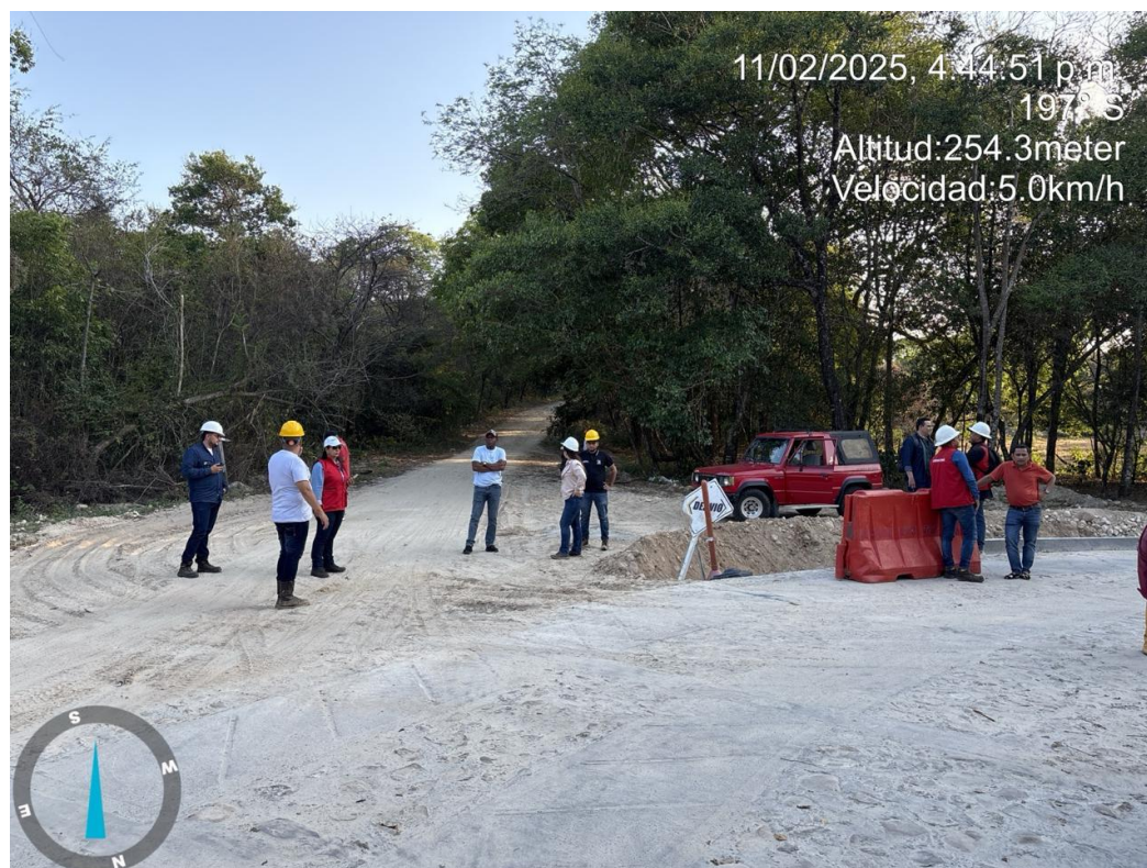
Figura 33. Visitas de supervisión
