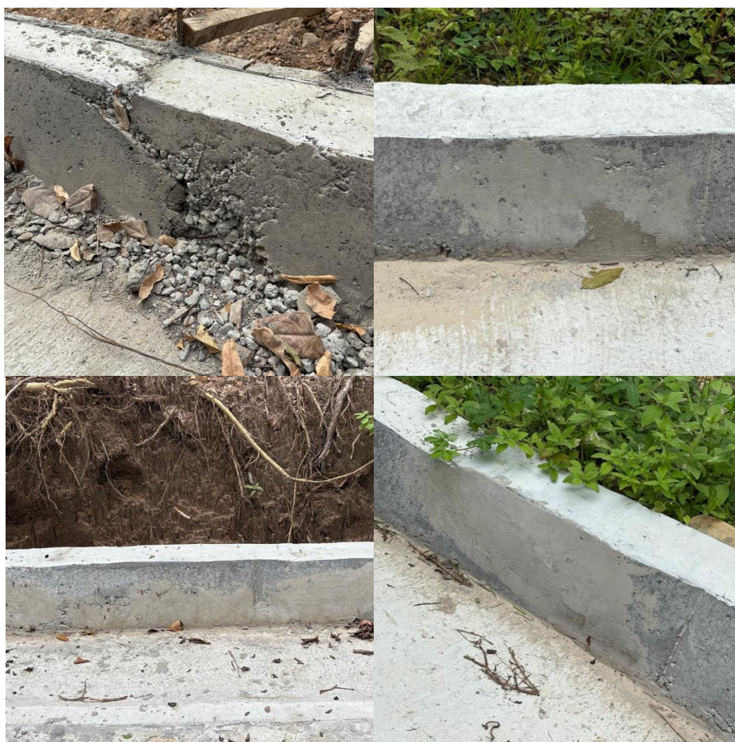
Figura 35. Comparación antes y después de los acabados de los bordillos
