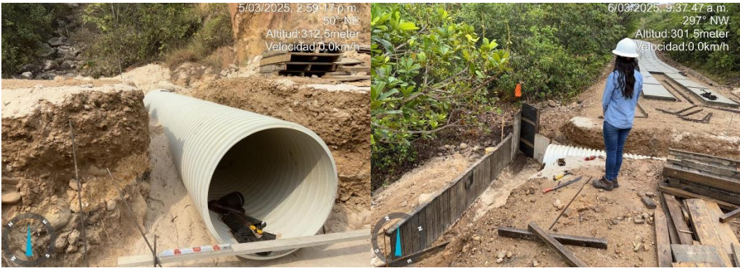
Figura 26. Evidencia construcción de alcantarillas
