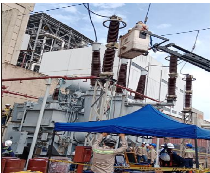
Ilustración 25 fin de la instalación de la puesta a tierra temporal
