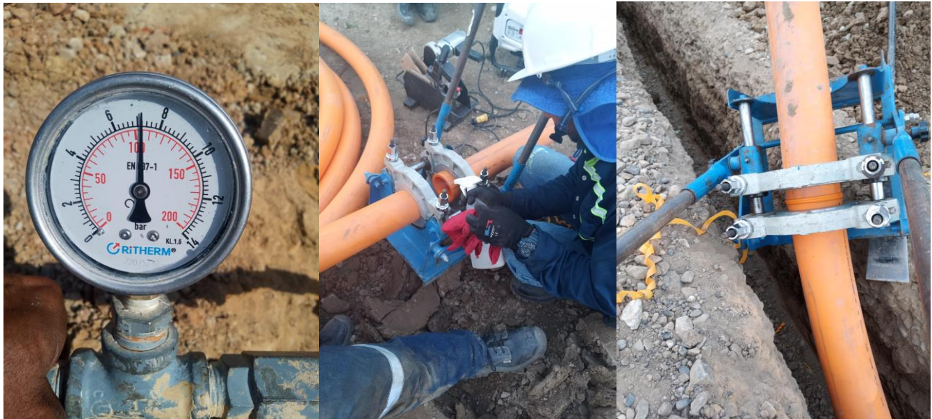
Ilustración 11. Pegas a termofusión y prueba de hermeticidad
