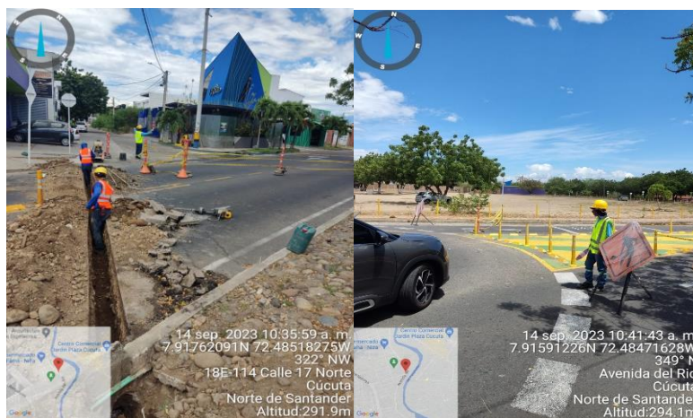
Ilustración 4. Excavación de zanja y señalización de vía
