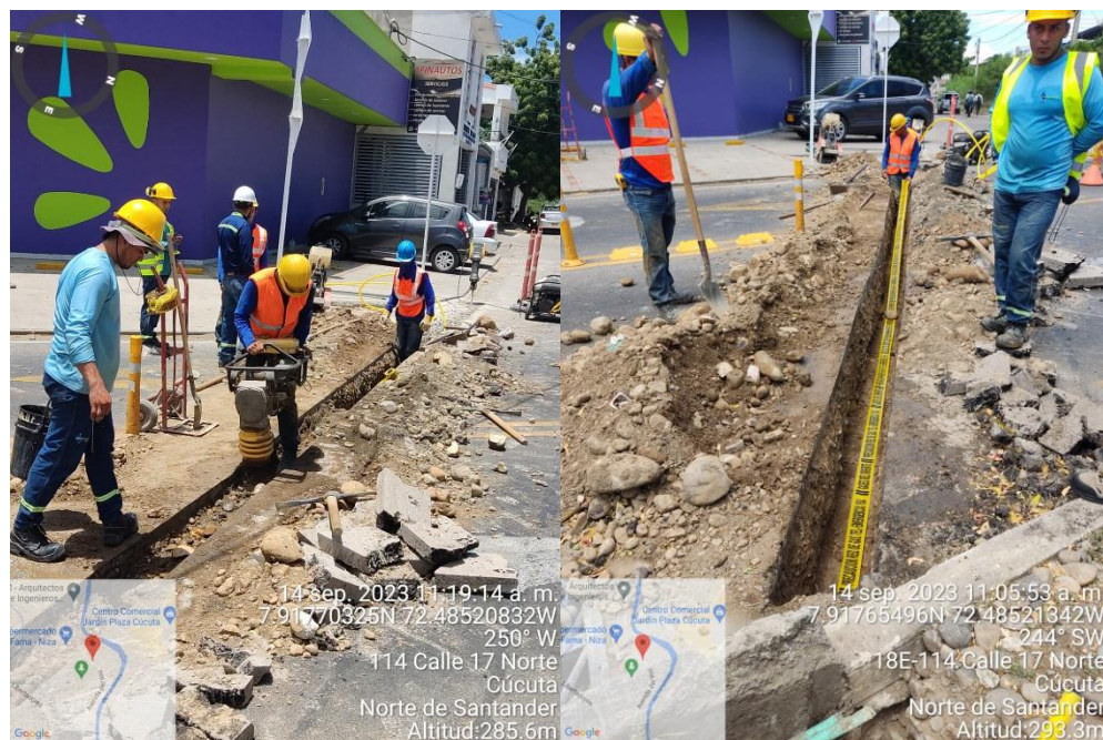
Ilustración 5. Tendido de red y compactación del relleno
