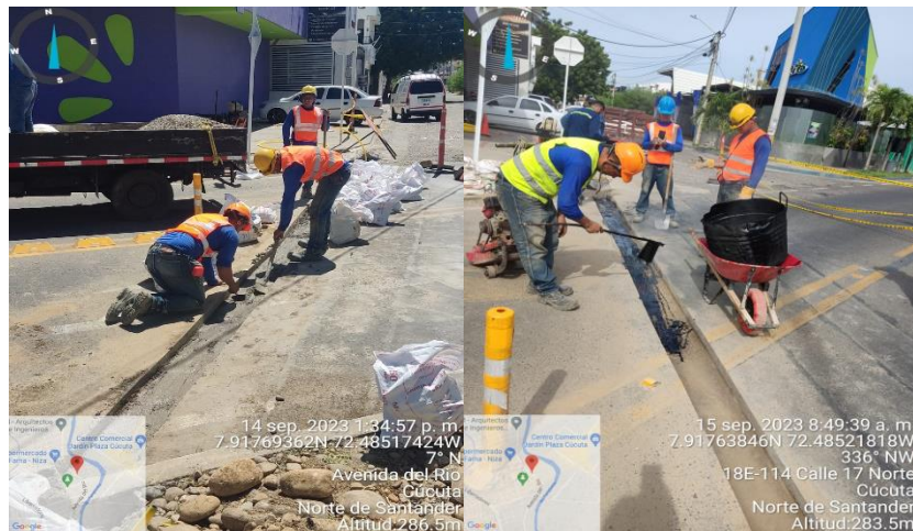
Ilustración 6. Solado y ligante asfáltico para recuperación de vía en asfalto
