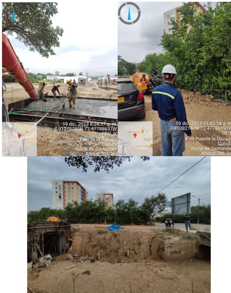
Ilustración 13. Perforación Horizontal Dirigida en proyecto Bosques del Este
