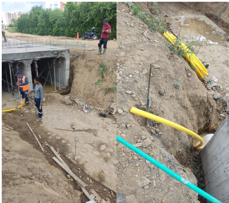
Ilustración 15. Instalación de la tubería con diámetro de 2" IPS PE80 en la perforación realizada.
