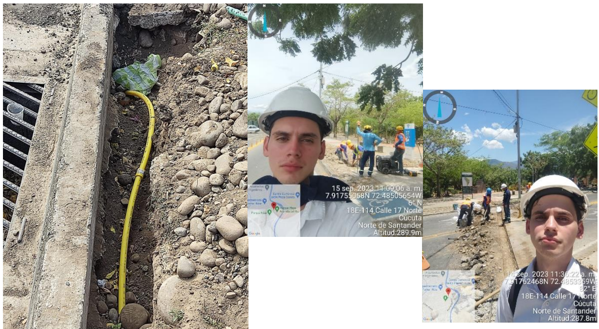
Ilustración 8. Pegas a termofusión y supervisión de actividades
