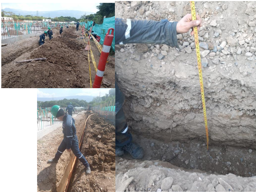
Ilustración 10. Excavación y tendido de Troncal 110mm
