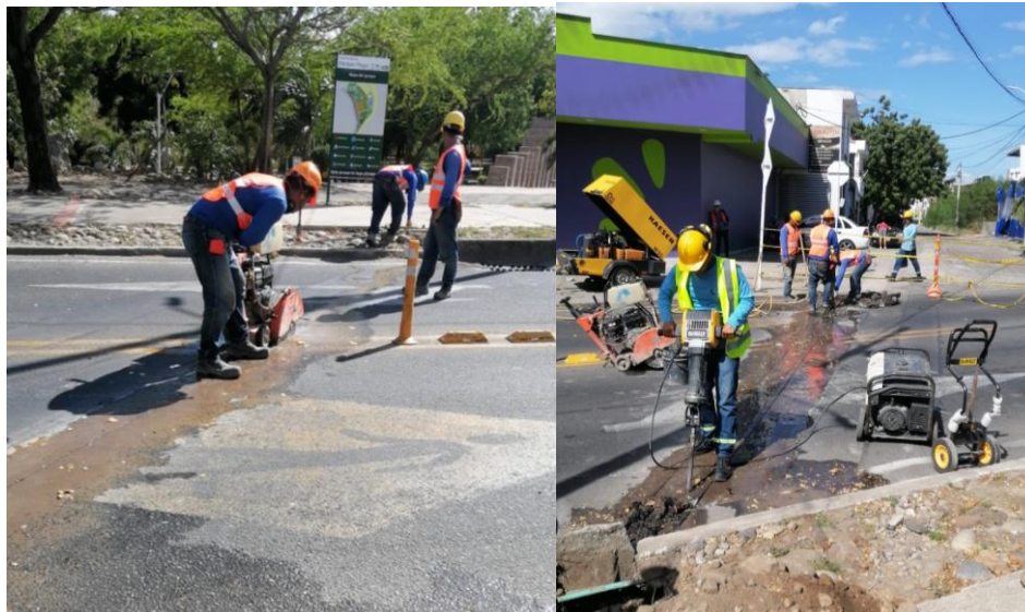
Ilustración 3. Corte y rotura de vía en asfalto Fuente: Archivos GDO-Proyecto Parque Playa
