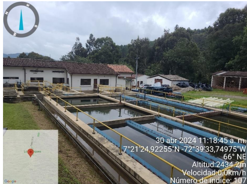
Figura 14 Planta de Tratamiento de Agua Potable - Cariongo.
