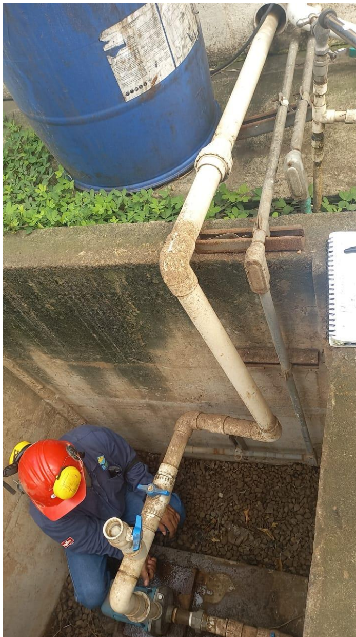
Ilustración 22 Levantamiento arquitectónico - Caja de bombeo
