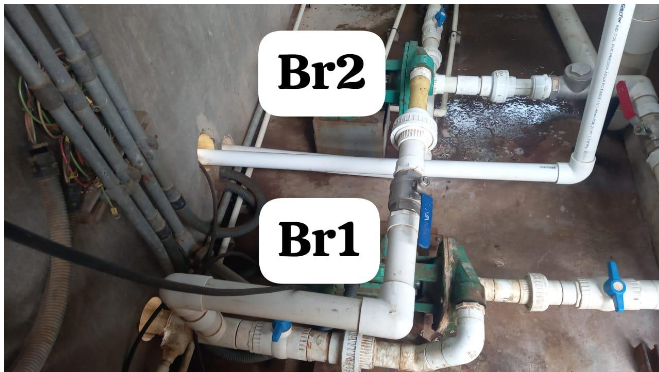
Ilustración 23 Levantamiento arquitectónico - Sistema de recirculación por medio de bombeo
