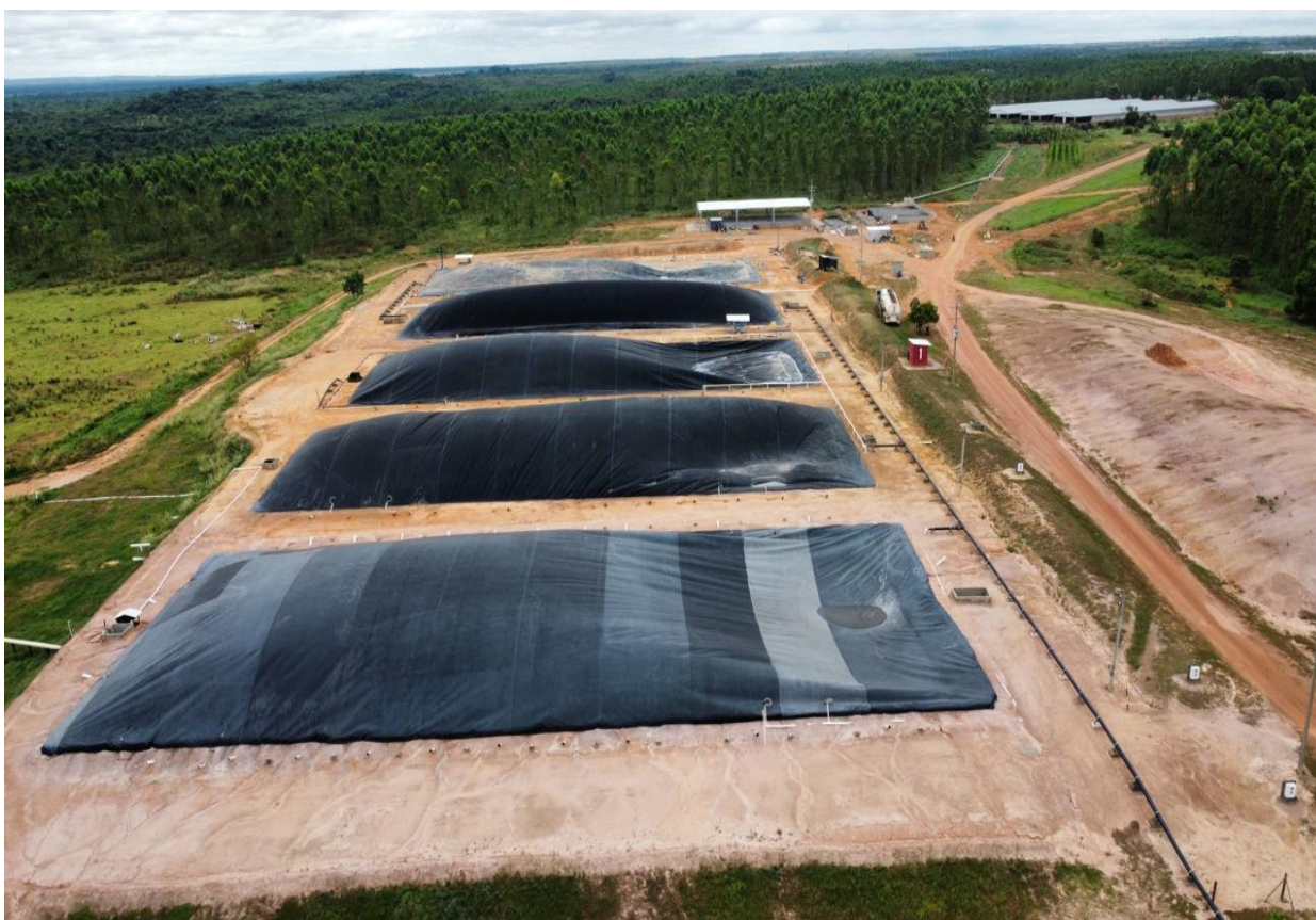
Ilustración 50 Disminución de los biodigestores
