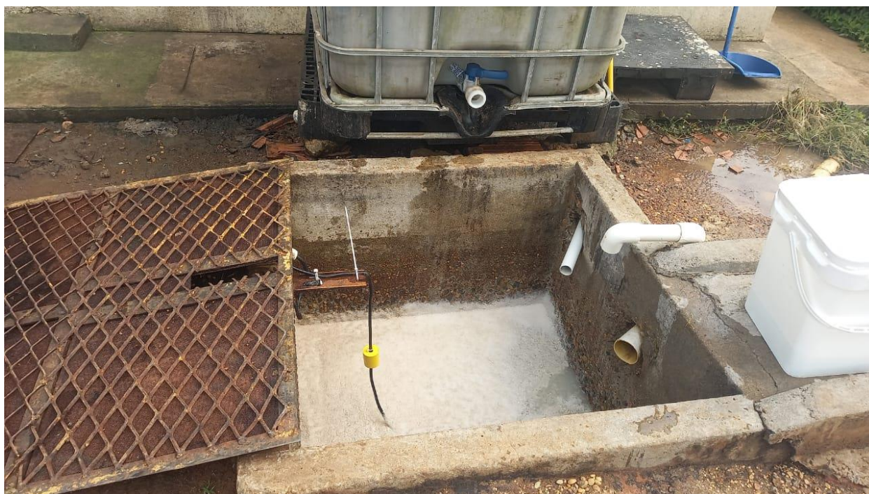
Ilustración 21 Levantamiento arquitectónico - Caja de descargue aguas residuales
