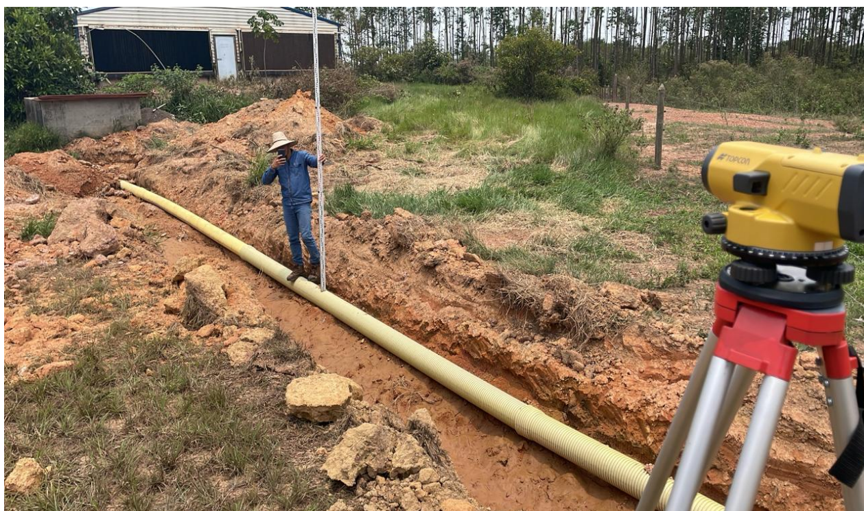
Ilustración 42 Toma de niveles para reajuste de pendiente
