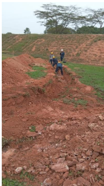
Ilustración 47 Retiro de material sobrante y preparación del terreno
