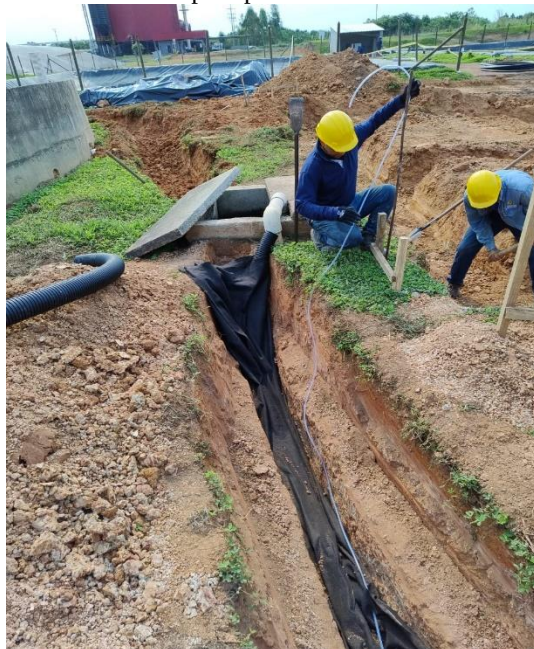
Ilustración 48 Toma de niveles para la pendiente de la tubería del drenaje francés e instalación de geo membrana para protección
