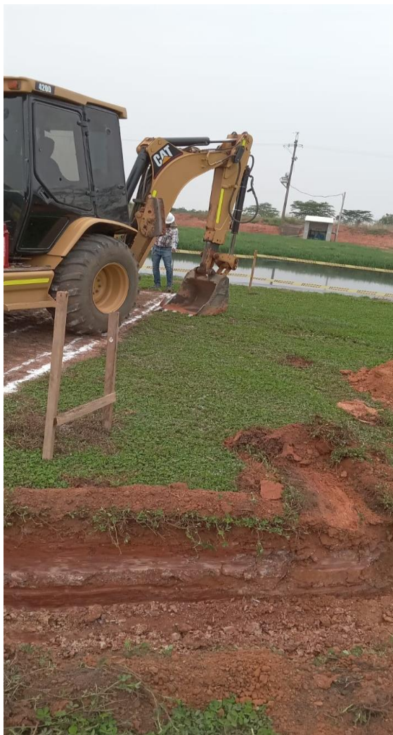
Ilustración 45 Excavación para drenaje francés
