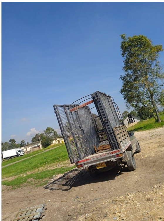
Ilustración 47. Avance Obra SENA Mosquera – Malla eslabonada en sitio.
