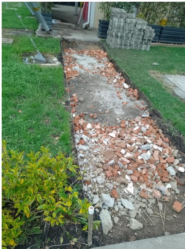
Ilustración 34. Excavación y Replanteo zona posterior.
