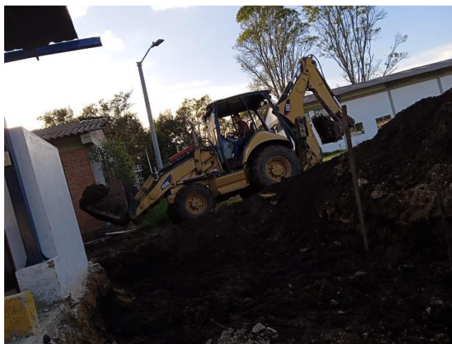
Ilustración 31. Avance Obra SENA Mosquera, Excavación y Replanteo para andén.
