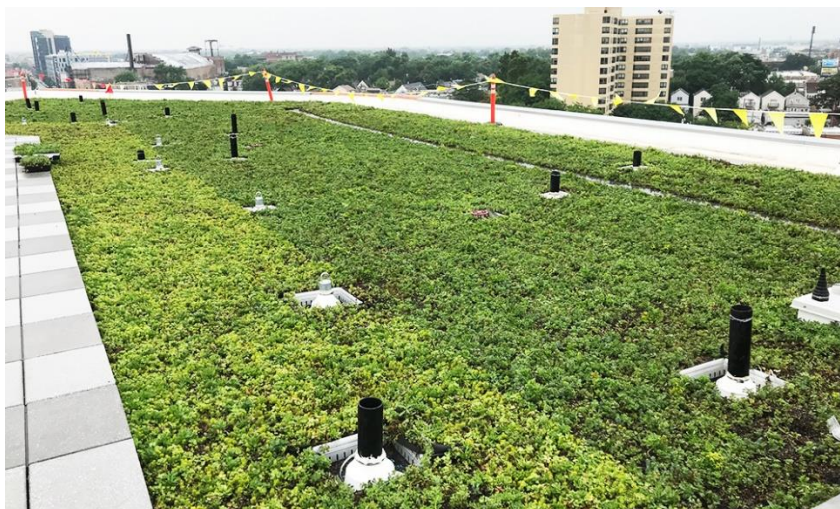
Techo Verde de Sedum
