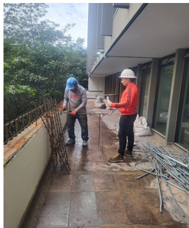
Ilustración 39 Revisión del figurado en obra del acero de refuerzo. Fuente: Propia
