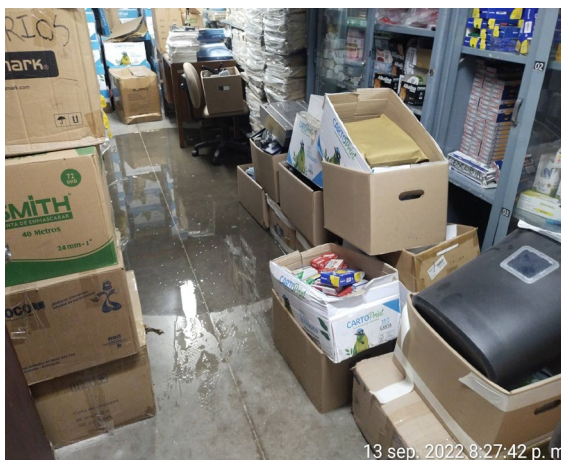
Ilustración 60 Pérdidas materiales causadas por la rotura de la tubería que ocasiono la inundación del sótano. Fuente: Propia.
