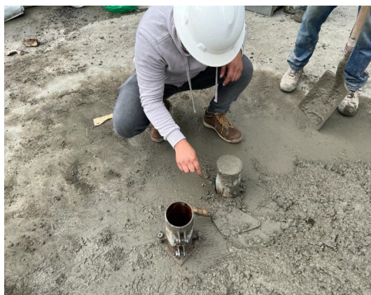
Ilustración 43 Toma de muestra de cilindros para ensayo de resistencia. Fuente: Propia.
