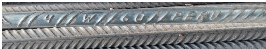
Ilustración 37 Verificación visual de la calidad del acero Fuente: Propia.
