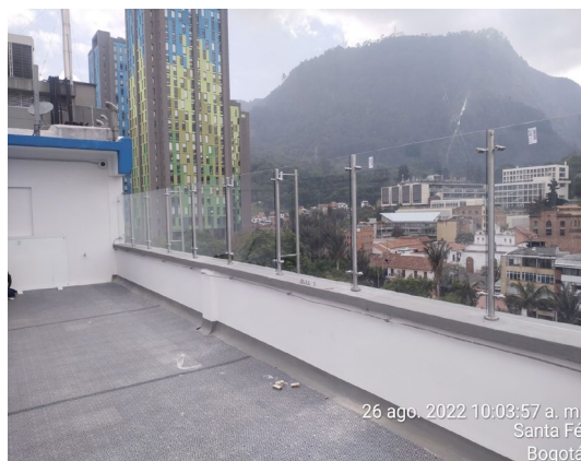
Ilustración 33 Cerramiento en vidrio instalado sobre alfajía. Fuente: Propia.
