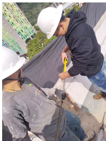
Ilustración 40 Inspección de longitud de anclaje de barras longitudinales para columnetas de confinamiento. Fuente: Propia.
