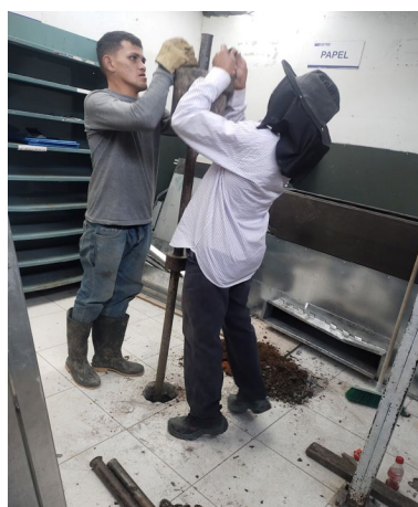
Ilustración 55 Ensayo SPT estudio de suelos contrato de vulnerabilidad estructural. Fuente: Propia.
