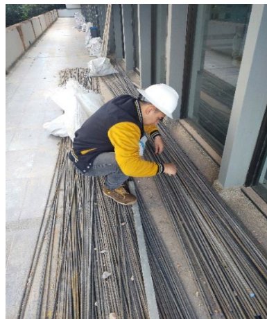
Ilustración 36 Verificación de La calidad del acero según la norma ASTM 706. Fuente: Propia.
