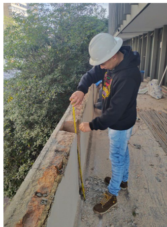
Ilustración 35 Antepecho con cortes para columnetas. Fuente: Propia.
