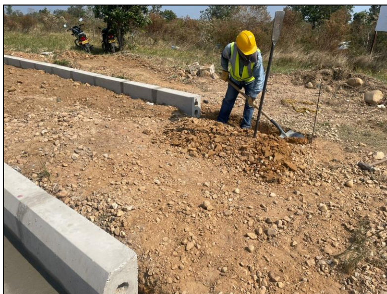
Ilustración 18 excavación manual en material común.
