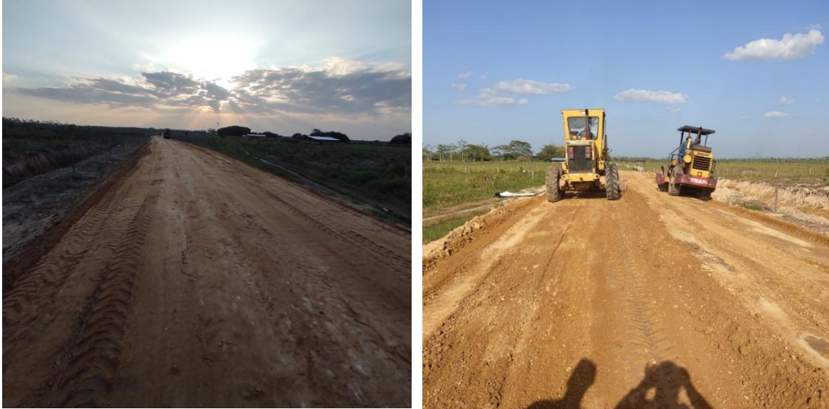
Ilustración 27, Nivelación y Conformación Terraplén
