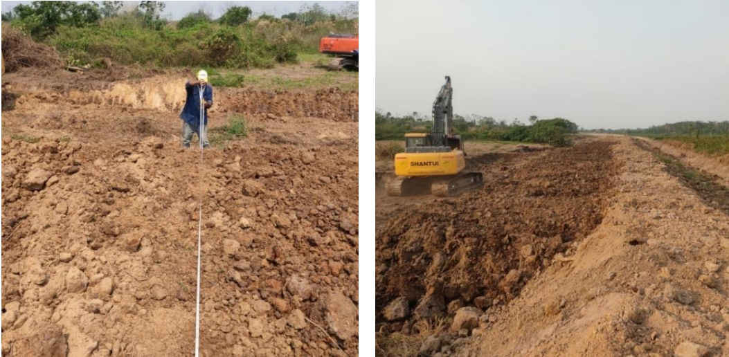
Ilustración 29, Toma de Medidas, Cantidades Ejecutadas
