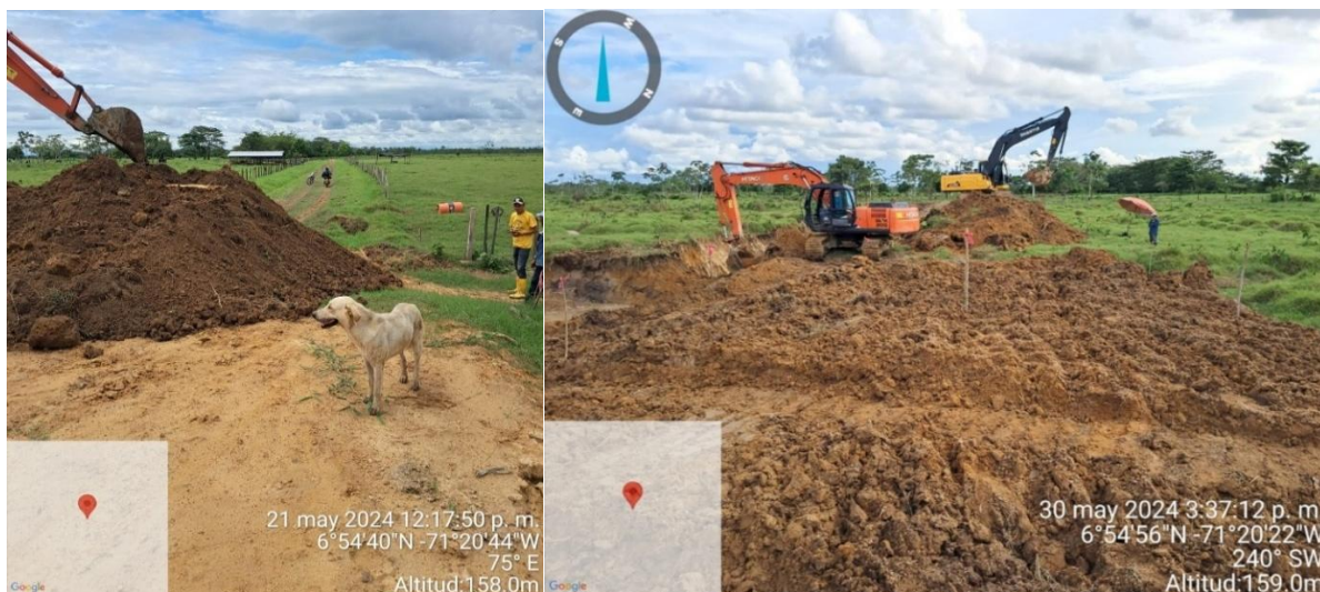
Ilustración 31, Construcción Canal y Conformación de Taludes
