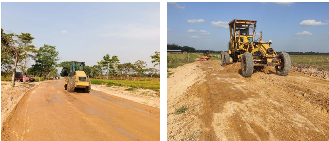
Ilustración 26, Ejecución Contrato No.270
