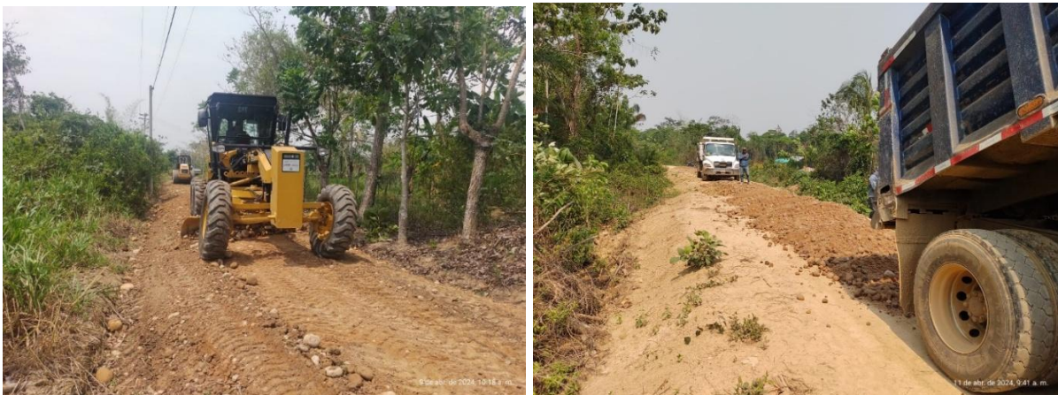
Ilustración 30, Subcontrato de Suministro No.020
