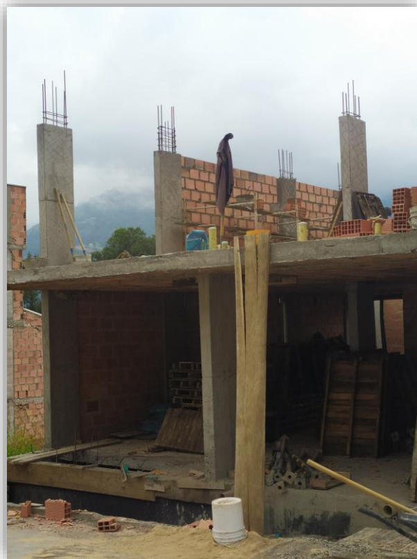
Ilustración 14 Casa lote 12 - manzana 2 proceso constructivo recibido por parte del aprendiz
