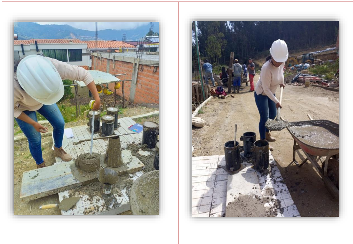
Ilustración 22 toma de asentamiento de concreto para placa de entepiso y recolección de probetas de concreto para análisis de resistencia
