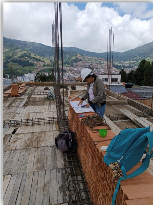
Ilustración 11 revisión de planos para aceros de refuerzo y arquitectónicos
