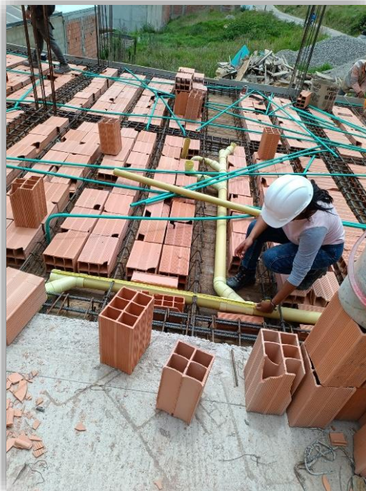
Ilustración 13 Supervisión y seguimiento a la distribución de tubería sanitaria
