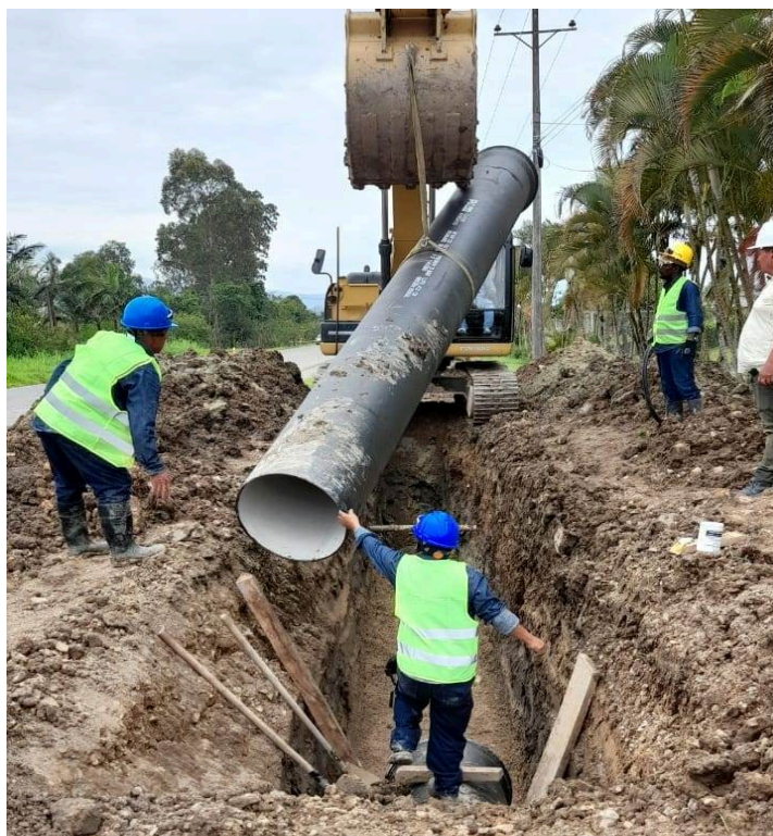
Ilustración 3. Reposición de tubería de agua planta Guatepín, Colombia
