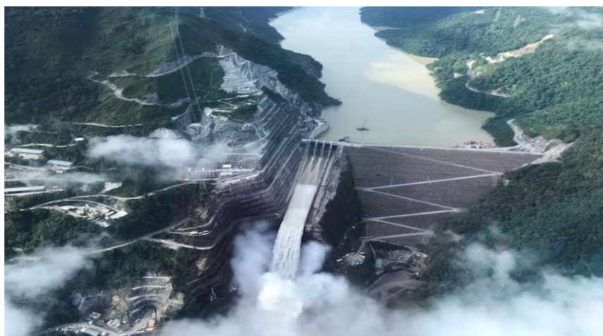
Ilustración 8. Proyecto Hidroeléctrico Ituango (Hidroituango). Antioquia, Colombia
