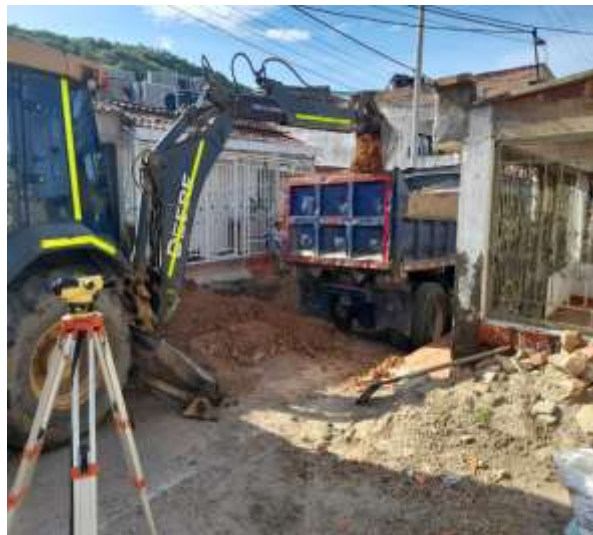
Ilustración 40. Imagen de campo, retiro de sobrantes y disposición final, avenida 8 entre calles 20b sur y 22 sur del barrio valles del mirador.
