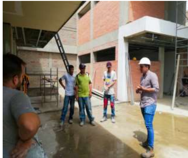
Ilustración 83. Imagen en campo, capacitación de elementos de seguridad en obras civiles a los auxiliares de construcción y oficiales.
