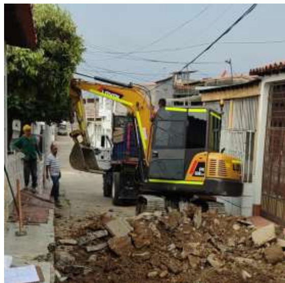
Ilustración 28. Imagen de campo, retiro de escombros en concreto cargue en retroexcavadora y volqueta.
