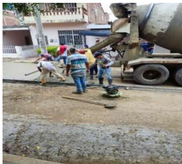
Ilustración 60. Imagen de campo, vaciado de concreto hidráulica calle 35 entre avenidas 7 y 10 del barrio la sabana
