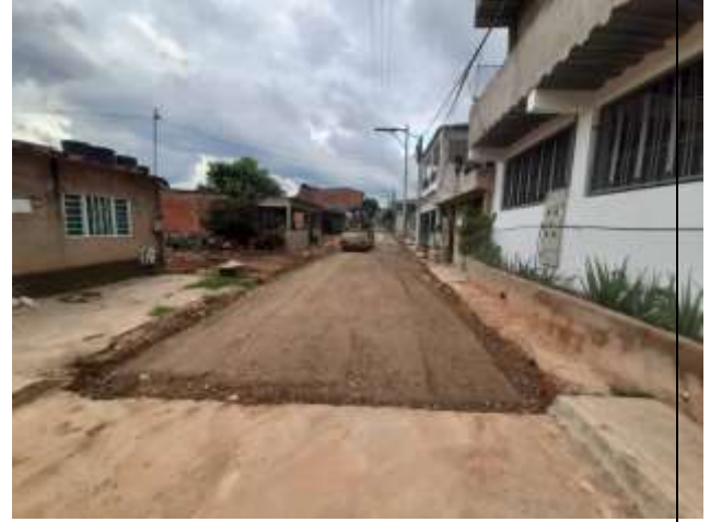
Ilustración 46. Imagen de campo, distribución del material granular de la base granular, avenida 8 entre calles 20b sur y 22 sur del barrio valles del mirador.
