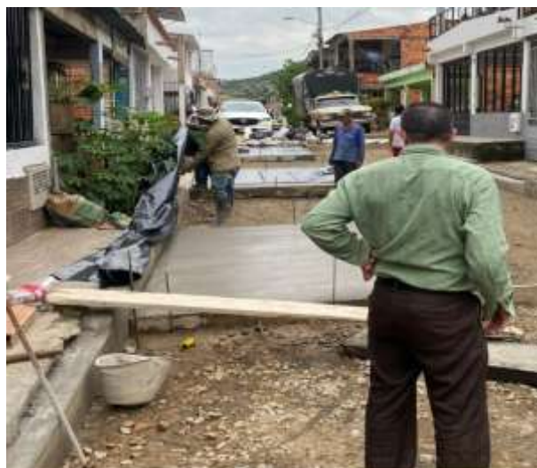
Ilustración 48. Imagen de campo, vaciado de concreto hidráulico de la avenida 8 entre calles 20b sur y 22 sur del barrio valles del mirador.
