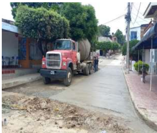
Ilustración 61. Imagen de campo, vaciado de concreto hidráulica calle 35 entre avenidas 7 y 10 del barrio la sabana
