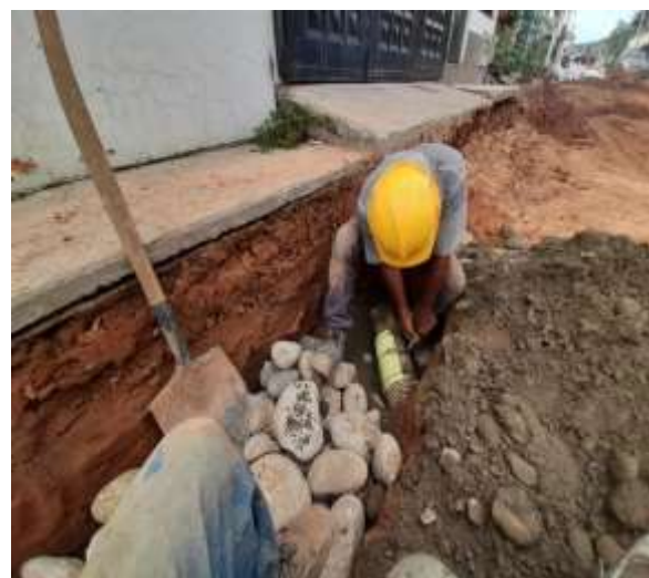
Ilustración 43. Imagen de campo, reparaciones domiciliarias de alcantarillado de la avenida 8 entre calles 20b sur y 22 sur del barrio valles del mirador.
