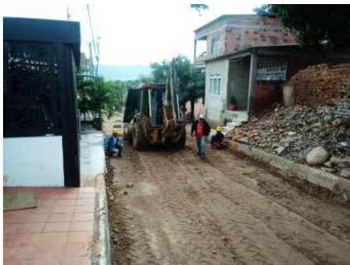
Ilustración 59. Imagen de campo, relleno y compactación de la sub base granular de la calle 35 entre avenidas 7 y 10 del barrio la sabana.
