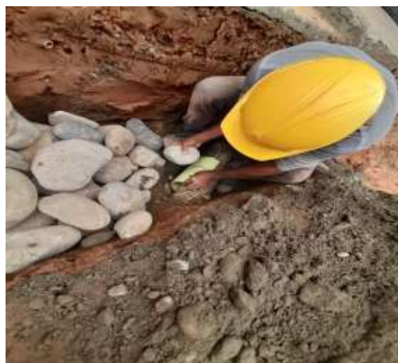
Ilustración 44. Imagen de campo, reparaciones domiciliarias de alcantarillado de la avenida 8 entre calles 20b sur y 22 sur del barrio valles del mirador.
