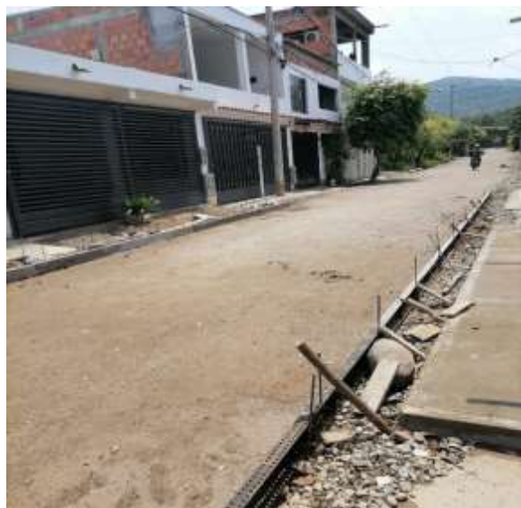
Ilustración 21. Imagen de campo, instalación de formaleta metálica.
