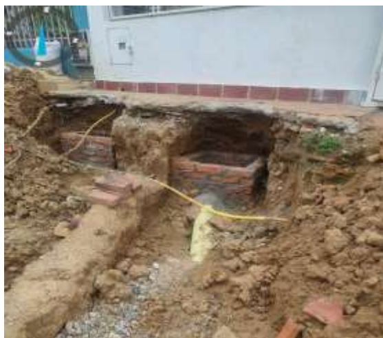
Ilustración 32. Imagen de campo, construcción de caja de inspección e instalación de tubería sanitaria.
