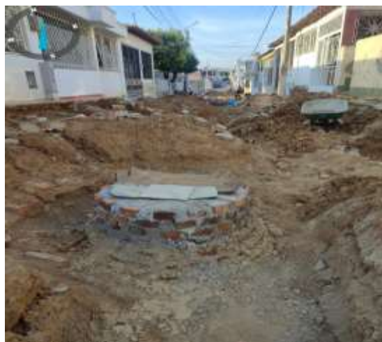
Ilustración 33. Imagen de campo, construcción de tercer pozo de inspección e instalación de tubería de 6" y 8".
