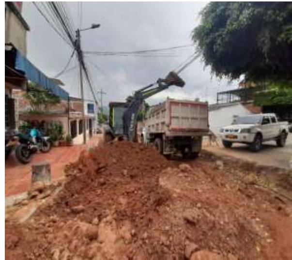
Ilustración 51. Imagen de campo, excavación mecánica en arcilla dura sin clasificar calle 35 entre avenidas 7 y 10 del barrio la sabana.
