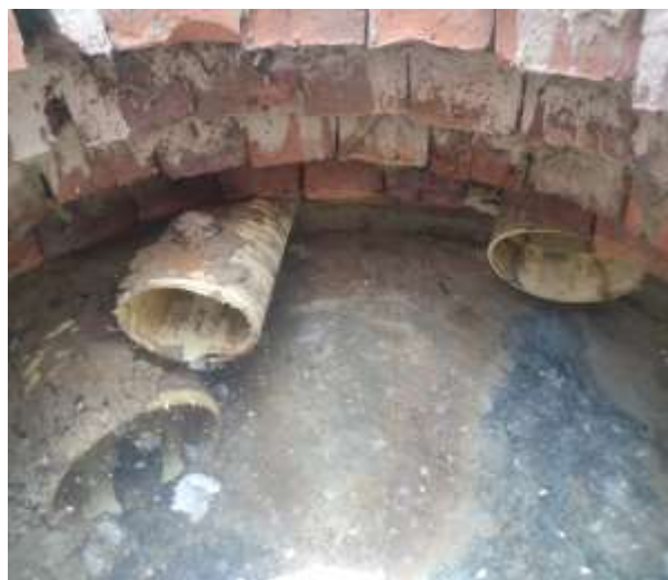
Ilustración 19. Imagen de campo, pruebas de estanqueidad y hermeticidad del barrio Tierra linda (Av. 6 entre calles 1 – 3)
