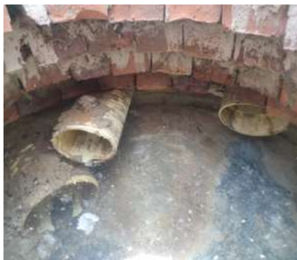
Ilustración 81. Imagen de campo, pruebas de estanqueidad y hermeticidad del barrio tierralinda (av 6 entre calles 1 – 3)
