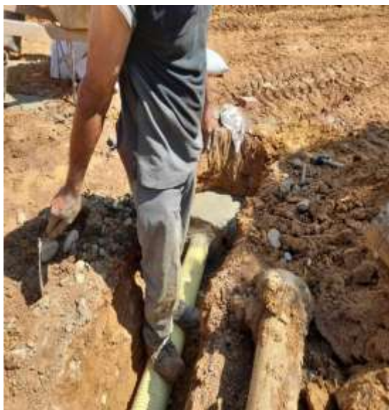
Ilustración 55. Imagen de campo, reparaciones domiciliarias de alcantarillado de la calle 35 entre avenidas 7 y 10 del barrio la sabana.
