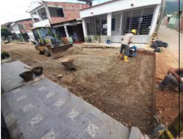
Ilustración 45. Imagen de campo, distribución del material granular de la base granular, avenida 8 entre calles 20b sur y 22 sur del barrio valles del mirador.
