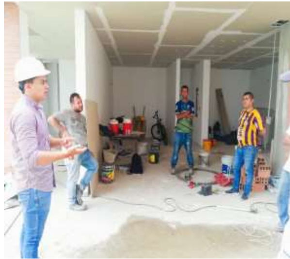
Ilustración 82. Imagen en campo, capacitación de elementos de seguridad en obras civiles a los auxiliares de construcción y oficiales.
