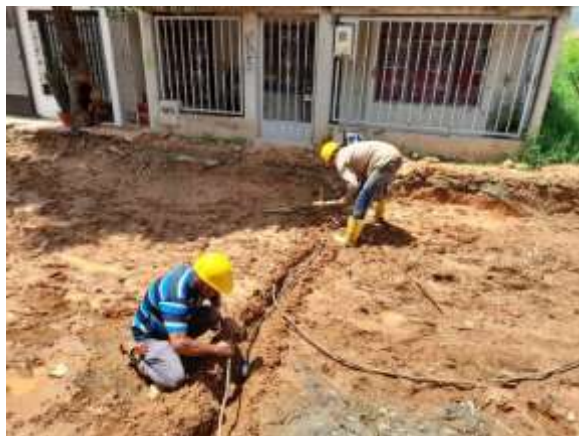
Ilustración 41. Imagen de campo, reparaciones domiciliarias de acueducto de la avenida 8 entre calles 20b sur y 22 sur del barrio valles del mirador.
