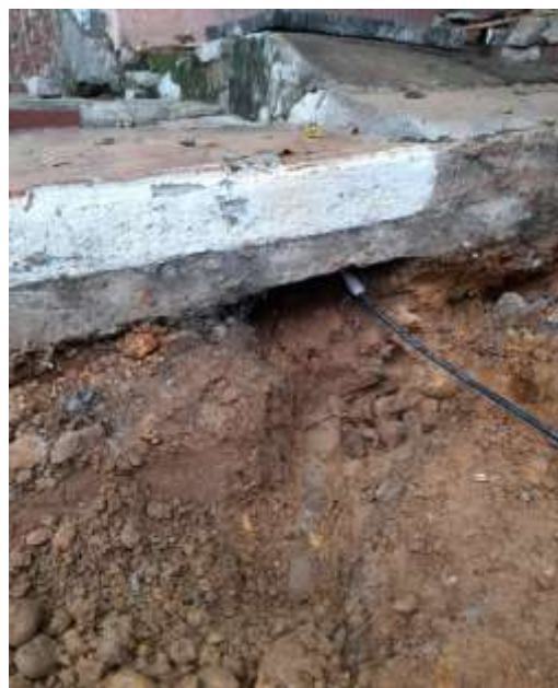
Ilustración 54. Imagen de campo, reparaciones domiciliarias de acueducto de la calle 35 entre avenidas 7 y 10 del barrio la sabana.
