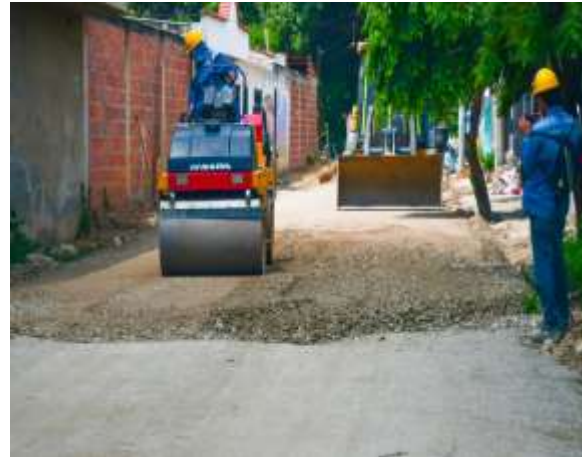
Ilustración 22. Imagen de campo distribución del material granular y capa de sub- base respectivamente compactada.
