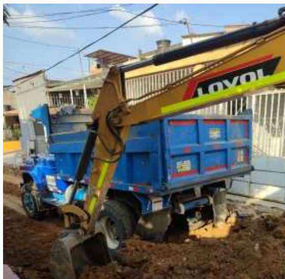
Ilustración 29. Imagen de campo, retiro de escombros cargue de material de subrasante en retroexcavadora y volqueta
