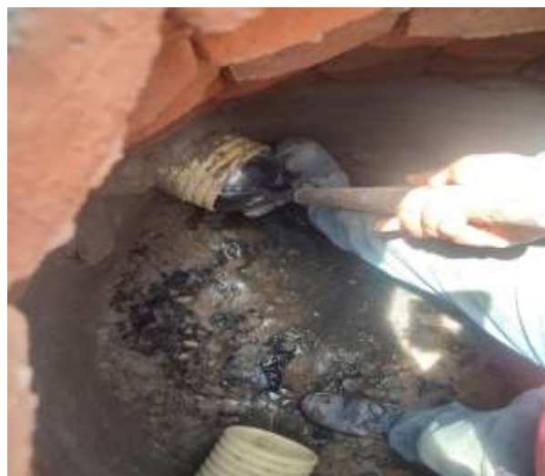
Ilustración 18. Imagen de campo, pruebas de estanqueidad y hermeticidad del barrio Tierra linda (Av. 6 entre calles 1 – 3)
