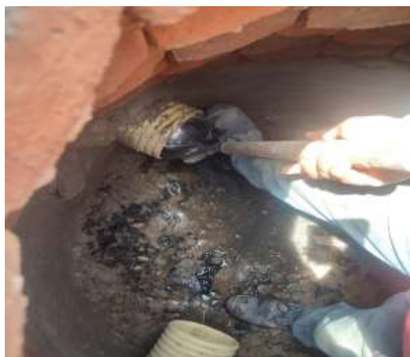
Ilustración 80. Imagen de campo, pruebas de estanqueidad y hermeticidad del barrio tierralinda (av 6 entre calles 1 – 3)
