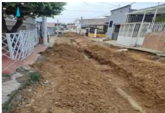
Ilustración 30. Imagen de campo, excavación manual de retiro de tubería antigua.
