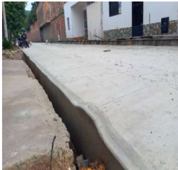
Ilustración 2622. Imagen de campo, vaciado de concreto hidráulico.
