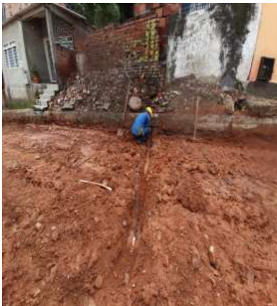
Ilustración 53. Imagen de campo, reparaciones domiciliarias de acueducto de la calle 35 entre avenidas 7 y 10 del barrio la sabana.
