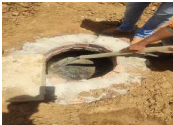
Ilustración 79. Imagen de campo, pruebas de estanqueidad y hermeticidad del barrio tierralinda (Av 6 entre calles 1 – 3)
