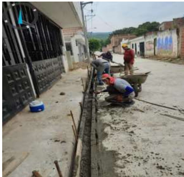
Ilustración 25. Imagen de campo, vaciado de concreto hidráulico.
