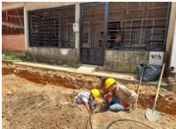
Ilustración 42. Imagen de campo, reparaciones domiciliarias de acueducto de la avenida 8 entre calles 20b sur y 22 sur del barrio valles del mirador.
