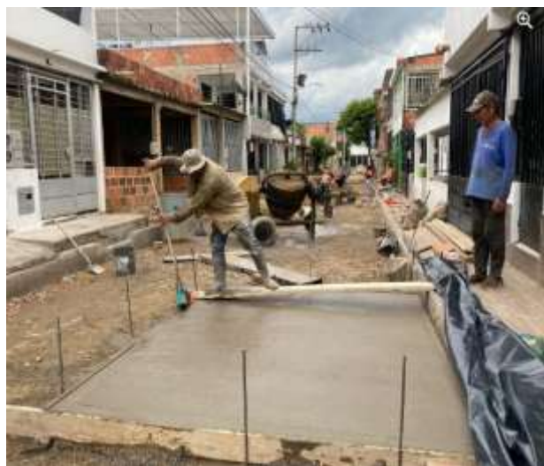
Ilustración 47. Imagen de campo, vaciado de concreto hidráulico de la avenida 8 entre calles 20b sur y 22 sur del barrio valles del mirador.
