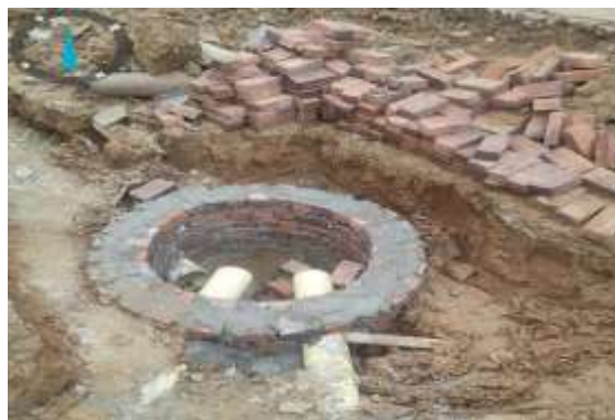
Ilustración 31. Imagen de campo, construcción inicial del segundo pozo de inspección y reparación de domiciliarias de alcantarillado de 6" y 8".
