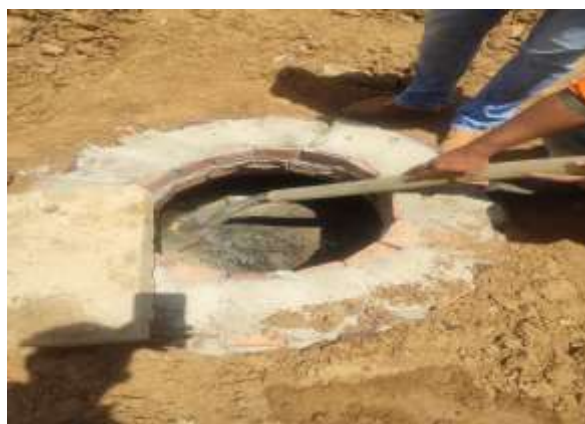
Ilustración 17. Imagen de campo, pruebas de estanqueidad y hermeticidad del barrio Tierra linda (Av. 6 entre calles 1 – 3)
