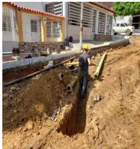
Ilustración 56. Imagen de campo, reparaciones domiciliarias de alcantarillado de la calle 35 entre avenidas 7 y 10 del barrio la sabana.
