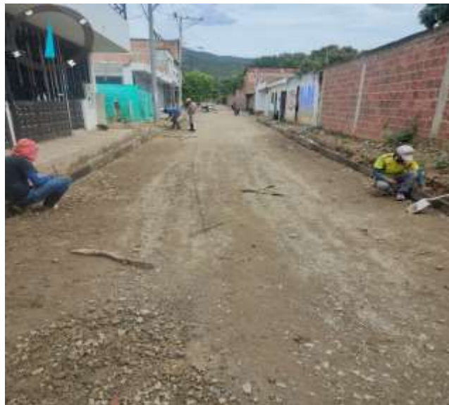
Ilustración 24. Imagen de campo, instalación de formaleta metálica.
