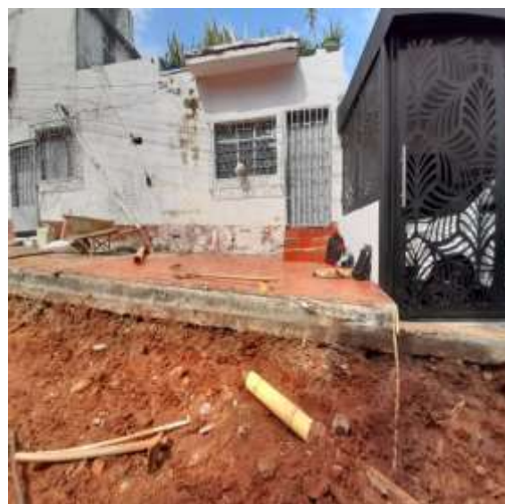
Ilustración 58. Imagen de campo, reparaciones domiciliarias de alcantarillado de la calle 35 entre avenidas 7 y 10 del barrio la sabana.
