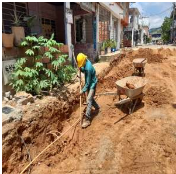
Ilustración 37. Imagen de campo, excavación manual de la avenida 8 entre calles 20b sur y 22 sur del barrio valles del mirador.
