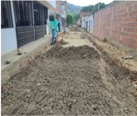
Ilustración 21. Imagen de campo, distribución del material granular de la base granular antes de ser compactado.
