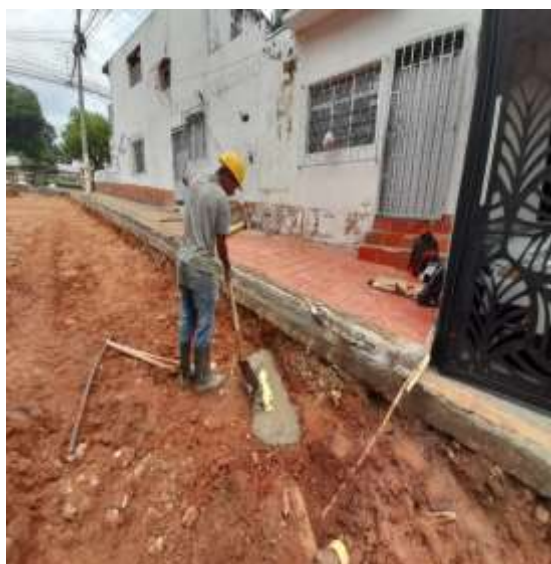
Ilustración 57. Imagen de campo, reparaciones domiciliarias de alcantarillado de la calle 35 entre avenidas 7 y 10 del barrio la sabana.
