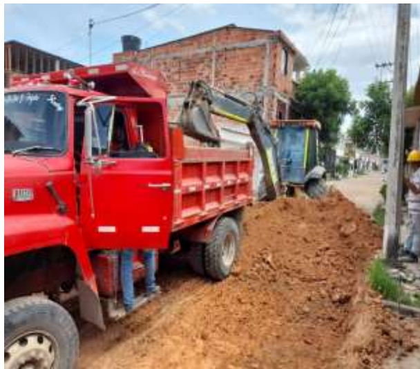
Ilustración 39. Imagen de campo, retiro de sobrantes y disposición final, avenida 8 entre calles 20b sur y 22 sur del barrio valles del mirador.
