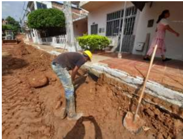
Ilustración 52. Imagen de campo, excavación manual en arcilla dura sin clasificar calle 35 entre avenidas 7 y 10 del barrio la sabana.
