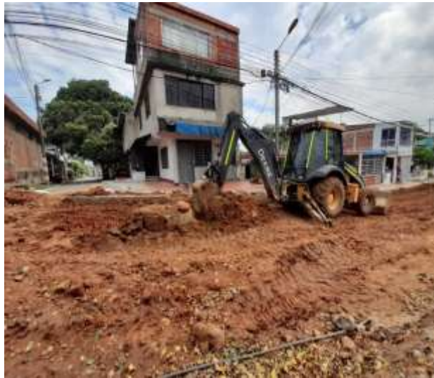
Ilustración 50. Imagen de campo, excavación mecánica en arcilla dura sin clasificar calle 35 entre avenidas 7 y 10 del barrio la sabana.
