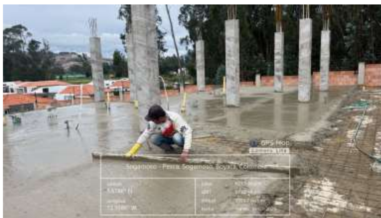
Ilustración 20. Fundida de placa de cimentación.
