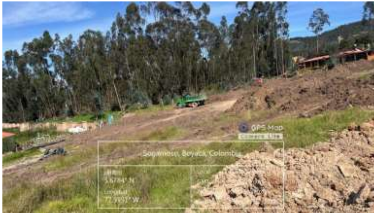
Ilustración 10. Descapote y limpieza de terreno
