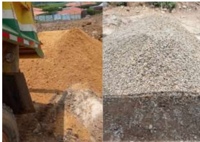
Ilustración 38. Identificación de agregados no adecuados para el diseño de mezcla.
