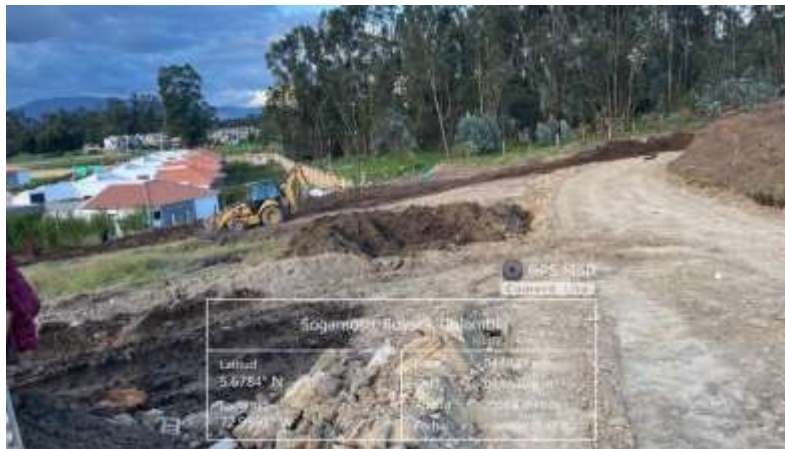
Ilustración 11. Excavación mecánica de terreno.
