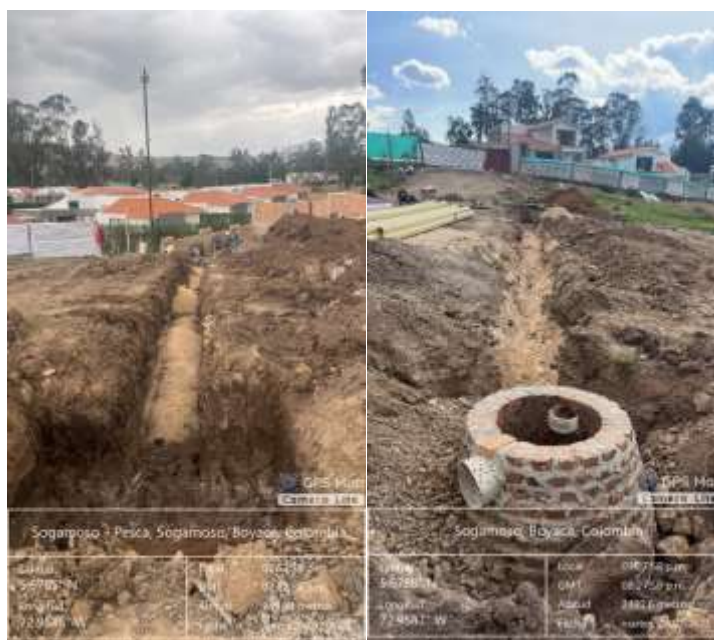
Ilustración 13. Construcción de alcantarillado
