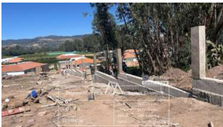
Ilustración 12. Construcción muro de cerramiento perimetral.
