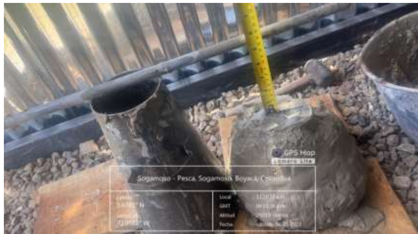
Ilustración 28. Ensayo asentamiento del concreto.
