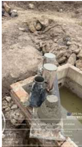
Ilustración 31. Elaboración de pruebas de cilindros de concreto.
