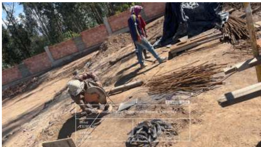
Ilustración 16. Corte y figurado de acero para cimentación
