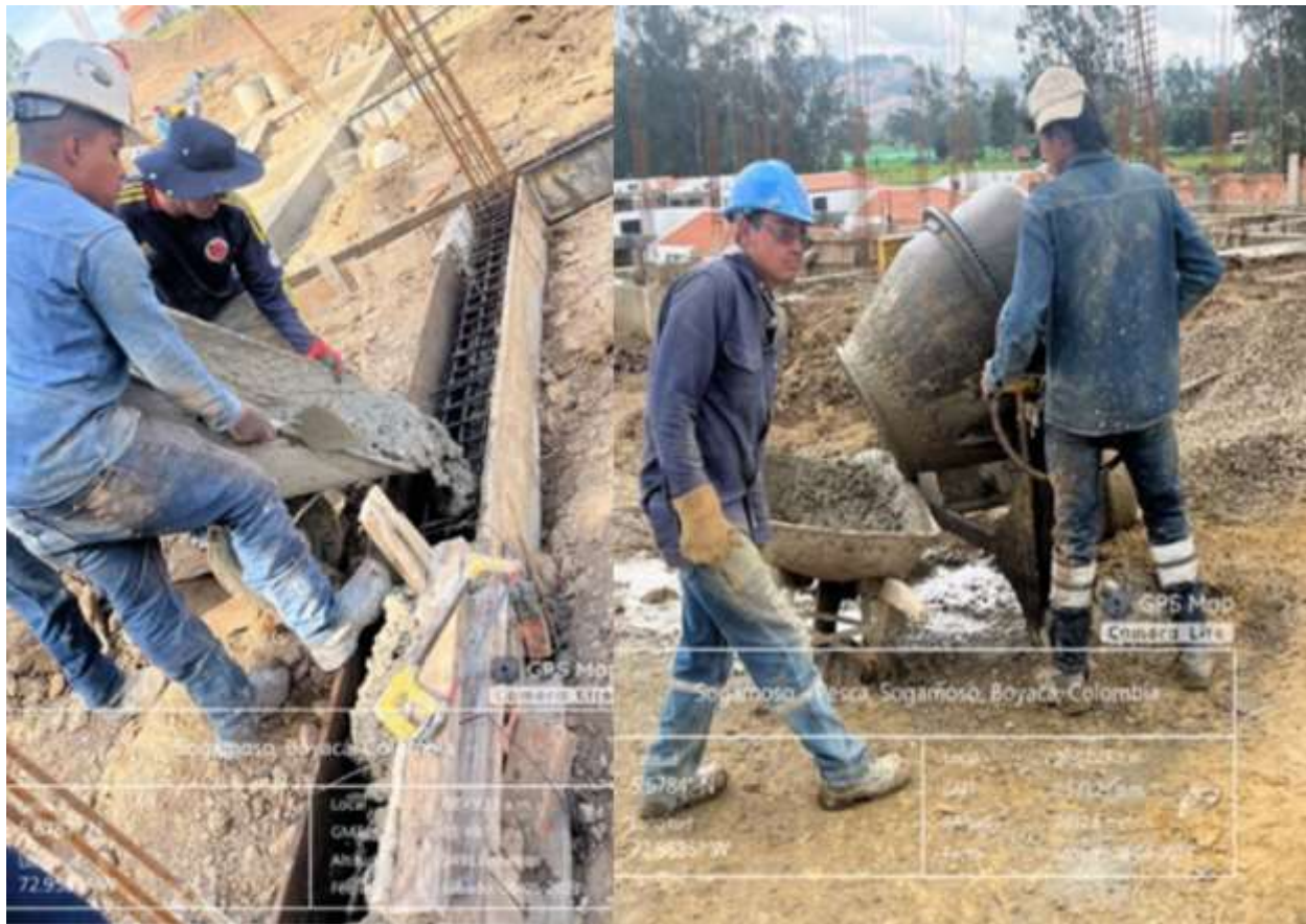
Ilustración 30. Mezclado y vaciado de la mezcla de concreto.
