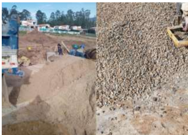
Ilustración 37. Identificación de agregados para la mezcla de concreto.
