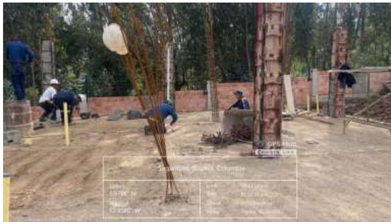
Ilustración 19. Encofrado y fundida de concreto en columnas.
