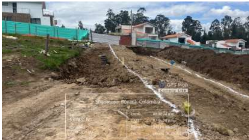
Ilustración 14. Localización y replanteo de vías.
